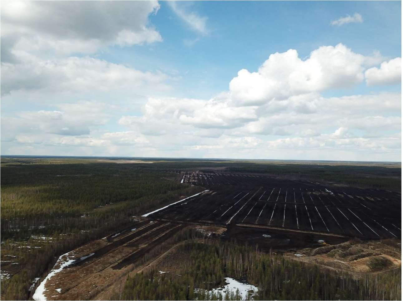
Kuva 20. Ilmakuva, korkeus 110 m. Hankealueen keskiosa ja Ison Rytisuon turvetuotantoalue, kuvattu pohjoiseen.
