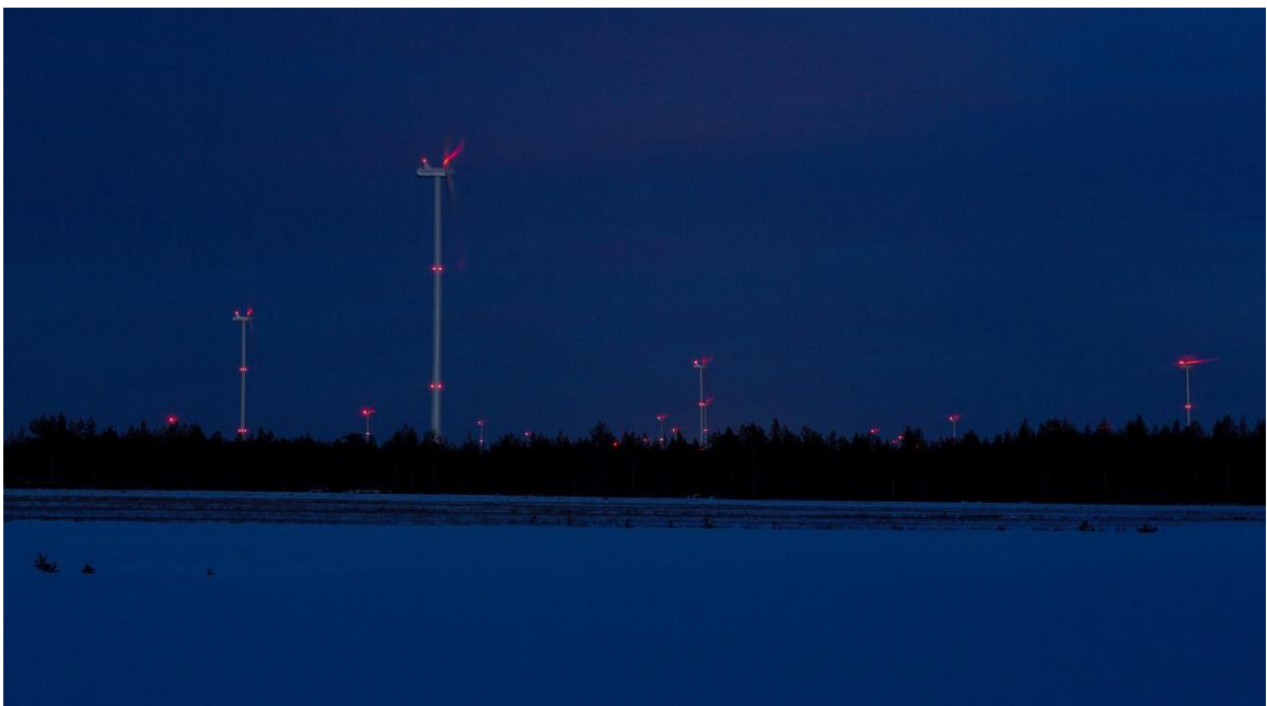
Kuva 2.15. Kiinteät punaiset lentoestevalot. (Kuva: Ville Suorsa, FCG)
