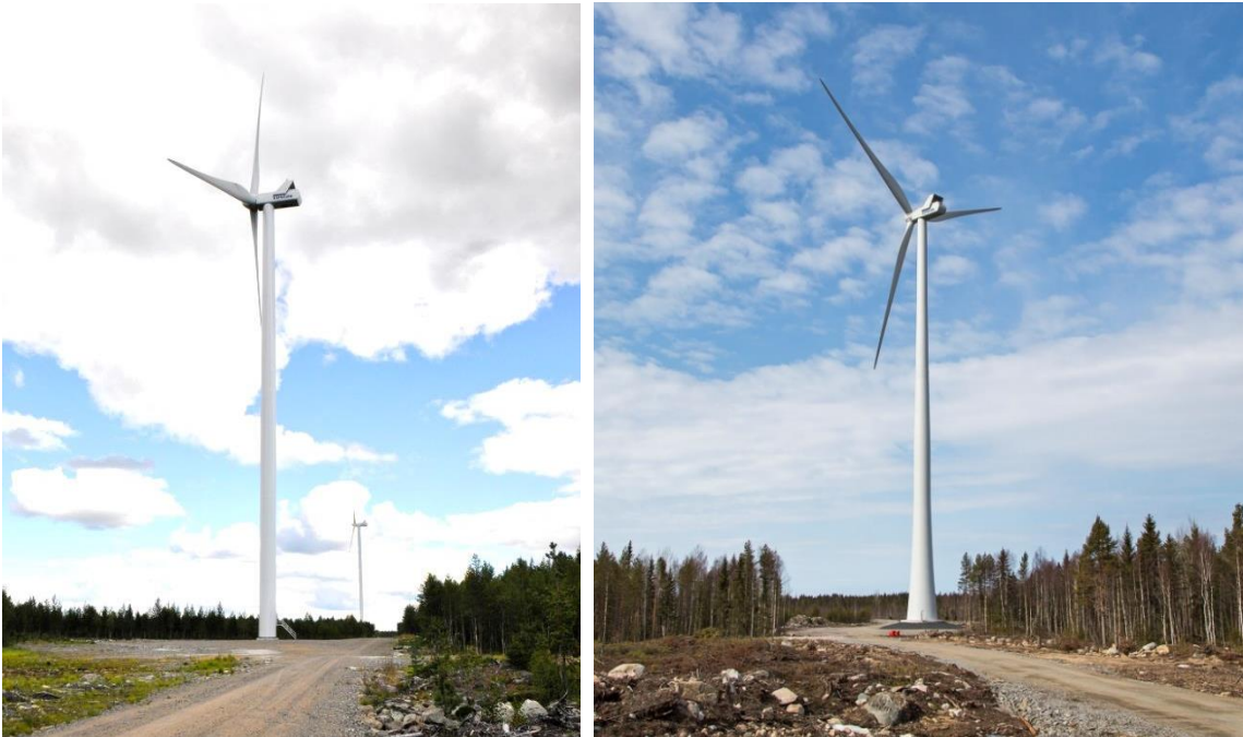
Kuva 2.13. Vasemalla on esimerkki teräslieriötornista ja oikealla hybriditornista. (Kuvat: Leila Väyrynen ja Ville Suorsa, FCG)
