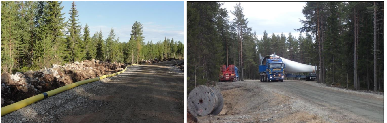
Kuva 2.17. (Vasemmalla) Esimerkki tuulivoimapuiston rakennus- ja huoltotiestä rakentamisaikana. Teitä käytetään muun muassa betonin, soran ja voimaloiden komponenttien kuljetuksiin sekä tuulivoimapuiston käyttövaiheessa huoltoajoihin. Maakaapeli sijoitetaan ojakaivantoon tien reuna-alueelle. (Oikealla) Tuulivoimalan osia kuljetetaan erikoiskuljetuksina. (Kuvat: Ville Suorsa / FCG).
