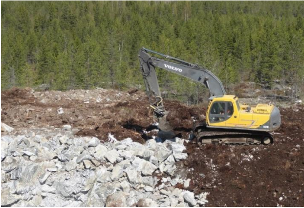
Kuvapari 2.19. Tuulivoimapuiston rakentaminen alkaa huoltoteiden ja pystytysalueiden rakentamisella (kuvat: Ville Suorsa, FCG).
