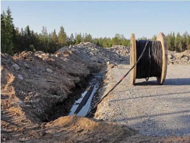
Kuvapari 2.20. Maakaapelit upotetaan huoltoteiden yhteyteen (kuvat: Ville Suorsa/FCG).
