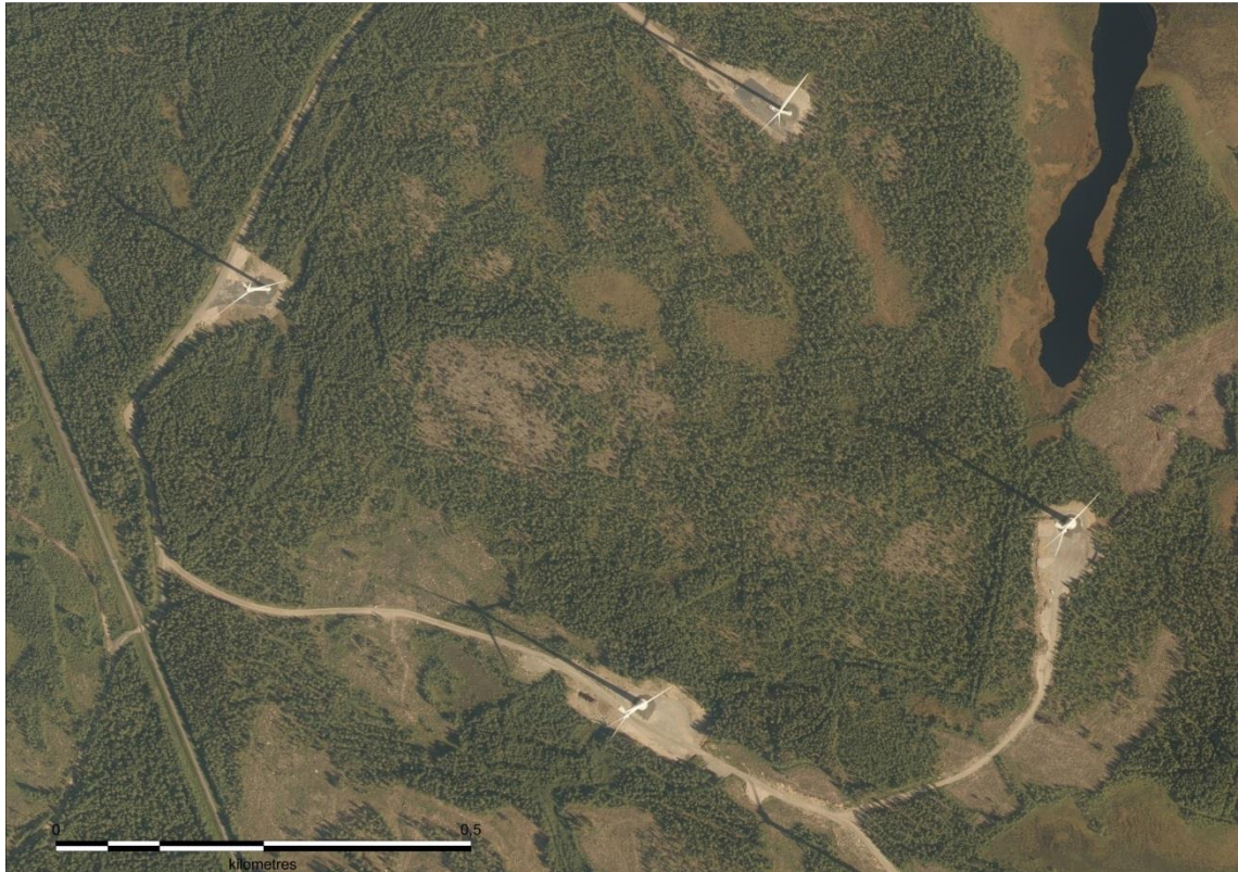
Kuva 2.12. Ilmakuvassa näkyy toiminnassa olevia tuulivoimaloita. Tuulivoimaloita varten on rakennettu huoltotiet ja nostokentät. Tuulivoimaloiden ympäristössä ja välialueilla aikaisempi maankäyttö on säilynyt ennallaan.
