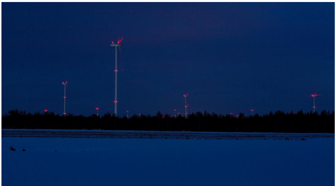
Kuva 2.15. Kiinteät punaiset lentoestevalot. (Kuva: Ville Suorsa, FCG)
