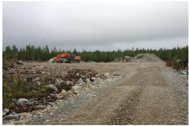
Kuvapari 2.19. Tuulivoimapuiston rakentaminen alkaa huoltoteiden ja pystytysalueiden rakentamisella (kuvat: Ville Suorsa, FCG).
