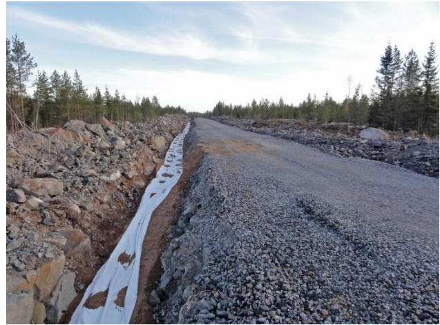
Kuvapari 2.20. Maakaapelit upotetaan huoltoteiden yhteyteen (kuvat: Ville Suorsa/FCG).
