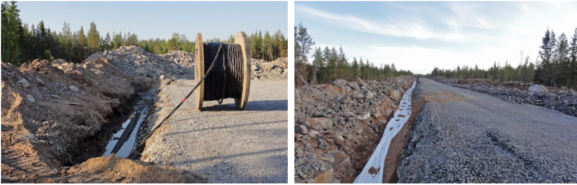
Kuvapari 2.14. Maakaapelit upotetaan huoltoteiden yhteyteen (kuvat: Ville Suorsa/FCG).
