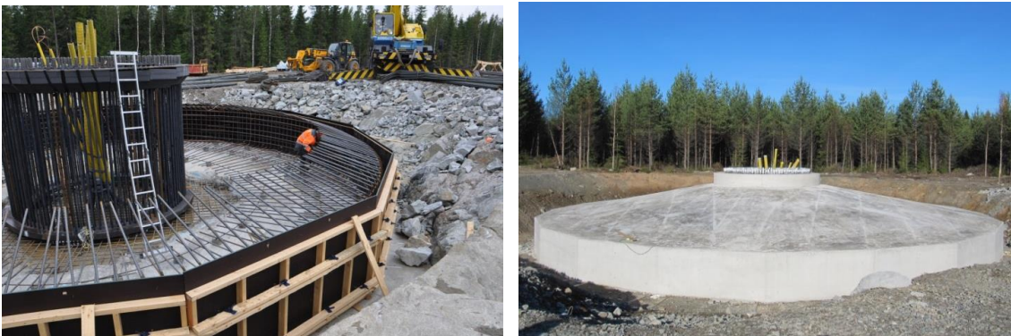
Kuvapari 2.15. Tuulivoimalan perustusten rakentamista. (Kuvat: Leila Väyrynen, FCG)
