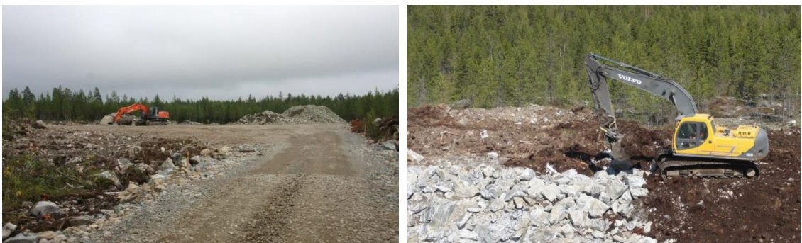
Kuvapari 2.13. Tuulivoimapuiston rakentaminen alkaa huoltoteiden ja pystytysalueiden rakentamisella (kuvat: Ville Suorsa, FCG).
