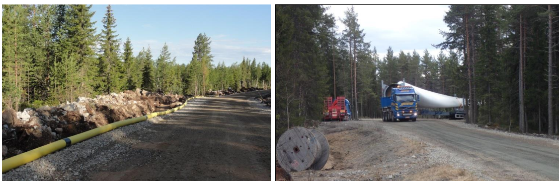
Kuva 2.12. (Vasemmalla) Esimerkki tuulivoimapuiston rakennus- ja huoltotiestä. Teitä käytetään muun muassa betonin, soran ja voimaloiden komponenttien kuljetuksiin sekä tuulivoimapuiston käyttövaiheessa huoltoajoihin. Maakaapeli sijoitetaan ojakaivantoon tien reuna-alueelle. (Oikealla) Tuulivoimalan osia kuljetetaan erikoiskuljetuksina. (Kuvat: Ville Suorsa / FCG).
