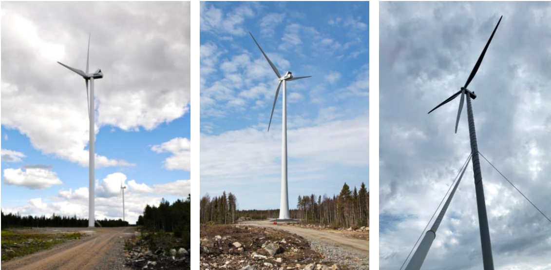
Kuva 2.8. Vasemmalla on esimerkki teräslieriötornista, keskellä hybriditornista ja oikealla harustetusta tornista. (Kuvat: Leila Väyrynen ja Ville Suorsa, FCG sekä Jarkko Finnilä, Carelin)
