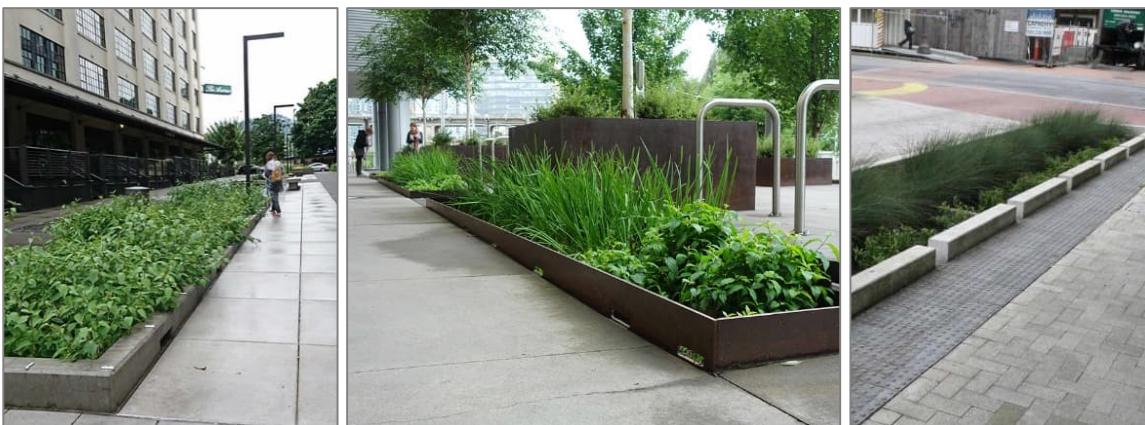
Kuva 11. Esimerkkejä katualueen vesiä käsittelevistä istutuskaistoista. (Kuvat: VirMa tutkimusryhmän blogi, sekä Alice Webb landperspectives.com.)
