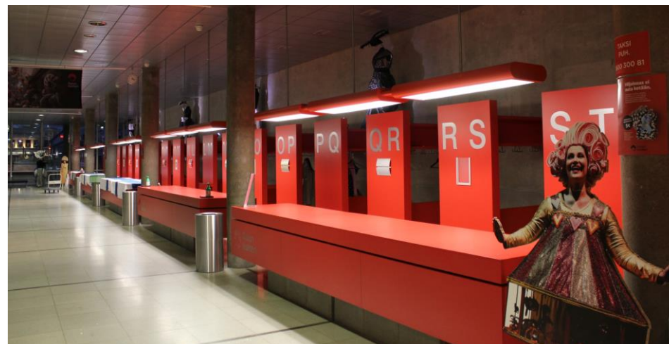
Vaatesäilytyksen kalusteet on uusittu peruskorjauksen yhteydessä. Uudet kalusteet ovat pääosin vanhojen rekonstruktioita. Tiskien ja naulakoiden betonijalustat ovat alkuperäiset.
