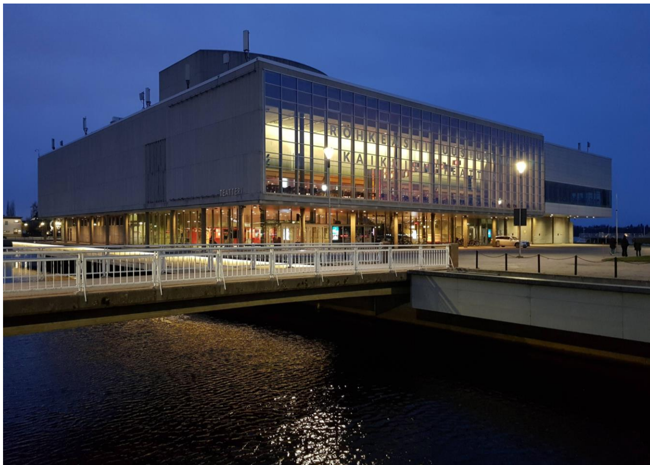
Oulun kaupunginteatteri syksyllä 2021. Teatteritalon pohjakerros on Kaarlenaukion puolelta pääosin lasia, mikä luo aiheettoman vaikutelman. Pimeänä aikana sisätilat erottuvat ulos lämpimän sävynä ja houkuttelevina. Torin puolella umpinainen betoniseinä muodostaa lasipintojen läpinäkyvyyttä korostavan kontrastin.
