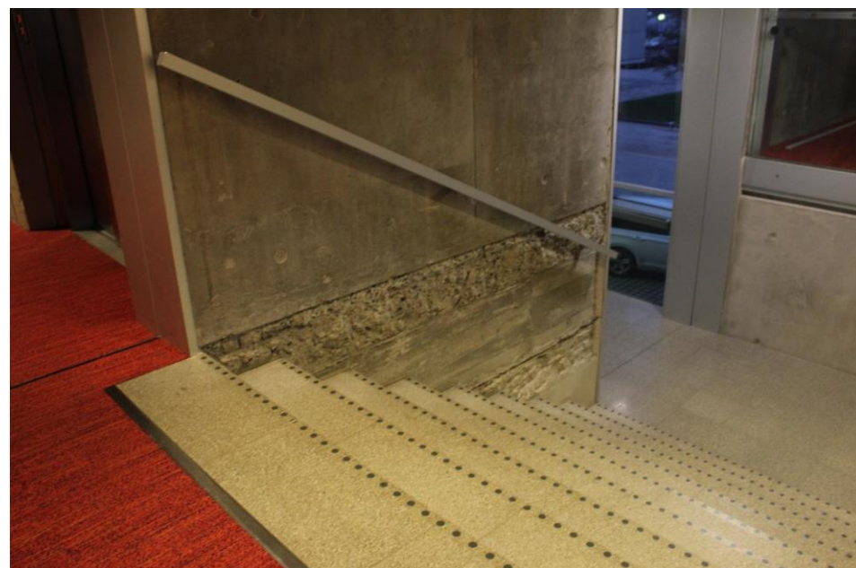
Vanhan ja uuden rakennuksen välinen raja näkyy portaikossa, kohdassa, jossa vanhaa välipohjaa on purettu pois portaan paikalta.
