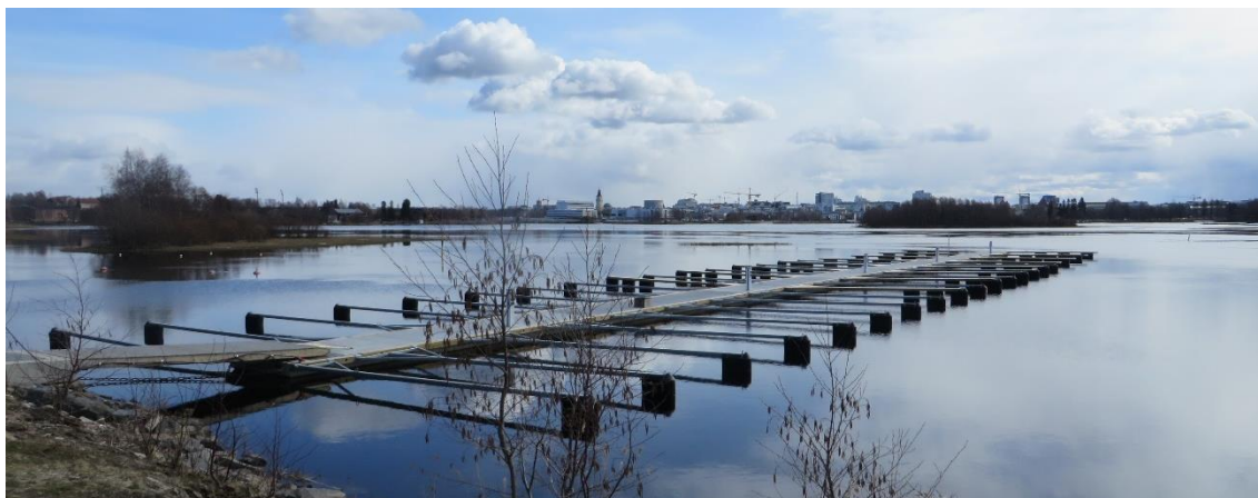
Kuva 36. Näkymä Hietasaaren veneilykeskuksen suunnasta kohti Oulun keskustaa. Kuvauspiste 27.
