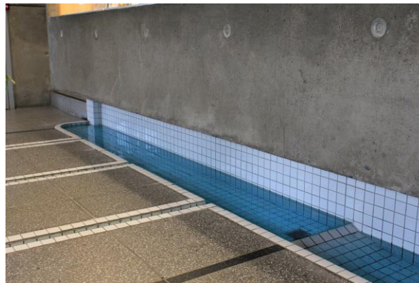
Ala-aulan ja pääportaan askelmat ovat mosaiikkibetonia, ja seinät ja kaiteet betonia.
