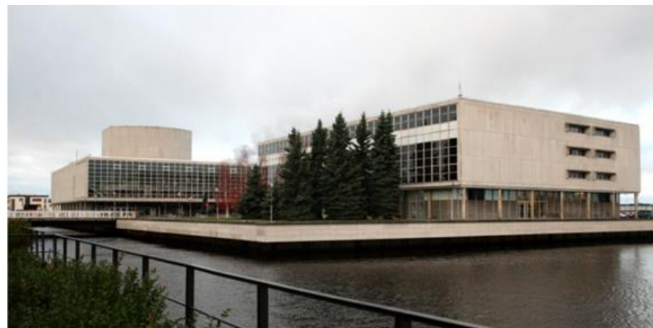
Kirjasto ja teatteri ennen ikkunoiden vaihtamista vuonna 2012. (kuva: Arkkitehtitoimisto Pia Krogius).
