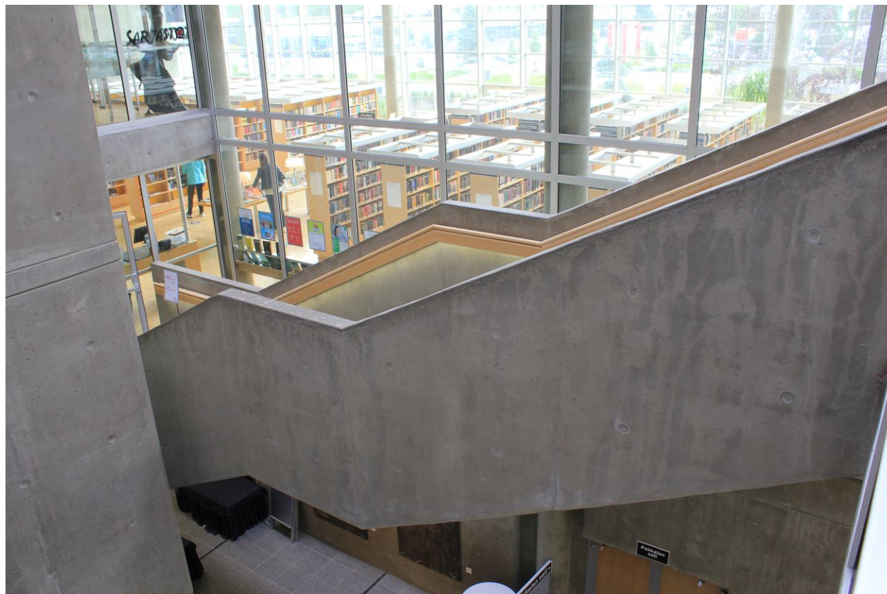
Veistoksellisissa betonipinnoissa näkyvät sekä alkuperäiset valutyön jäljet että ajan tuoma patina.
