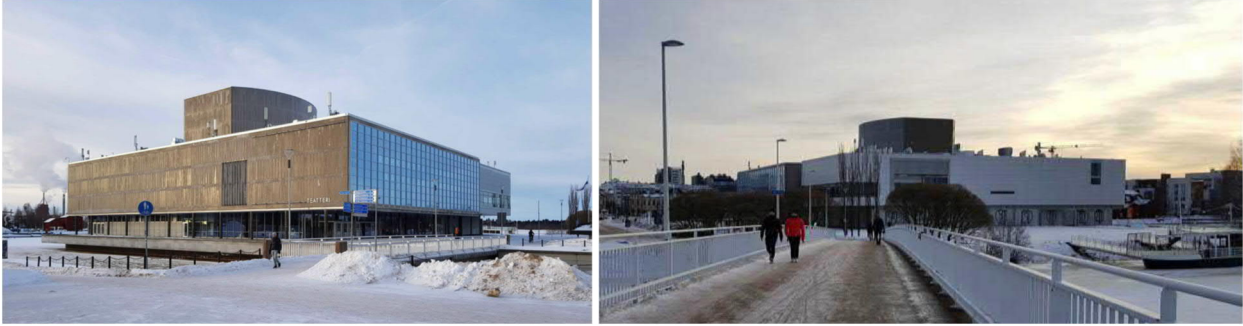
Kuvat 12 ja 13. Oulun kaupunginteatteri kuvattuna Pikisaaren ja torinrannan suunnista. Kuvat: rakennushistoriaselvitys.
