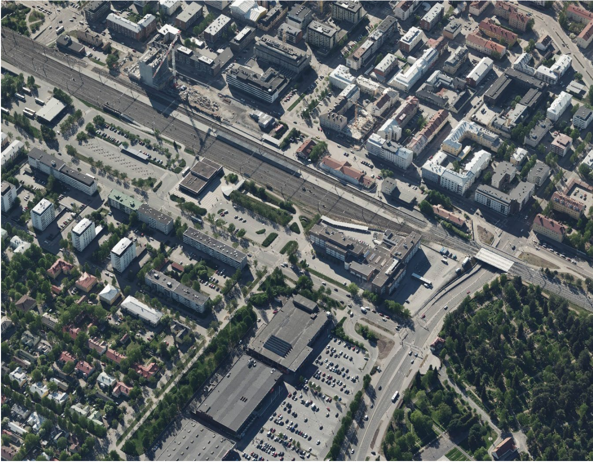
Kuva 4. Vuoden 2018 viistoilmakuva alueelta. Kuvassa suunnittelualueella näkyy vielä oikeus- ja poliisitalo, joka on purettu vuonna 2023. © Oulun kaupunki
