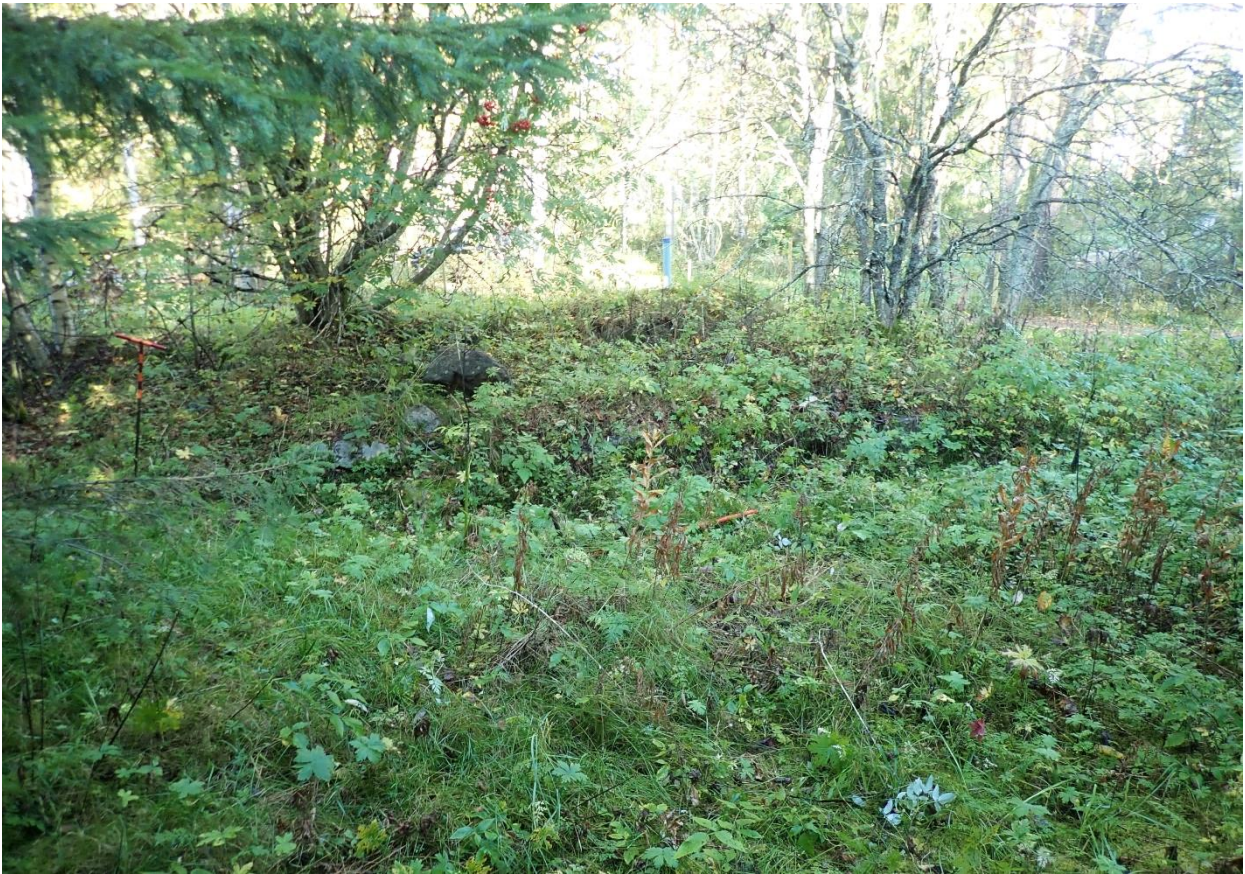
Kuva 98. Rakennuksen perustus Kamulan tontilla. Kuva: Arttu Tokoi.
