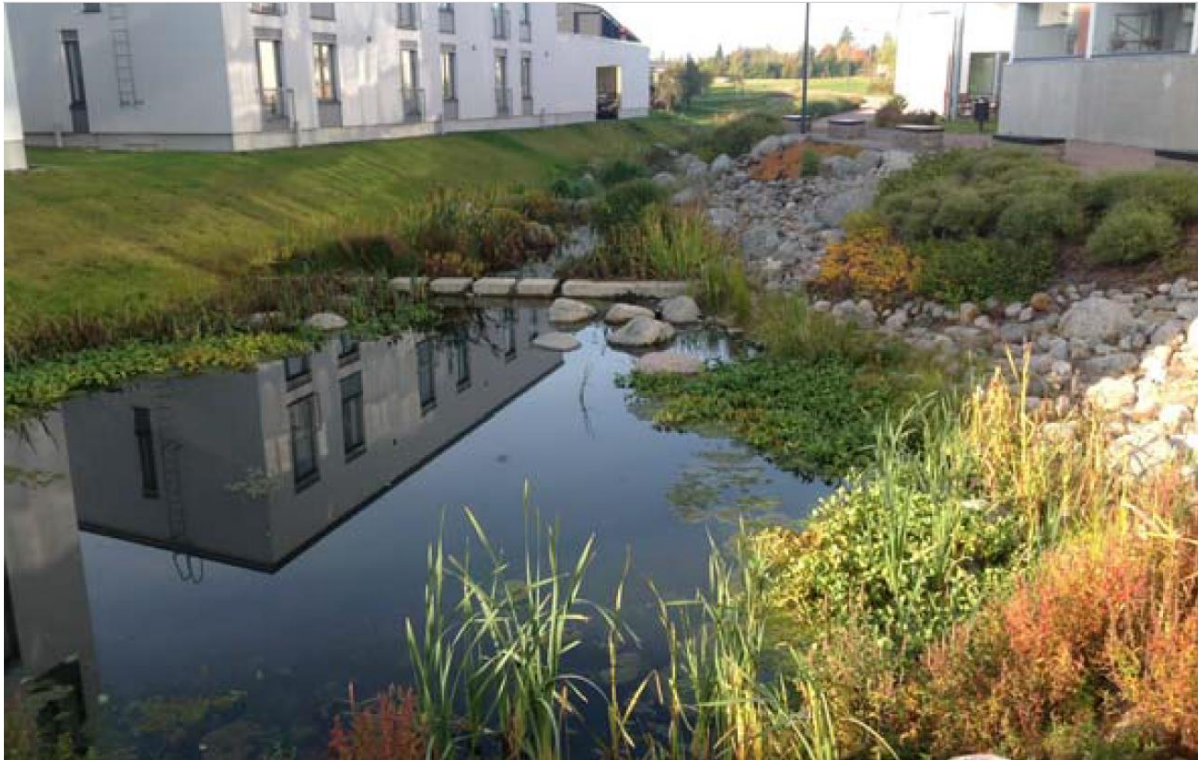
Kuva 7. Biosuodattava hulevesipainanne/kosteikko voi olla osan aikaa vuodesta kuivana, joten kasvit on valittava sen mukaisesti, että ne kestävät vesipinnan vaihteluita. Kuva: Vantaanjoen ja Helsingin seudun vesiensuojeluyhdistys ry.
