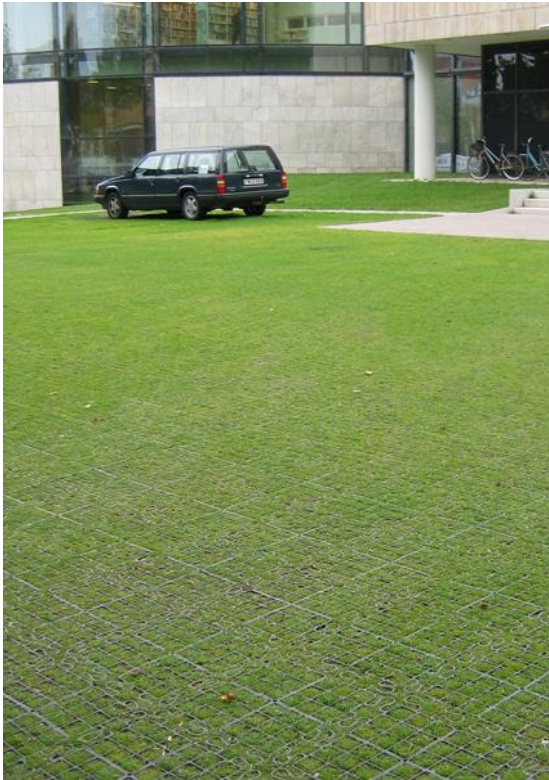
Kuva 4. Muovisella vahvikekennolla tuettuja pysäköintialueita. Kennoa voidaan käyttää vahvistamaan sorapintaa (oikea kuva) tai kenno voidaan vähemmän liikennöidyllä alueella nurmettaa (vasen kuva).
