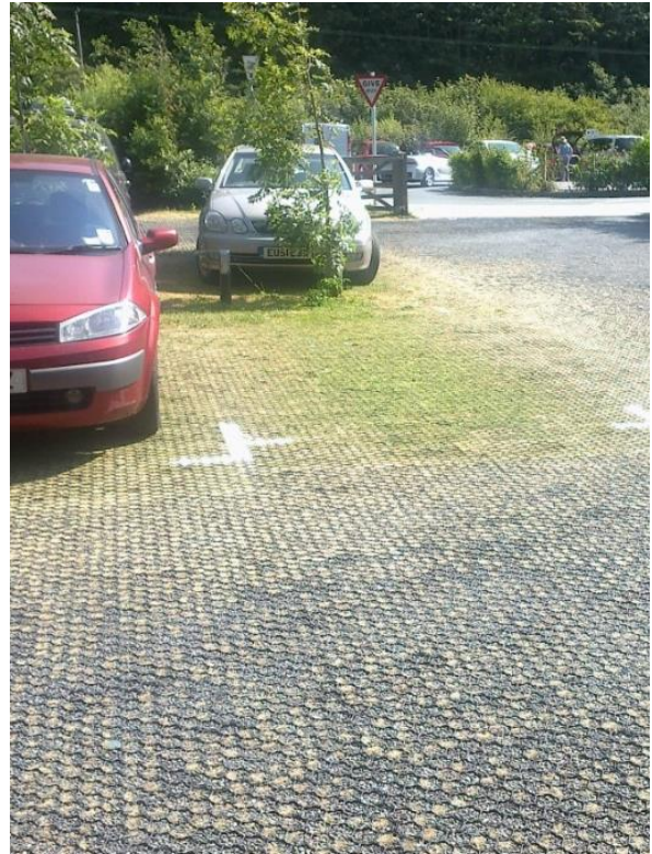
Kuva 4. Muovisella vahvikekennolla tuettuja pysäköintialueita. Kennoa voidaan käyttää vahvistamaan sorapintaa (oikea kuva) tai kenno voidaan vähemmän liikennöidyllä alueella nurmettaa (vasen kuva).
