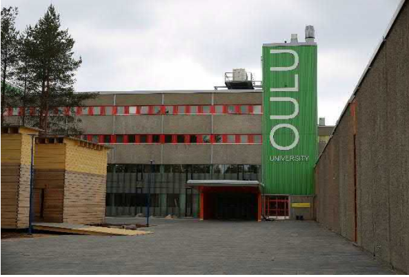
Kuva 54. Oulun yliopiston uusi pääsisäänkäynti.
