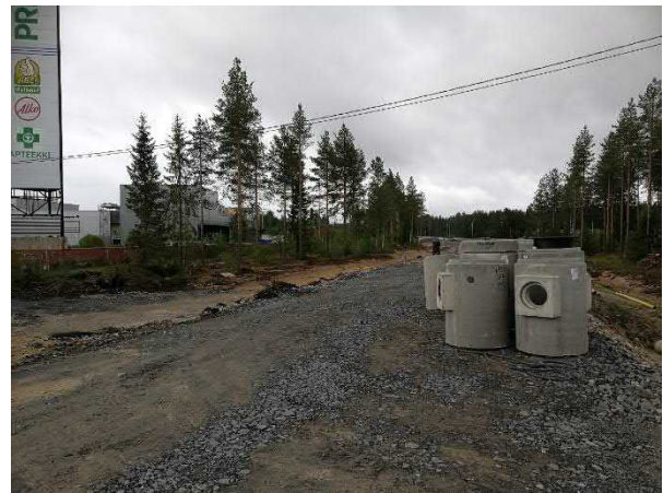
Kuva 19. Tietyömaata moottoritien ja Prisman välisellä alueella.
