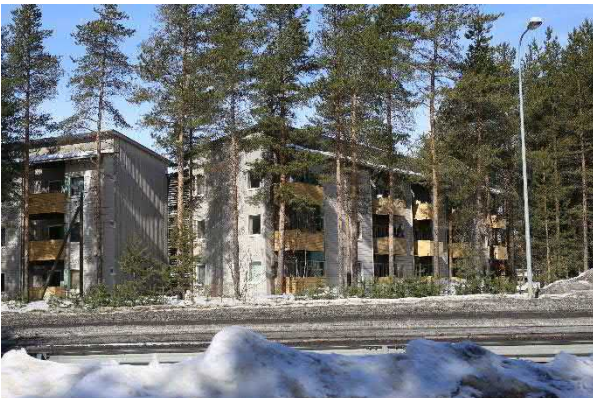
Kuva 57. Puurakentamista Kaijoharjun keskussa.
