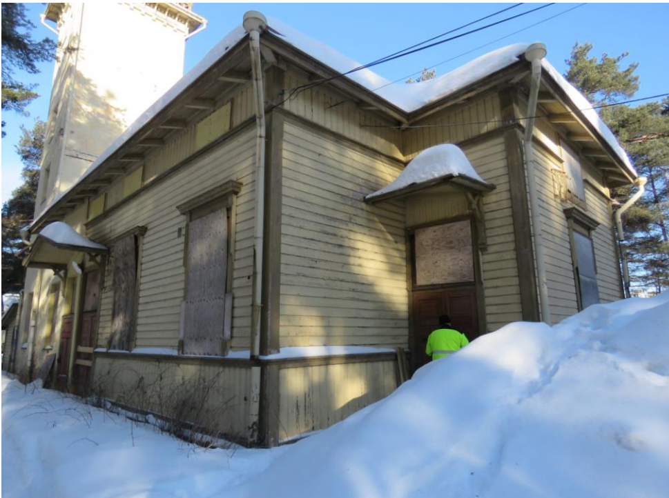
Kuva 6. Entinen laboratoriorakennus, kohde 5 (O-P.S: 27.3.2018).
