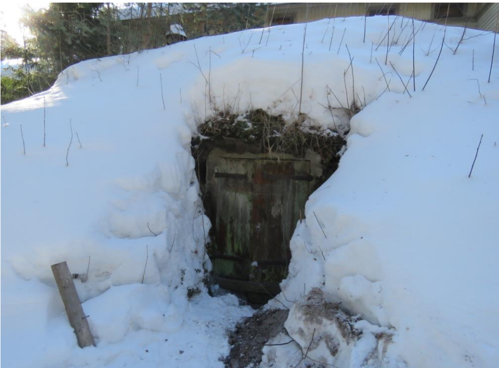
Kuva 9. Vanha maakellari, kohde 6, ulko-ovi (O-P.S: 27.3.2018).
