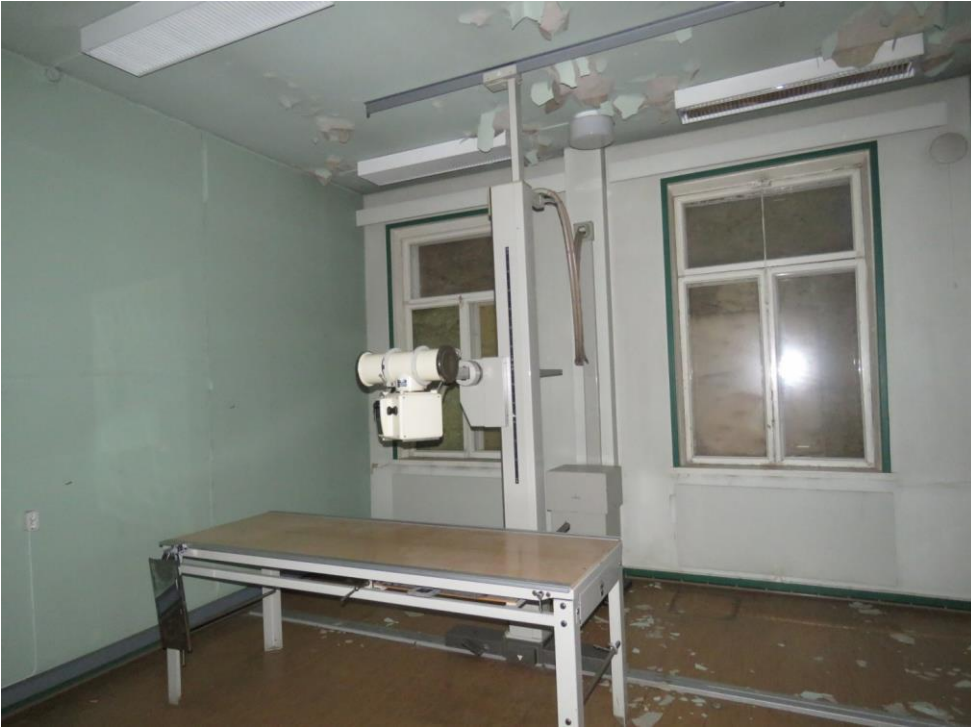
Kuva 7. Entinen laboratoriorakennus, kohde 5, sisätilat (O-P.S: 27.3.2018).
