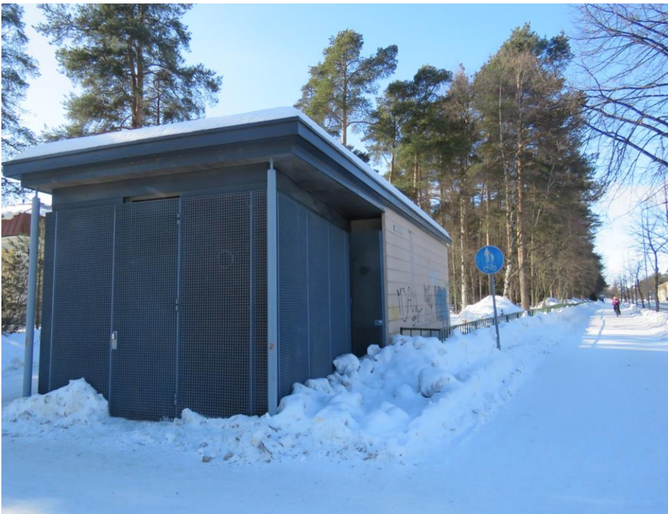
Kuva 2. Yhdyskuntatekniikan rakennus, kohde 1 (kuva O-P.S: 20.3.2018).
