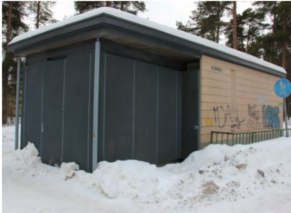
184. Vanha tiilirunkoinen puhelinkekus on lietty osaksi uutta keskusta. Sen tiiliseinät on suojattu teräsritilällä.
