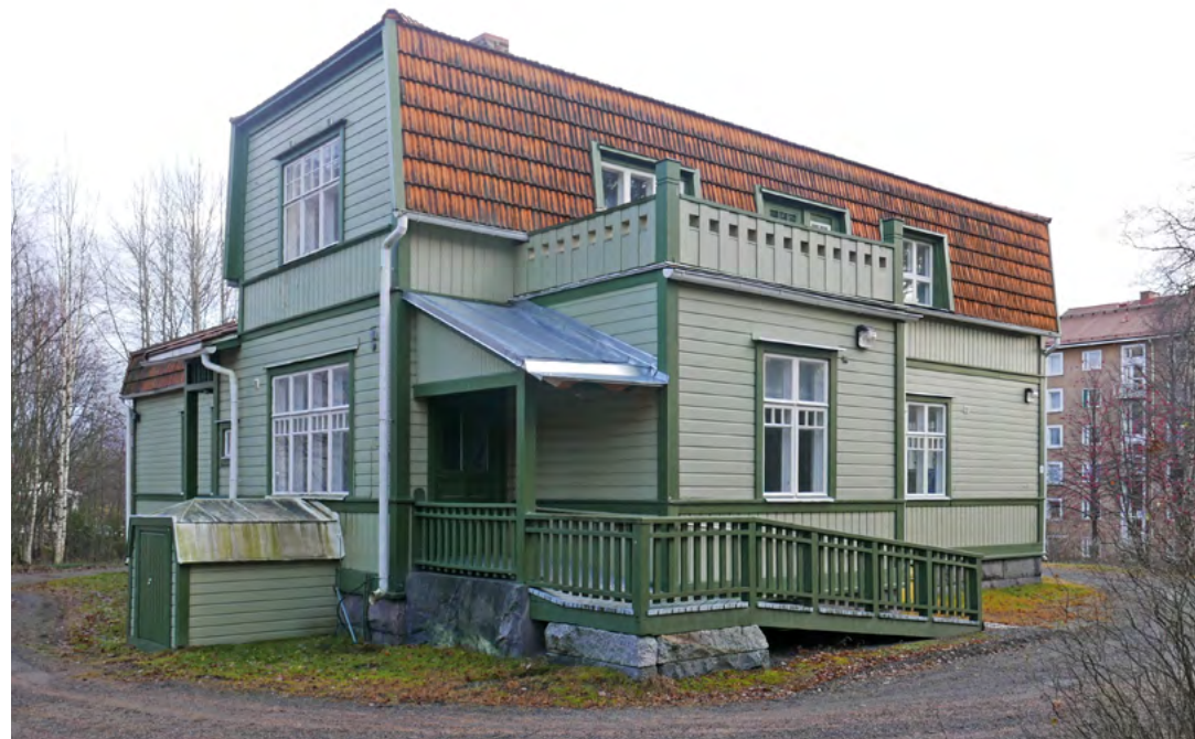
209. Länsisivulle on rakennettu pyörätuoliluiska 1988.
