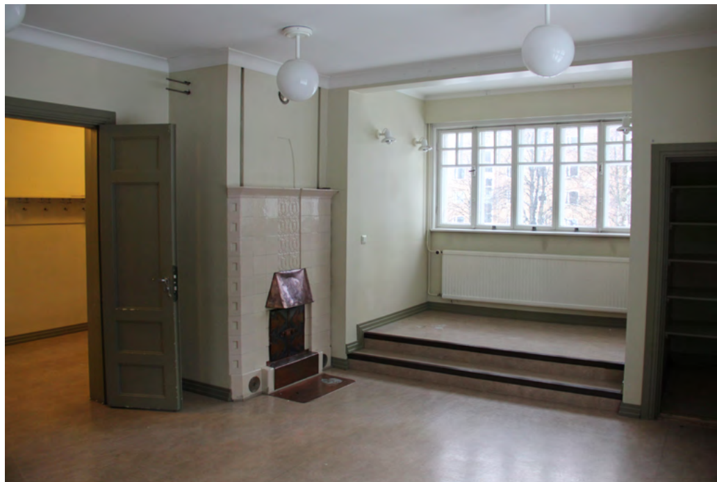
206. Rakennuksen sisätiloissa on säilynyt valkoisia kaakeliuuneja. Huoneiden alkuperäiset materiaalit ovat peittyneet 1975 ja vuoden 1988 korjausten yhteydessä.
