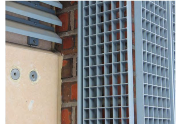
184. Vanha tiilirunkoinen puhelinkekus on lietty osaksi uutta keskusta. Sen tiiliseinät on suojattu teräsritilällä.
