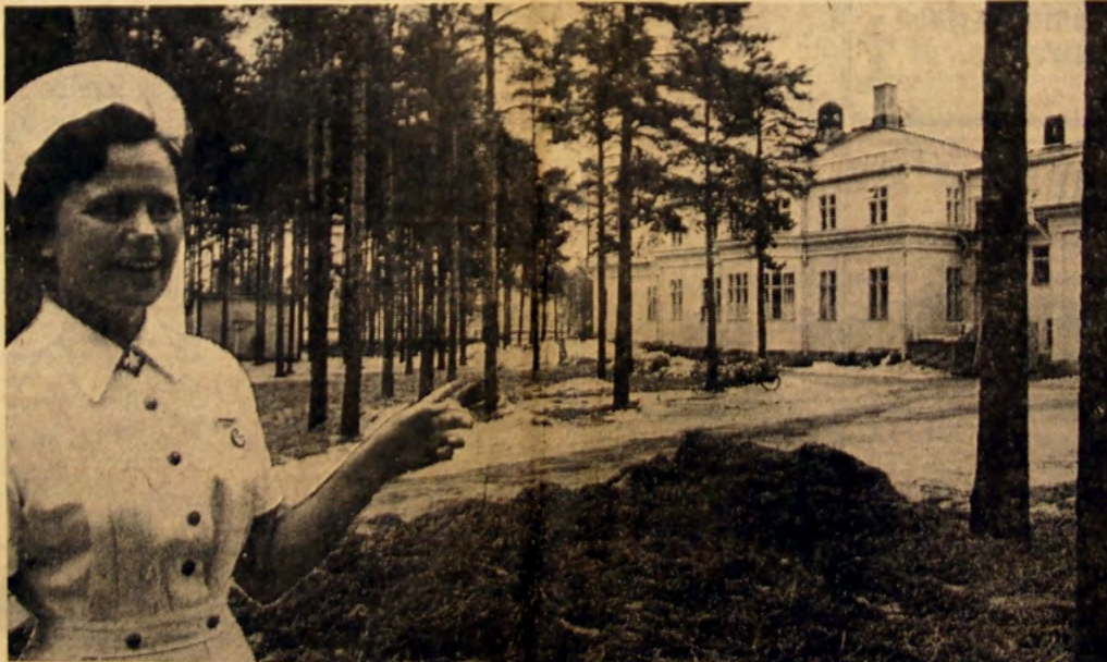
Synnytyslaitoksen johtajatar Terttu Koponen näyttää lisärakennuksen paikkaa, joka jäätymisen estämiseksi on peitetty pehkuilla.
