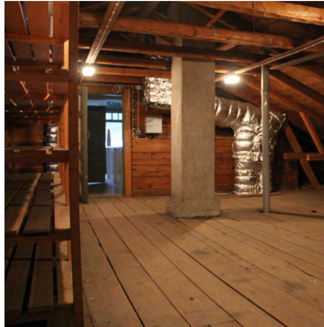
213. Ullakko on säästynyt suurilta muutoksilta.
