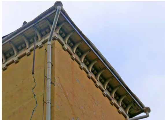
140. Puiet konsolit kannattelevat kattotasannetta.
