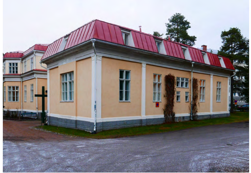
189. Eteläpäädyn kattohuoneistoon on rakennettu asuinhuoneita sairaanhoitajille.
