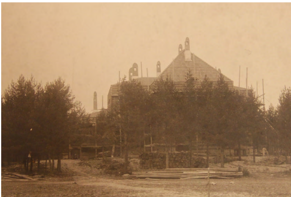
48. Hermostautisairaalan rakennustyömaa vuonna 1909. KUVA: PPM
