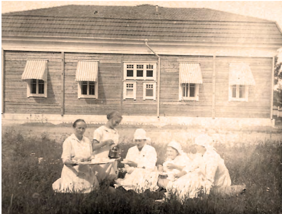
63. Synnytysairaala ennen julkisivujen rappaamista. Rappausverkon kiinnittämisessä on käytetty pieniä tähden muotoisia tiiliä. Myöhemmin päätyjulkisivussa näkyvään mansardikattoon puhkaistiin sairaanhoitajien asuntojen ikkunalyhdyt. Kuva: PPM
