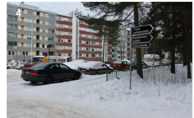
7. Idässä Tuiranpuistoa rajaa seitsenkerroksinen muurimainen kerrostalolomelli. Se suojaa puistoa Merikoskenkadun liikenteen melulta.
