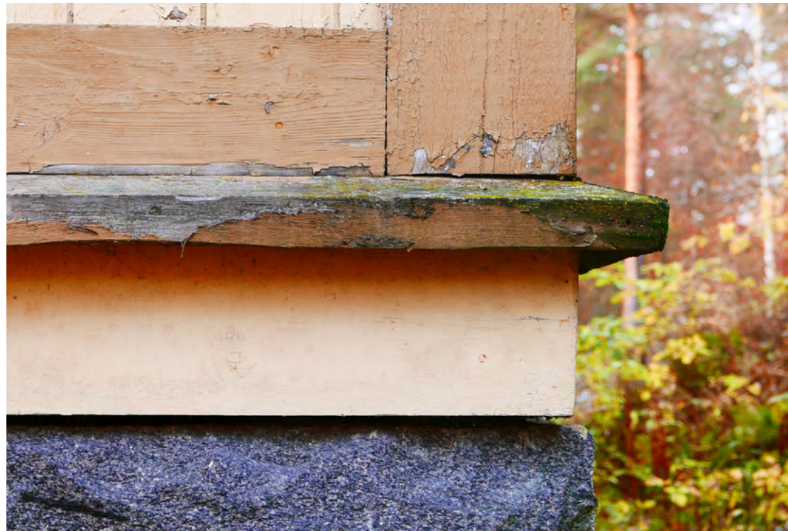
163. Yksityiskohta kivijalan ja puurungon liitoksesta.
