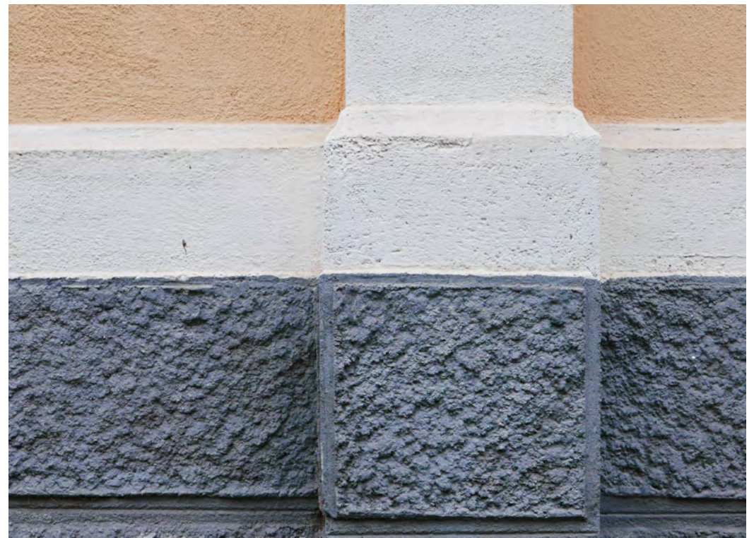
191. Hirsirunkoisen rakennuksen julkisivut on rapattu muistuttamaan kivirakennusta.
