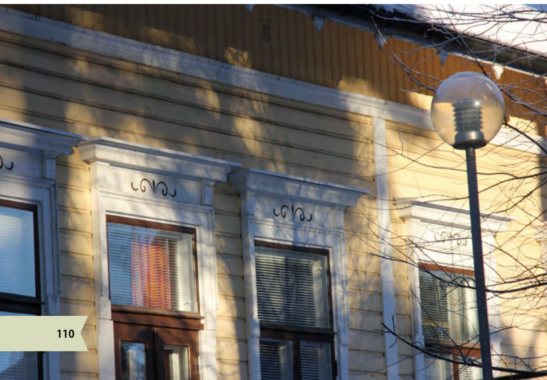
180. Ikkunoiden yläpuolen koristeaiheet on palautettu.
