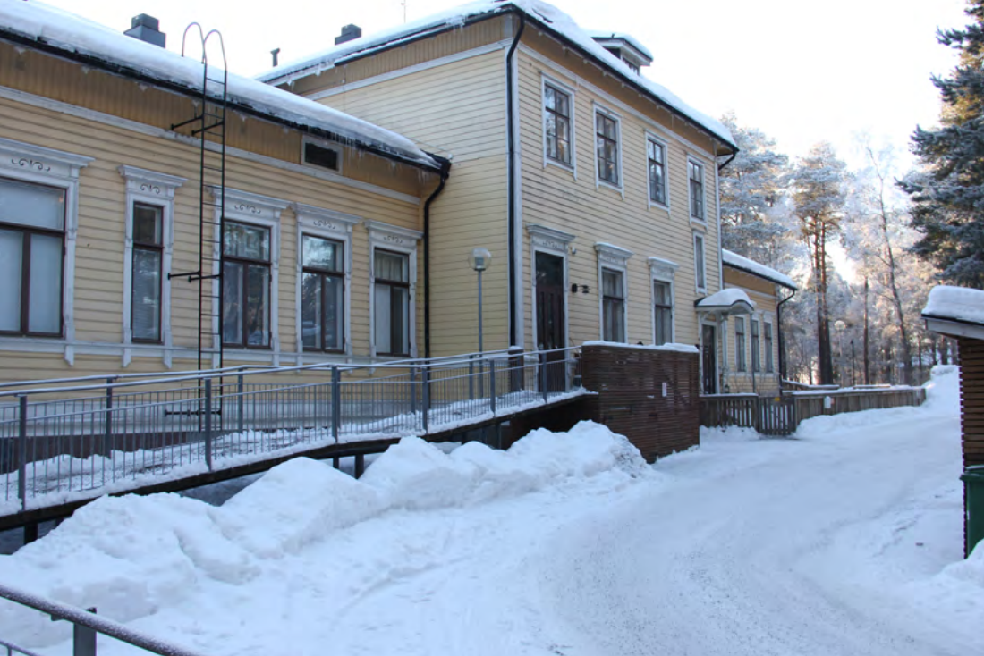
178. Etupihalle on tehty pitkä pyörätuoliliiska. Sisäänkäynnin muutoksessa ikkuna ja ulko-ovi ovat vaihtaneet paikkaa.
