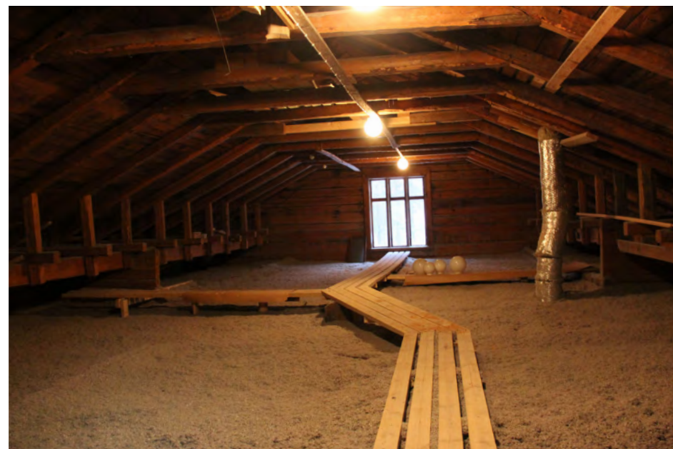
183. Molemmat päädyt ovat säilyneet ullakkona. Lisäeristys on tehty vuonna 2014.
