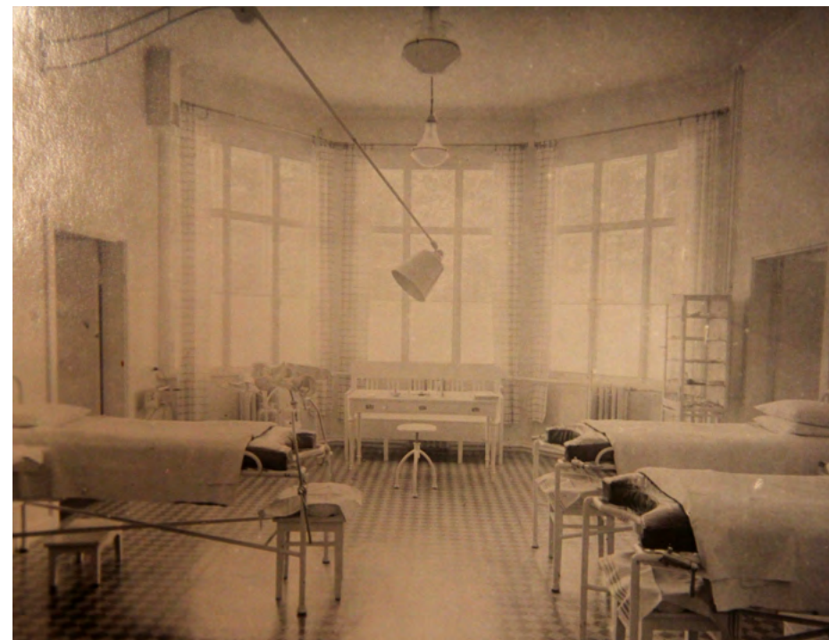
62. Synnytysali sijaitsi valoisassa ikkunaerkerissä rakennuksen keskellä. Kuva on vastavalmistuneesta sairaalasta vuodelta 1926. Kuva: PPM
