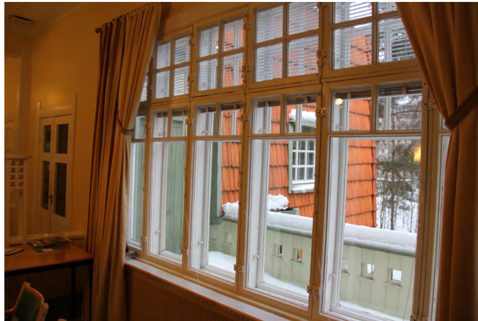
198. Ikkunanäkymä toisen kerroksen parvekkeelle.
