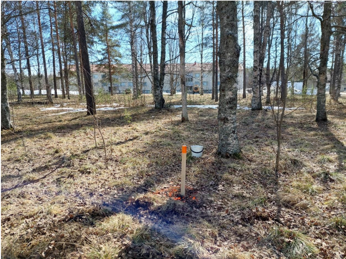
Kuva 2. Tutkimuspiste P5 ja pohjavesiputken PVP2 paikka ennen putken asennusta. Kuvaussuunta itään. (27.4.2022)
