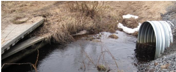
Kuva 9. Saverikonpuistossa ulkoilureitin alittava te-räsaalto rumpu D1400 (Koivisto 2011).
