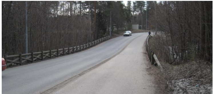
Kuva 14. Sangintien silta Myllyjojan ylitse, Myllyjojan virtaussuunta kuvassa oikealta vasemmalle (Koivisto 2011).
