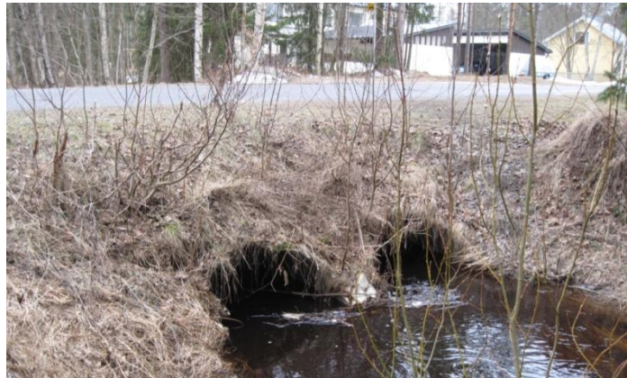
Kuva 12. Korpitien alittavat D1400 teräsaaltorummut (Koivisto 2011).
