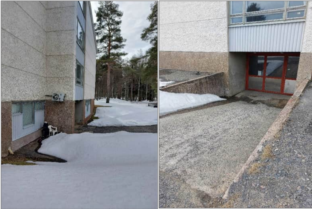
Kuva 12 Ritiläkantisia kaivoja on sijoitettu rakennusten vierelle kellarinajoluiskien alaosiin
