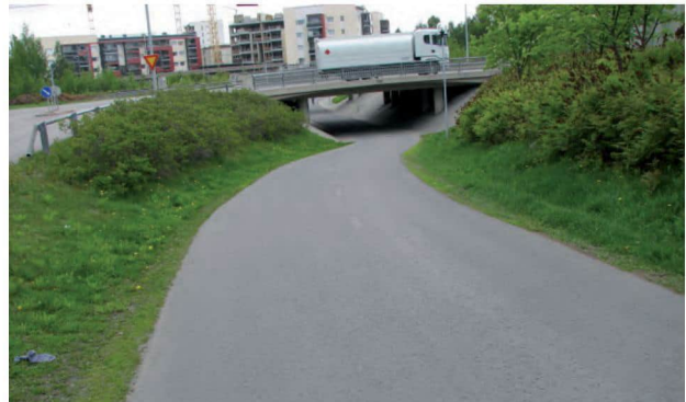
Kuva 14. Alikulkuun johtavalle väylälle voisi maalata ajokaistat erottavat merkinnyt. Alikulkujen sekä pimeän että valoisan ajan valaistukseen (kontrasti muuhun väylävalaistukseen) tulisi kiinnittää huomiota.
