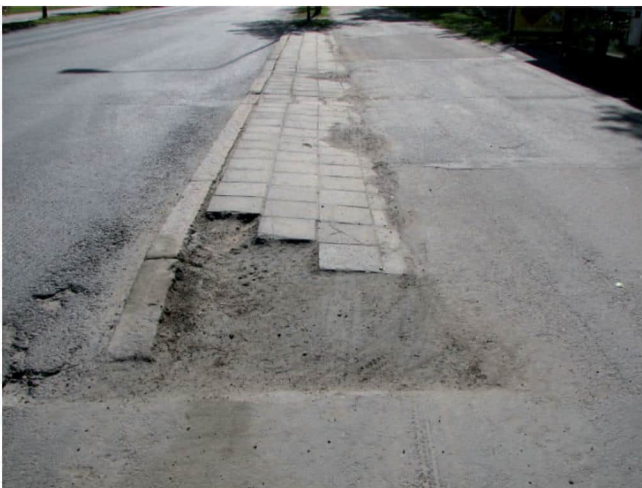
Kuvat 24 ja 25. Kunnostettu pysäkki (ylempi kuva) ja huonokuntoinen odotustila (alempi kuva) erikoistason pysäkillä Valtatiellä Länsi-Tuirassa.
