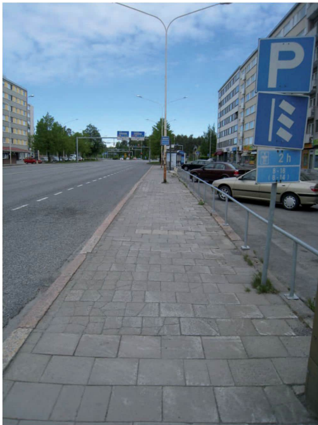
Kuvat 28 ja 29. Merikoskenkadulla sekä sisimmäsillä että ulommaisilla pysäkeillä on paljon korjattavaa, esimerkiksi pysäkki odotustiloineen ei erotu jalkakäytävästä (ylempi kuva).
