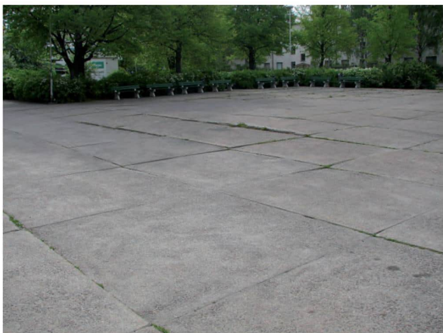
Kuvat 15–18. Tuiran torilla laatoitus on huonossa kunnossa ja tori ei ole hyvin jäsennelty.
