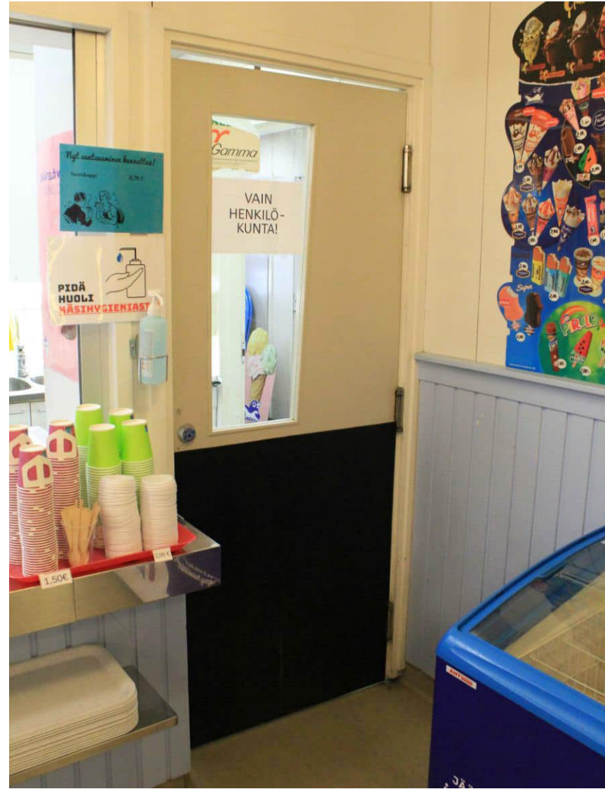
Kahvion ja keittiön välissä on heilurioven saranoilla varustettu ovi. Ovenssa on korkea potkulevy urakumimattoa.
