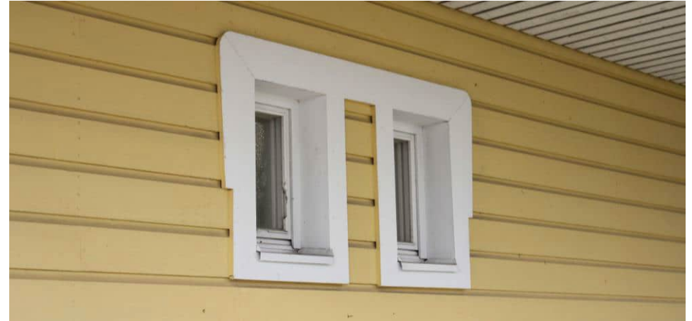
Miesten talvipukuhuoneen ikkunat. Ikkunoita kehystävät yläosistaan leveiksi kaartuvat, yläkulmista pyöristetyt vuorilaudat. Ikkunat on sommiteltu julkisivuille pareittain.
