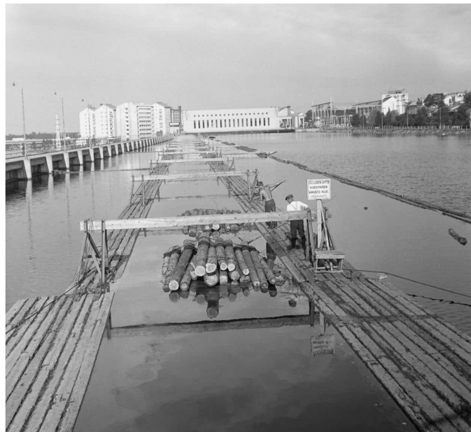
Oulunjoen uittoyhdistyksen varastoaluetta vuonna 1966, taustalla Merikosken voimalaitos. Kuvassa vasemmalla näkyy yläkanavaa Oulujoen uomasta erottava pitkittäinen lamellipato. Taustalla näkyvät Toivoniemen korkeat kerrostalot. (Kuva Museovirasto / Historian kuvakokoelma / Teuvo Kanerva).
