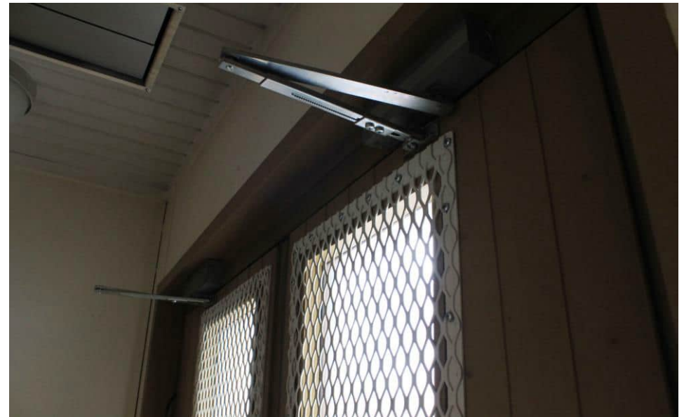
Ulko-ovien lasiaukkoihin on asennettu metalliristikot.
