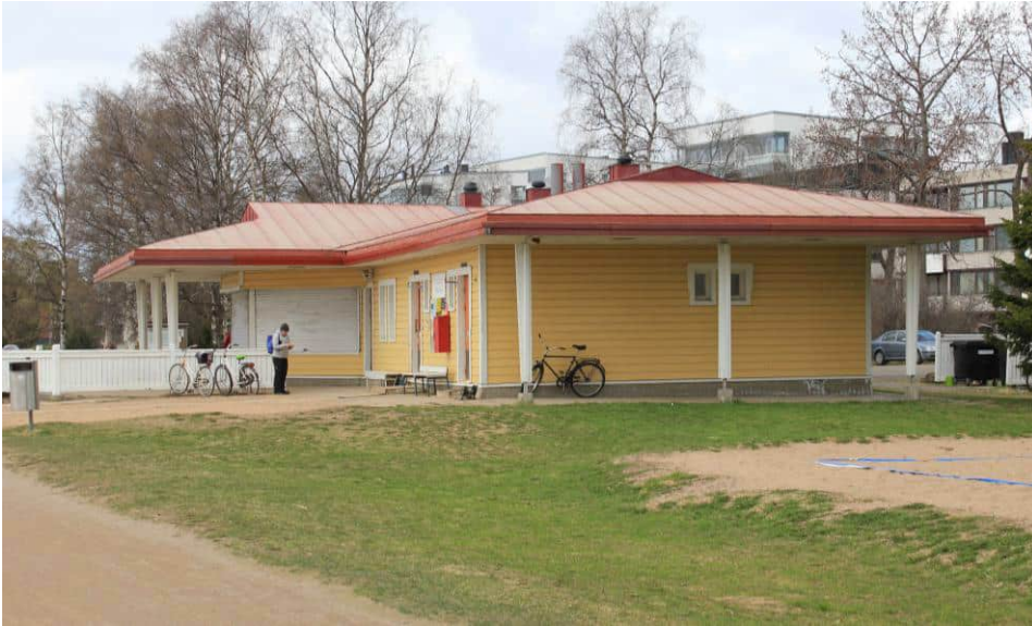
Pääty itään. Julkisivulla näkyvät miesten talvipukuhuoneen yläikkunat.
