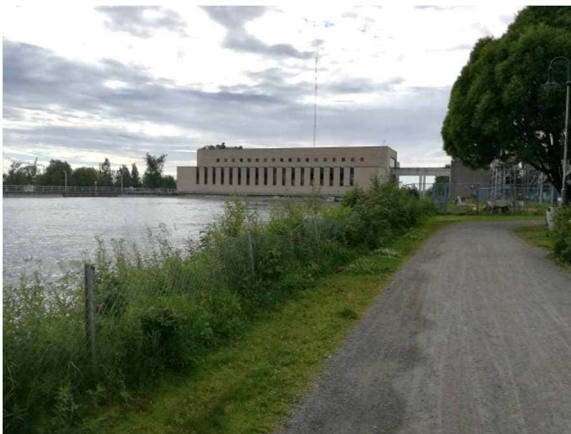
Kuva 17. Merikosken voimalaitos ja näkymän päätteenä muuntajakenttä.
