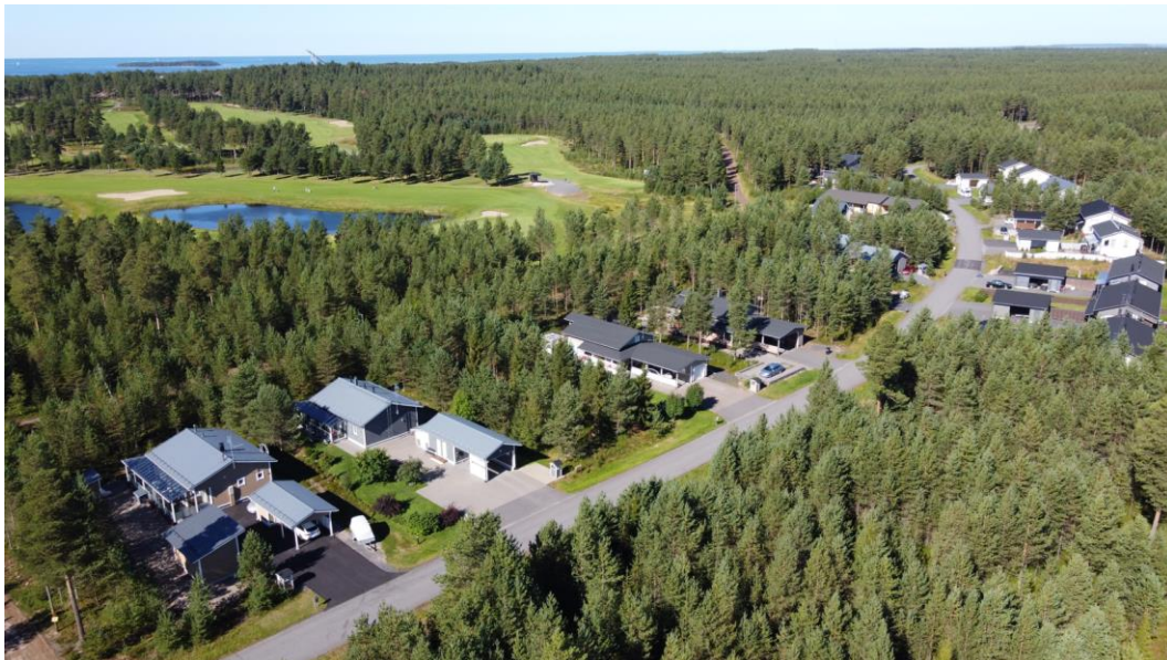
Kuva 7: Kellonlahden Griinikaarre-kadun rakennuskantaa kaakosta päin kuvattuna (kuva Ville Honkonen).
