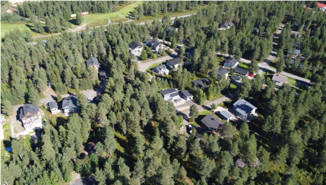
Kuva 5: Meriniemen rakennuskantaa lounaasta päin kuvattuna. Kuvan oikeassa reunassa näkyy Hedmanssonintie sekä tieltä kuvan vasenta laitaa kohti suuntautuvat Havurinne ja Lehvärinne. Kuvan vasemmassa reunassa näkyy Purjekujan itäpää (kuva Ville Honkonen).
