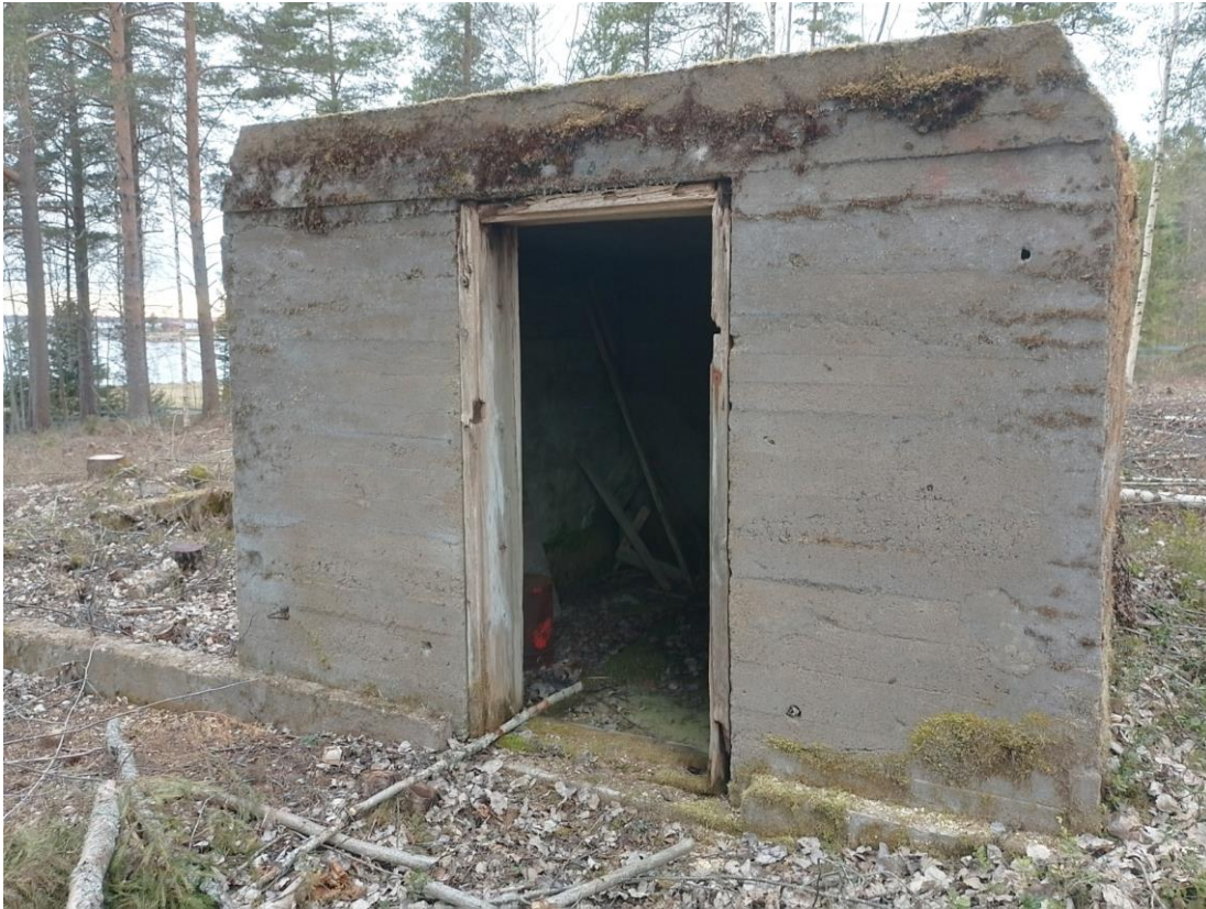
Kuva 1. Vanha betonirakennus, jossa ei ole merkkejä lepakoiden esiintymisestä.
