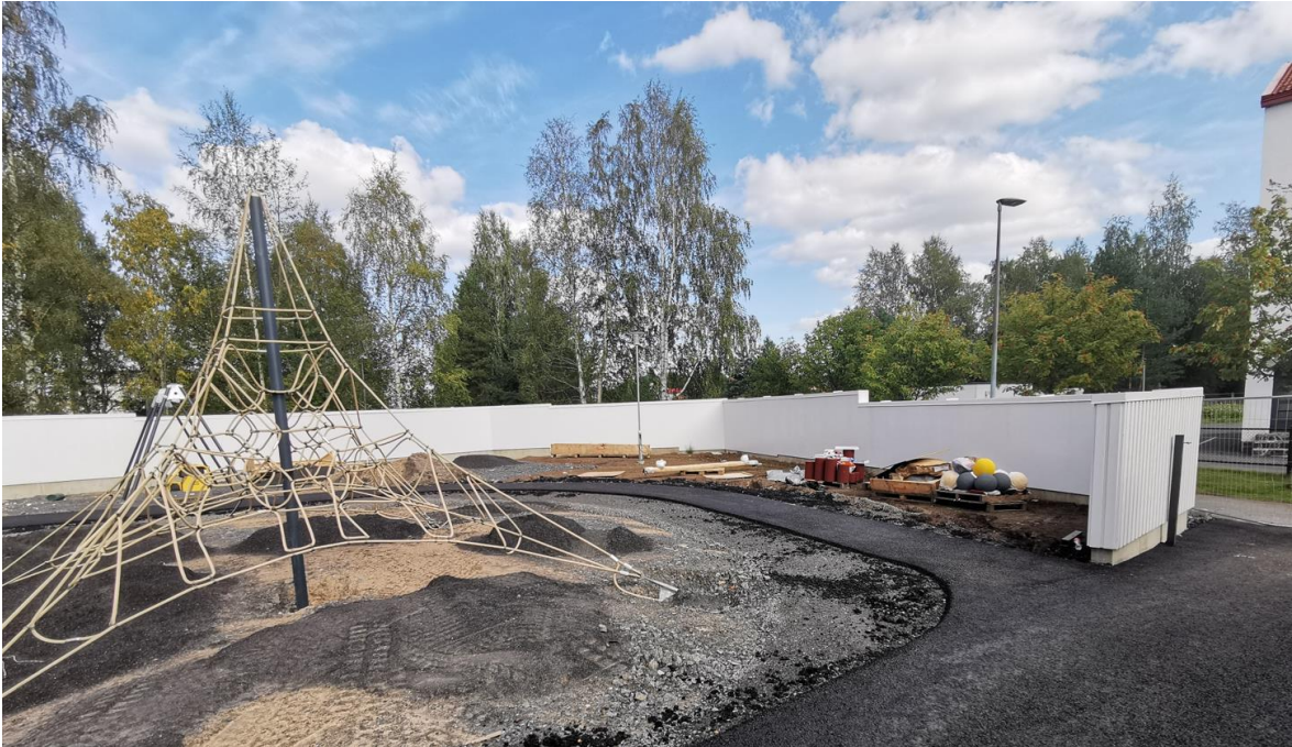
Kuva 6. Hintan päiväkodin pihan melusuojaus.
