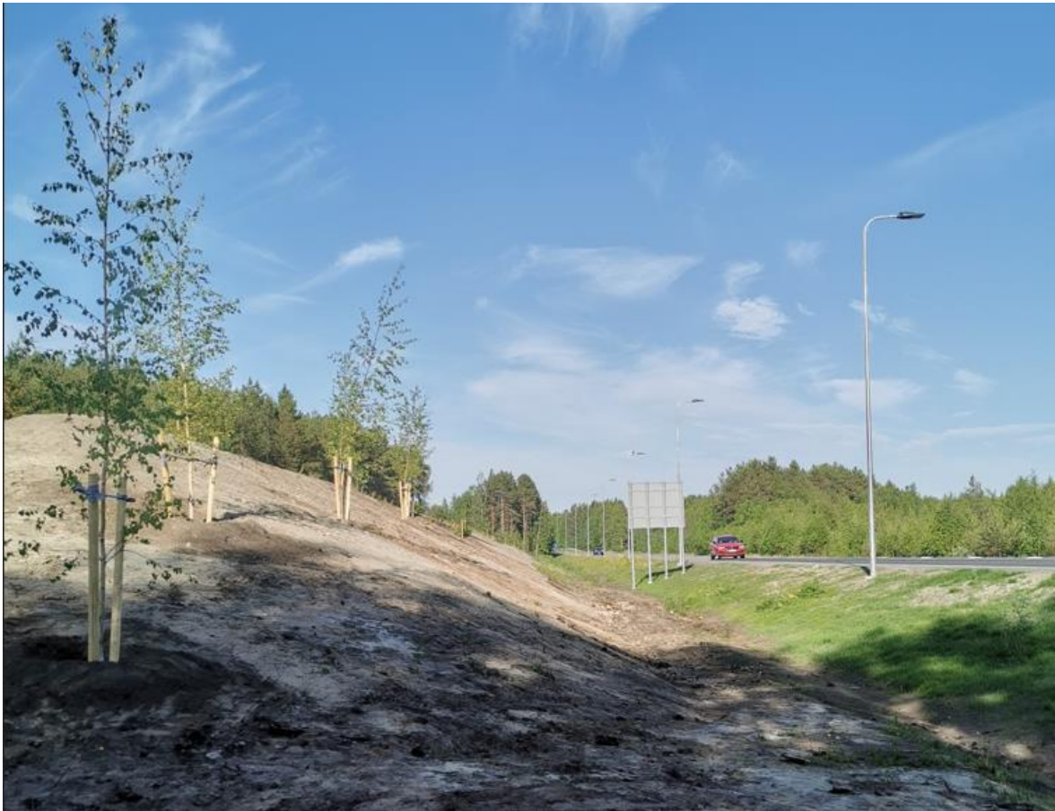
Kuva 1. Alakyläntien varrelle Kaijonharjuun kesällä 2023 rakennettu meluvalli.
