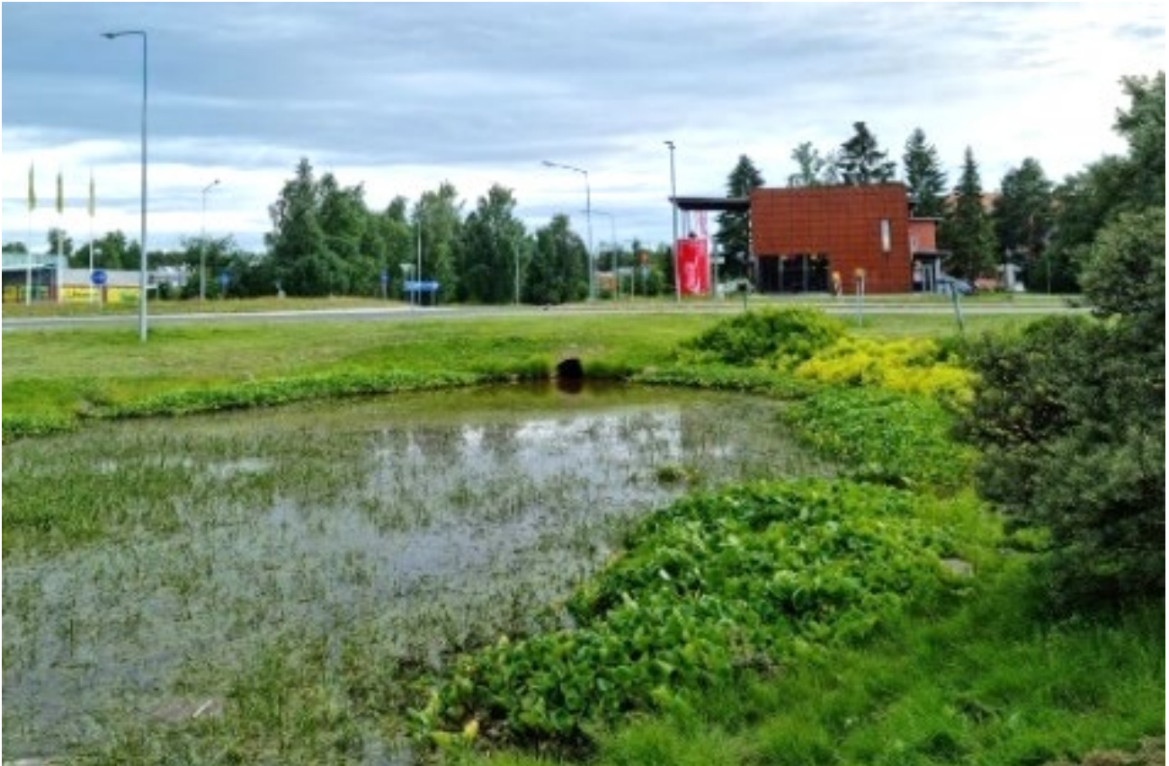
Kuva 14. Hulluojan hulevesien käsittelyallas.
