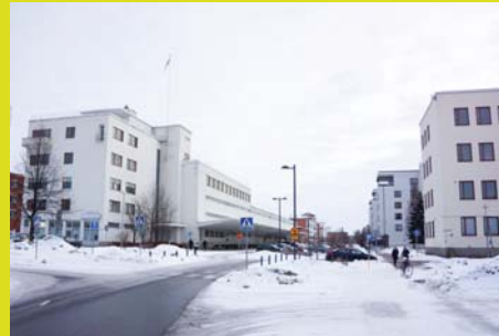
Vasemmalla SOK:n konttori-varastorakennus
