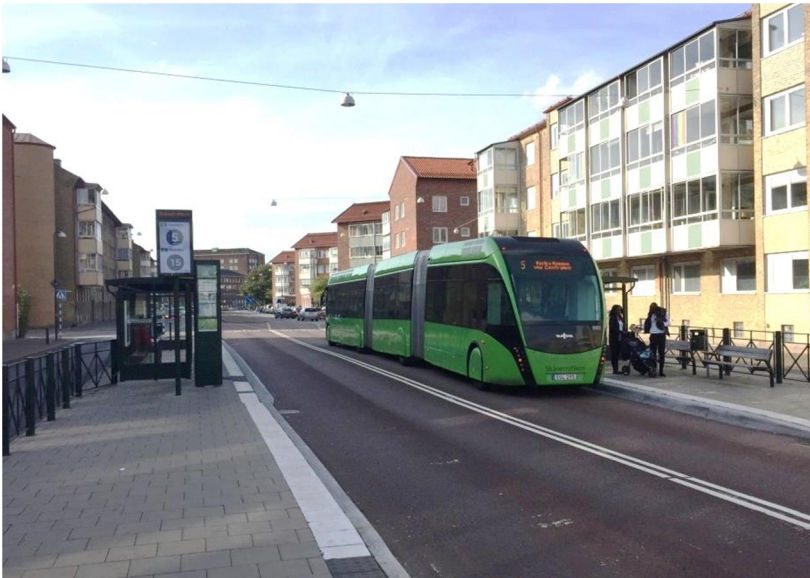
Kuva 9. MalmöExpressen (superbussi) bussikaistat ja pysäkkijärjestelyt on sijoitettu ajoradan keskelle bussiliikenteen sujuvuuden ja matkustajien turvallisuuden varmistamiseksi. Pysäkkitasanteiden kohdalla on käytetty pyöreämuotoista reunakiveä, joka mahdollistaa bussin pysähtymisen reunakiveen kiinni vahingoittamatta renkaita tai vanteita. Odotustasanteen välittömään läheisyyteen pysähtyvä bussi tarjoaa "ratikkamaisen" tasalaatuisen käyttökokemuksen matkustajilleen (Jani Karjalainen).
