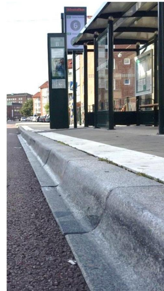
Kuva 9. MalmöExpressen (superbussi) bussikaistat ja pysäkkijärjestelyt on sijoitettu ajoradan keskelle bussiliikenteen sujuvuuden ja matkustajien turvallisuuden varmistamiseksi. Pysäkkitasanteiden kohdalla on käytetty pyöreämuotoista reunakiveä, joka mahdollistaa bussin pysähtymisen reunakiveen kiinni vahingoittamatta renkaita tai vanteita. Odotustasanteen välittömään läheisyyteen pysähtyvä bussi tarjoaa "ratikkamaisen" tasalaatuisen käyttökokemuksen matkustajilleen (Jani Karjalainen).
