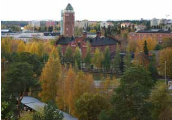
Kuva 3. Åströmin vesitorni. (kuva: Oulun konserni-palveluiden kuva-arkisto)
