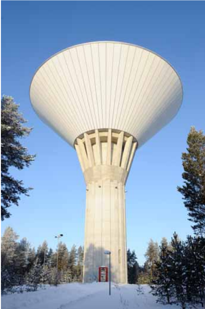
Kuva 16. Knuutilankankaan vesitorni. (kuva: Oulun konsernipalveluiden kuva-arkisto)
