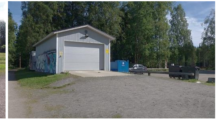
Kuva 66. Huoltorakennus ulkoilualan pysäköintialueen vieressä.
