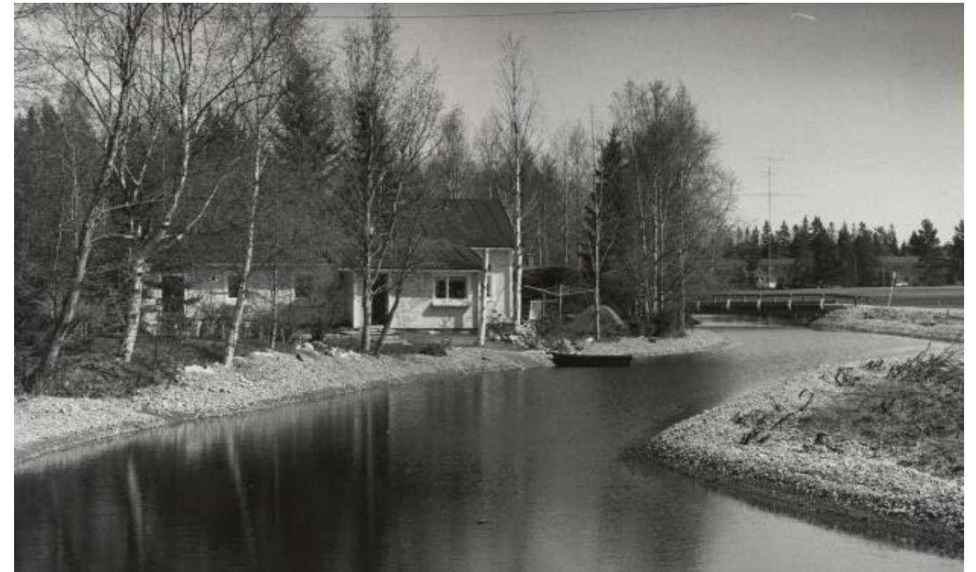
Kuva 3. Juurusoja Heikkilänkankaalla vuonna 1992. Taustalla näkyy oletettavasti Ojalanpolun silta. (Kuva: Kaleva 2017).
