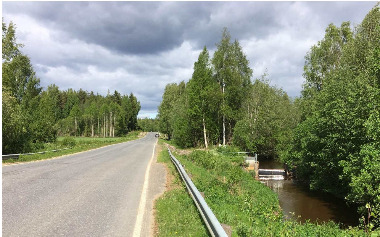
Kuva 127. Entiseen Vasikkaojaan rakennettu pato.
