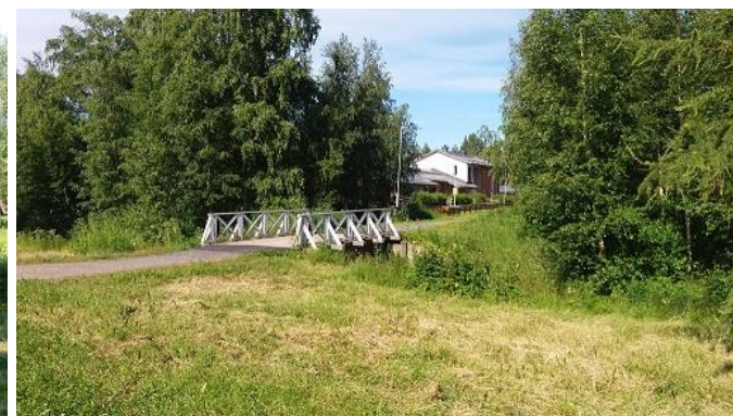
Kuva 64. Valkoinen silta Hiirosenojan yli. Kulkuyhteys Hiiron asuinalueelle.
