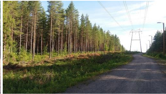
Kuva 50. Kuntopolku kulkee linatissa paikoin sähkölinjan alla.
