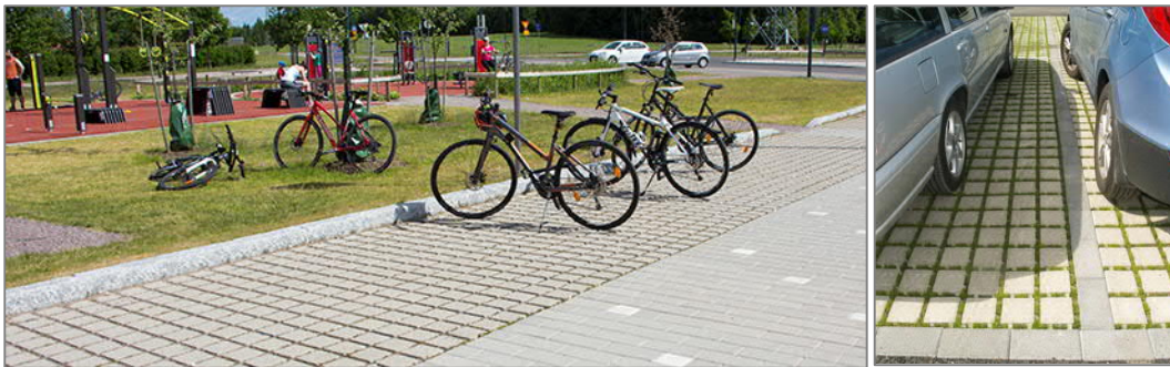
Kuva 10. Vettä läpäiseviä kiveyksiä pysäköintialueilla. (rakentaja.fi)
