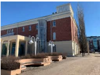
Kuva 2. Näkymä taidemuseon takaa. Rakennuksen päädyssä komeat pylväshaavat ja etualalla istutusaltaseen integroidut istuimet
