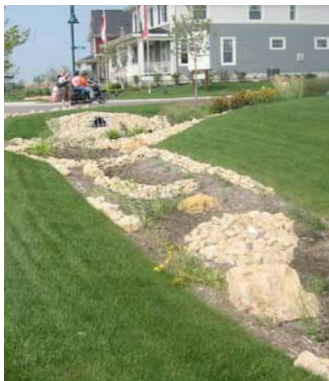
Kuva 8 Viivytyspainanne, johon rakennettu virtaamaa hidastavia pohjapatoja (Kuntaliitto hulevesiosopas 2012) ja periaatekuva viivytyspainanteesta, jossa varauduttu harvinaisen rankkaan sateeseen (Plaana Oy)
