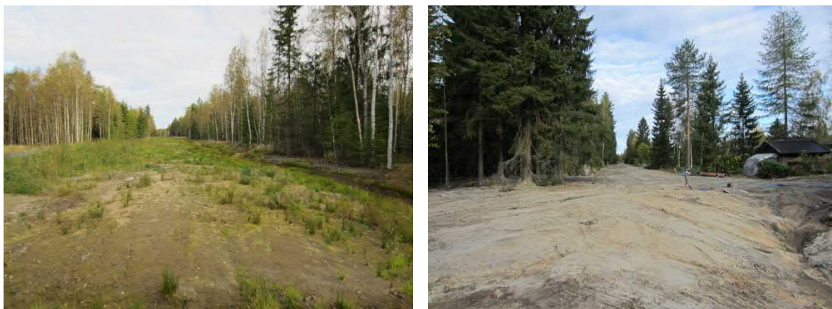
Kuvat 10 ja 11. Jäteveden runkoviemärin aukkoja maisemassa.
