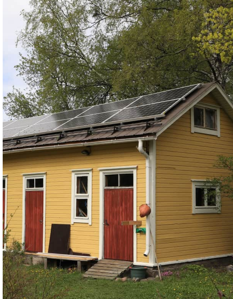
Kuva 103: Piharakennuksen katolle on lisätty aurinkopaneelit. (Kuva: Riitta Kosonen, Arkkitehtitoimisto Jorma Teppo Oy, 5/2021.)
