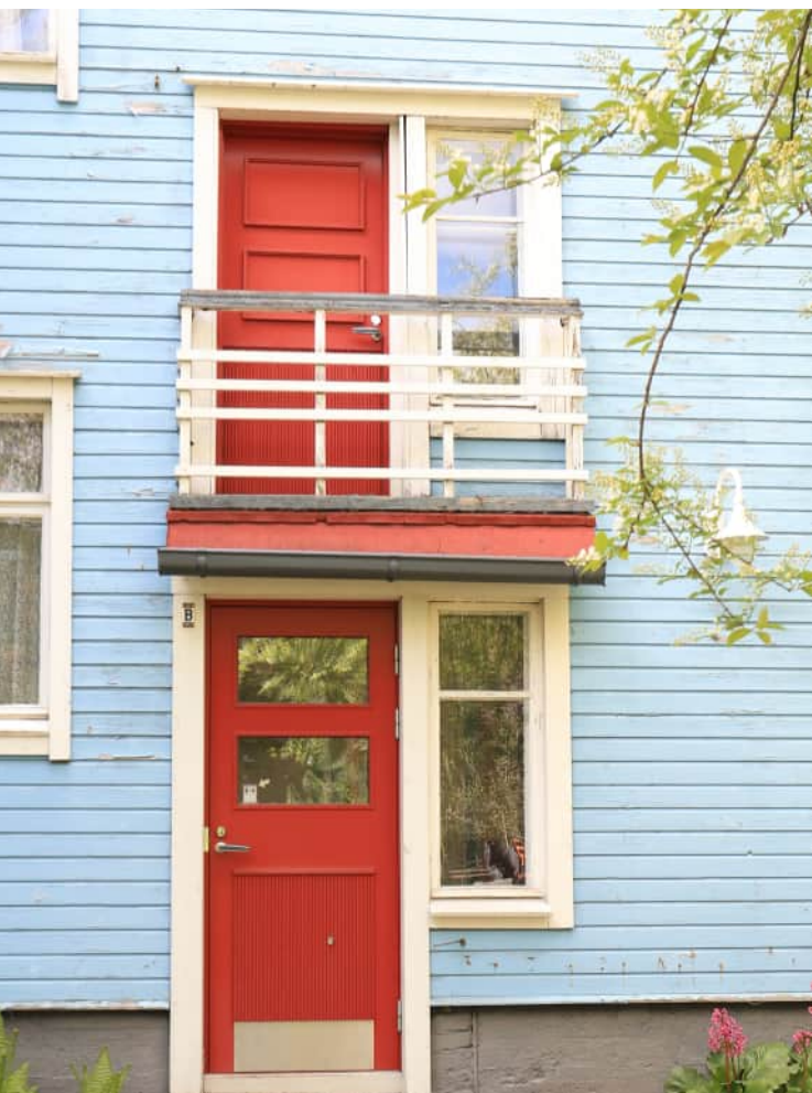
Kuva 74: Jälleenrakennuskauden klassismi, jossa funktionalismin piirteitä. (Kuva: Riitta Kosonen, Arkkitehtitoimisto Jorma Teppo Oy, 5/2021.)
