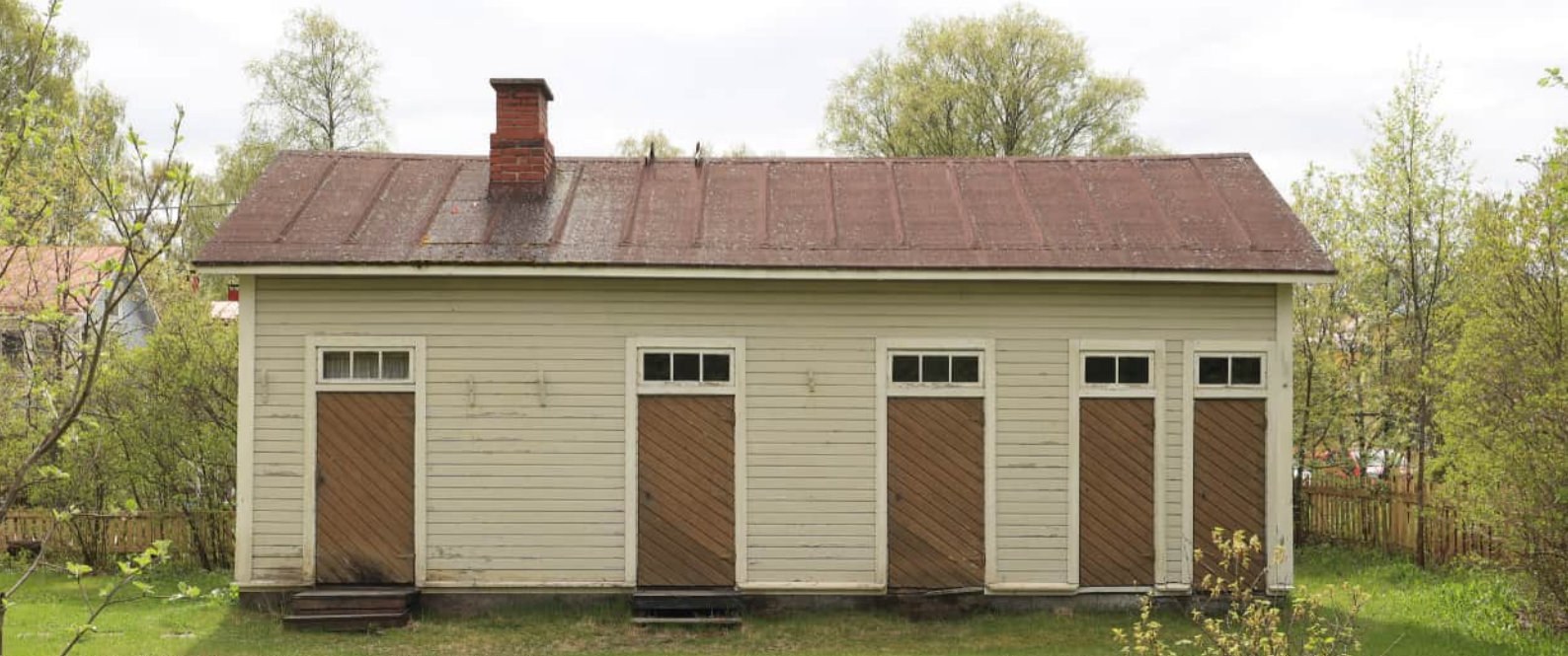
Kuva 84: Puu-Raksilassa on vielä yksi ulkoisesti kaikilta osiltaan alkuperäisenä tai alkuperäisen mukaisena säilynyt piharakennus. Rakennus sijaitsee korttelissa 29 tontilla 204. Rakennuksen suunnitelma on likipitään vastaava kuin sivulla 50 esitetty tontin 202 piharakennuksen suunnitelma. (Kuva: Riitta Kosonen, Arkkitehtitoimisto Jorma Teppo Oy, 5/2021)
