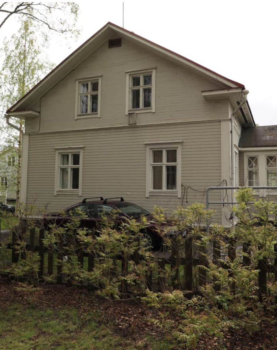
Kuva 38: 1920-luvun klassismille tyypilliset päätyikkunat. (Kuva: Riitta Kosonen, Arkkitehtitoimisto Jorma Teppo Oy, 5/2021)
