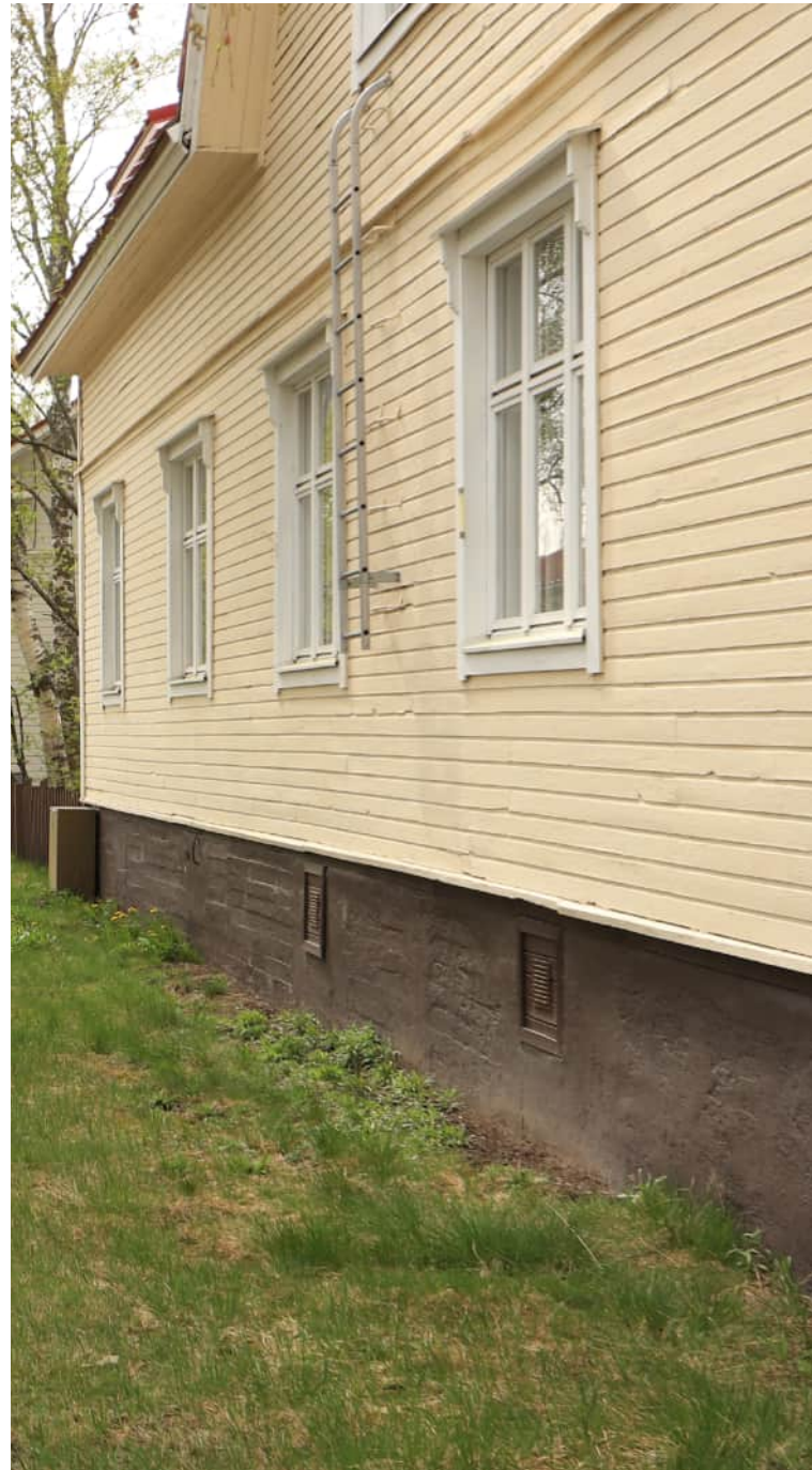
Kuva 82: Tuuletussäleikköjä sokkelissa. (Kuva: Riitta Kosonen, Arkkitehtitoimisto Jorma Teppo Oy, 5/2021)
