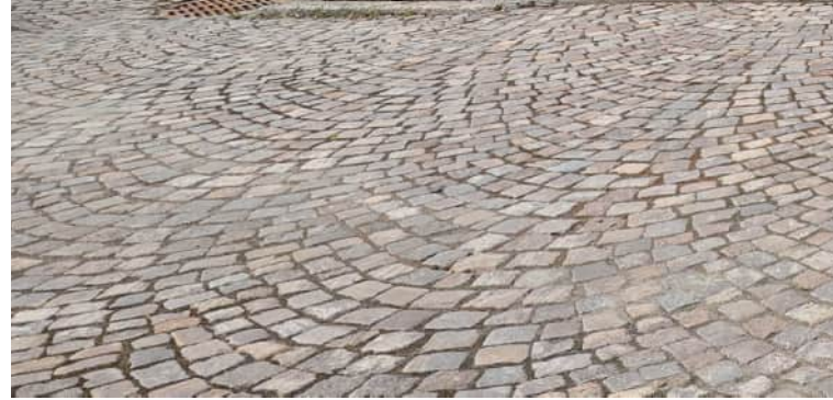
Kuva 97: Mukulakivetystä. (Kuva: Riitta Kosonen, Arkkitehtitoimisto Jorma Teppo Oy, 18.5.2021)
