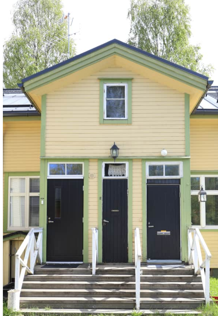
Kuva 78: Puu-Raksilalle tyypillinen 2-kerroksinen kuisti, josta pääsy yläkertaan. (Kuva: Riitta Kosonen, Arkkitehtitoimisto Jorma Teppo Oy, 5/2021)
