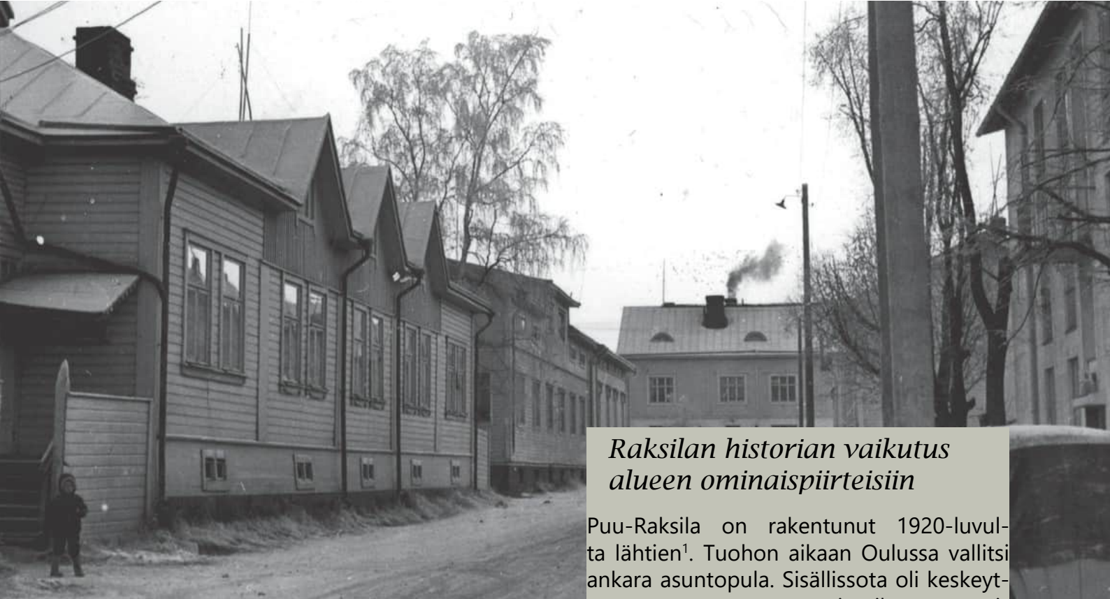
Kuva 5: Näkymä kadonneesta Raksilasta vuodelta 1962. Välikadun päätteenä on Syrjäkatu 11:ssä toiminut yleinen sauna. (Kuva: Museovirasto JOKA, Kaleva)
