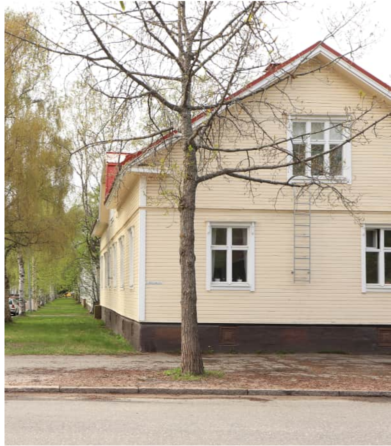
Kuva 35. Alkuperäisen mukaisena säilynyt 1920-luvun klassismia edustava päätyikkuna Tehtaankadun varrella. (Kuva: Riitta Kosonen, Arkkitehtitoimisto Jorma Teppo Oy, 5/2021)
