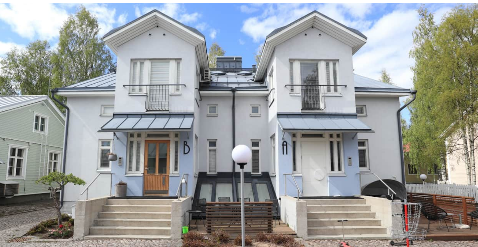
Kuva 79: Tontin 267 kuistit mukailevat alueen alkuperäisten kuistien muotokieltä, ollen samalla moderneja. (Kuva: Riitta Kosonen, Arkkitehtitoimisto Jorma Teppo Oy, 5/2021)
