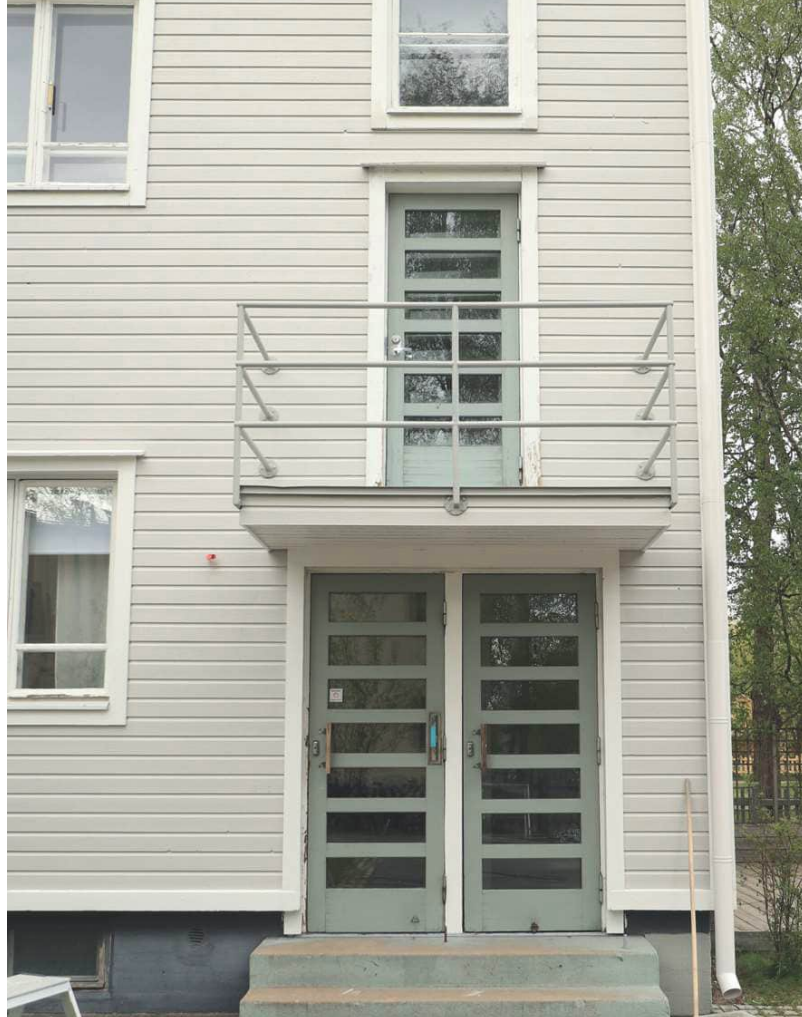
Kuva 73: Rakennuksen ikkunat ja parvekekaiteet edustavat funktionalismia. (Kuva: Riitta Kosonen, Arkkitehtitoimisto Jorma Teppo Oy, 5/2021.)
