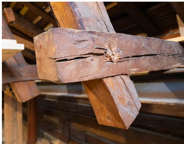
Kuva 102: Byströmin talon ja Nappitalon katto- ja yläpohjaremontti. (Kuva: Sanna Krook 2022)
