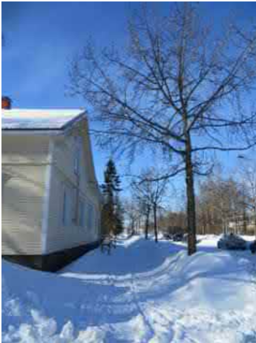
Kuva 25. Epätasaisesti kasvanutta ja paikoin vaurioitunutta Tehtaankadun poppelirivistöä.
