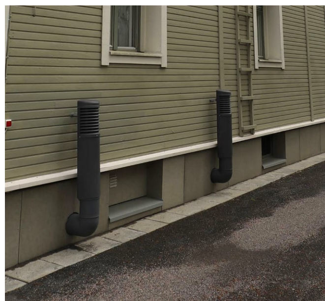
Kuva 54: Levytetty sokkeli. (Kuva: Riitta Kosonen, Arkkitehtitoimisto Jorma Teppo Oy, 5/2021)
