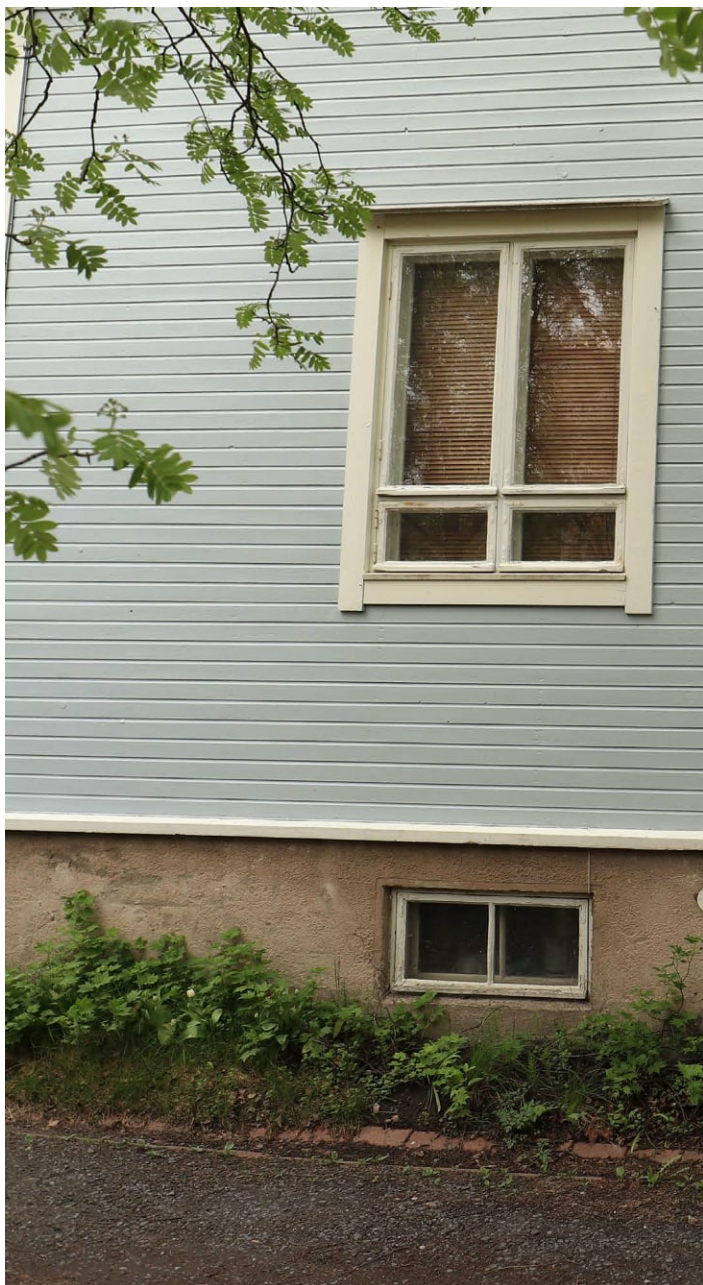
Kuva 52: Alkuperäisinä säilyneet sokkelin ikkunat. (Kuva: Riitta Kosonen, Arkkitehtitoimisto Jorma Teppo Oy, 5/2021)
