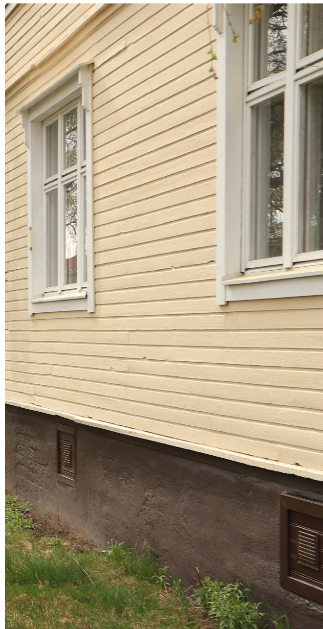
Kuva 53: Tuuletussäleikköjä sokkelissa. (Kuva: Riitta Kosonen, Arkkitehtitoimisto Jorma Teppo Oy, 5/2021)
