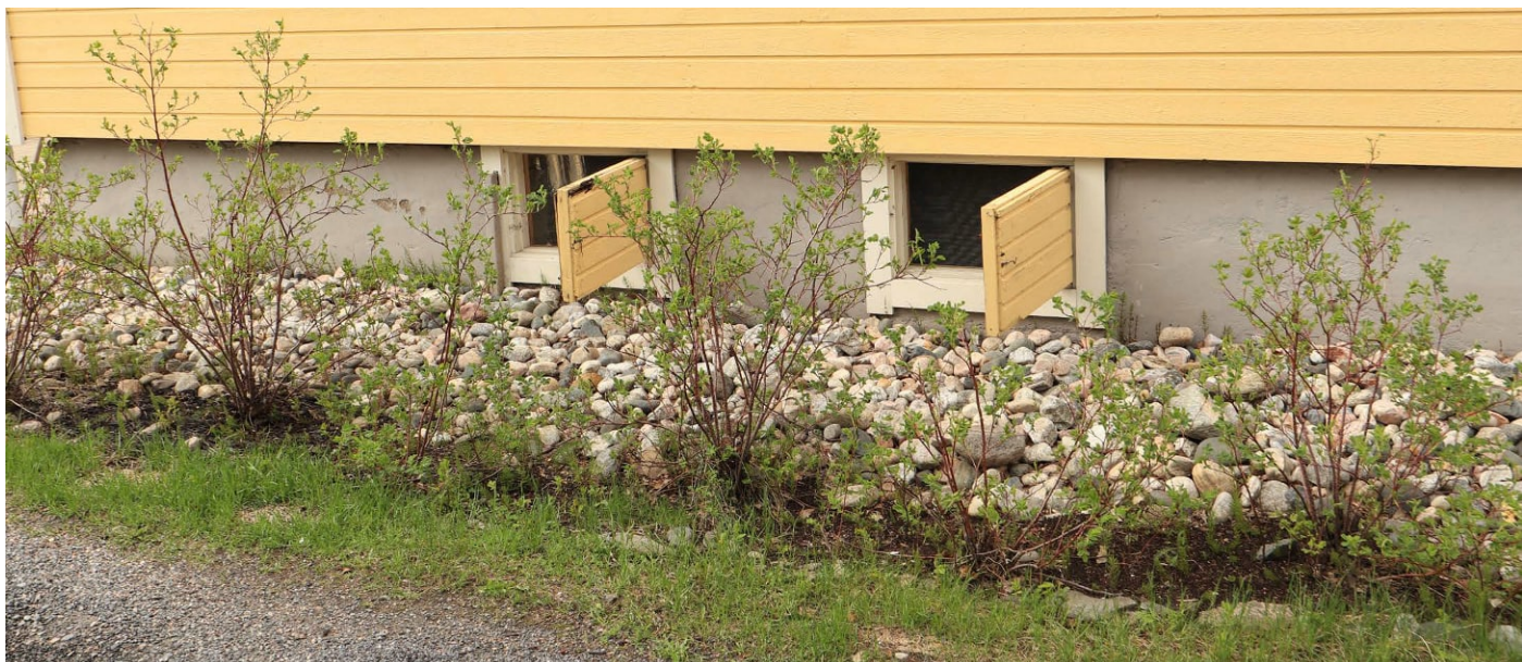
Kuva 51: Sokkelin ympärille on ladottu kiviä kosteuden vähentämiseksi. (Kuva: Riitta Kosonen, Arkkitehtitoimisto Jorma Teppo Oy, 5/2021)
