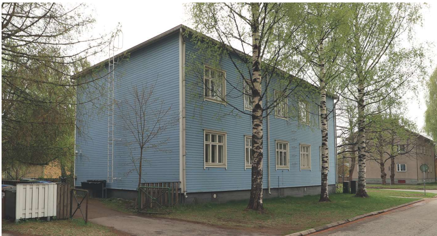
Kuva 32: Karjakatu 13 edustaa jälleenrakennuskauden klassismia, jossa on funktionalismin piirteitä. Alkuperäiset ikkunat ovat säilyneet samoin kuin tontille johtava metalliputkiportti. (Kuva: Riitta Kosonen, Arkkitehtitoimisto Jorma Teppo Oy, 5/2021.)
