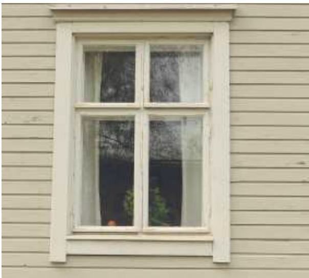
Kuva 38: Jakokarmillinen risti-ikkuna on tyypillisimpiä ikkunatyyppisiä Raksilassa. (Kuva: Riitta Kosonen, Arkkitehtitoimisto Jorma Teppo Oy, 5/2021)
