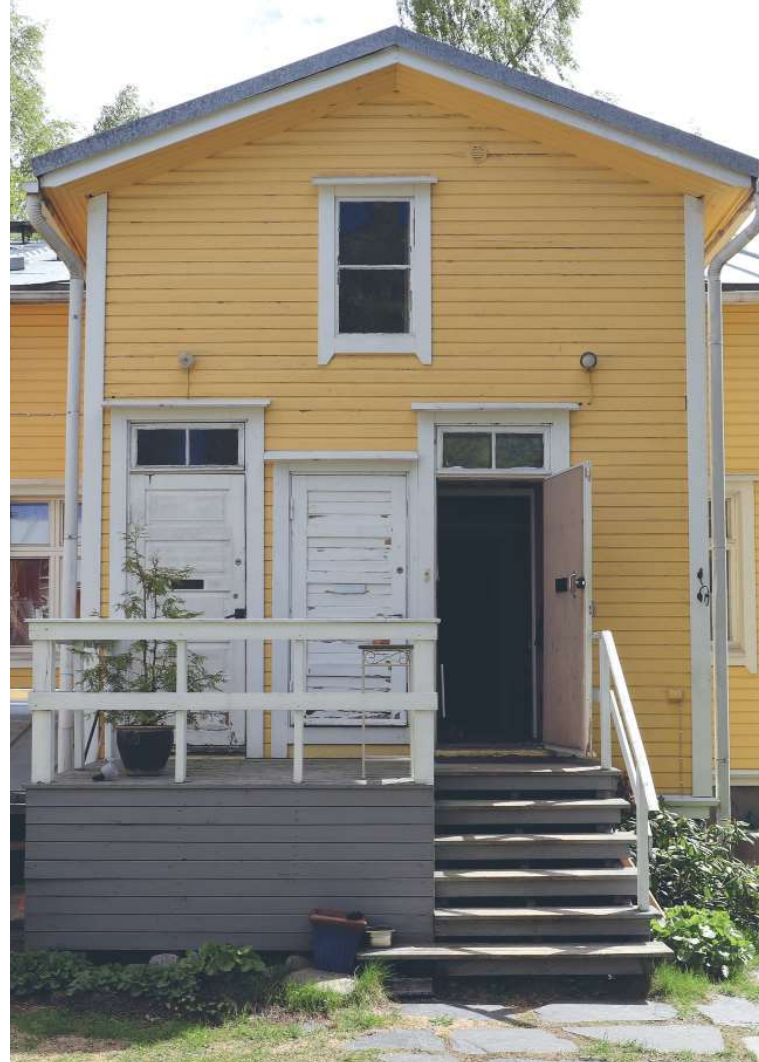
Kuva 49: Puu-Raksilalle tyypillinen 2-kerroksinen kuisti, josta pääsy yläkertaan. (Kuva: Riitta Kosonen, Arkkitehtitoimisto Jorma Teppo Oy, 5/2021)
