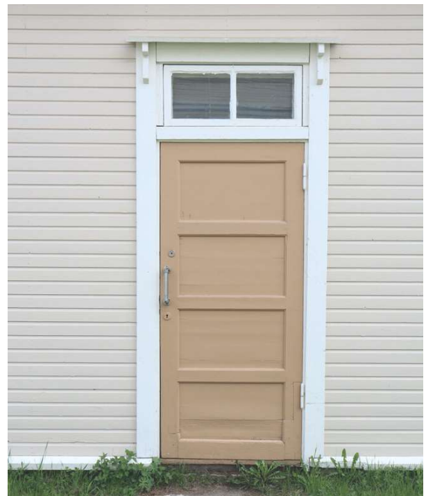
Kuva 58: Puu-Raksilassa tyypillisesti käytetty ovi-malli eli nelipeilinen puuovi, jossa kaksiruutuinen yläikkuna. (Kuva: Riitta Kosonen, Arkkitehtitoimisto Jorma Teppo Oy, 5/2021.)
