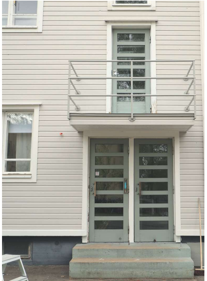
Kuva 43: Rakennuksen ikkunat ja parvekekaiteet edustavat funktionalismia. (Kuva: Riitta Kosonen, Arkkitehtitoimisto Jorma Teppo Oy, 5/2021.)
