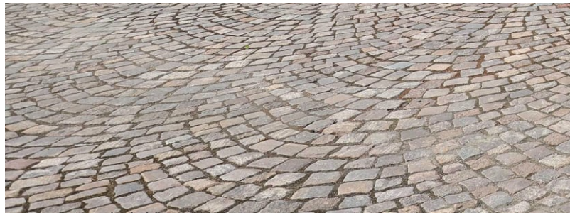
Kuva 69: Mukulakivetystä. (Kuva: Riitta Kosonen, Arkkitehtitoimisto Jorma Teppo Oy, 18.5.2021)
