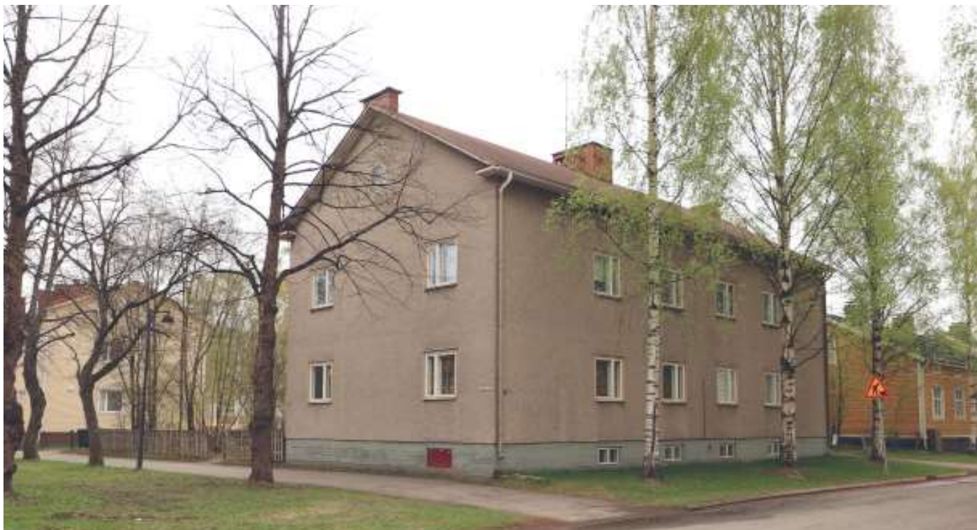
Kuva 33: Tontin 264 puurunkoinen rakennus on rapattu. Se on tyypillinen jälleenrakennuskauden kerrostalo. (Kuva: Riitta Kosonen, Arkkitehtitoimisto Jorma Teppo Oy, 5/2021)
