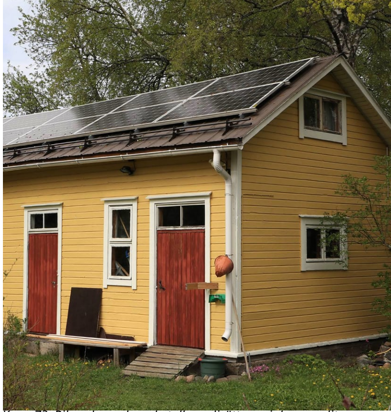
Kuva 73: Piharakennuksen katolle on lisätty aurinkopaneelit. (Kuva: Riitta Kosonen, Arkkitehtitoimisto Jorma Teppo Oy, 5/2021.)
