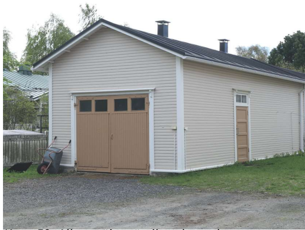
Kuva 59: Alkuperäisestä piharakennuksesta on poistettu ylimääräiset ovet, kun rakennus muutettiin autosuojaksi. (Kuva: Riitta Kosonen, Arkkitehtitoimisto Jorma Teppo Oy, 5/2021.)
