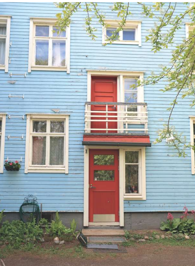
Kuva 44: Jälleenrakennuskauden klassismi, jossa funktionalismin piirteitä. (Kuva: Riitta Kosonen, Arkkitehtitoimisto Jorma Teppo Oy, 5/2021.)
