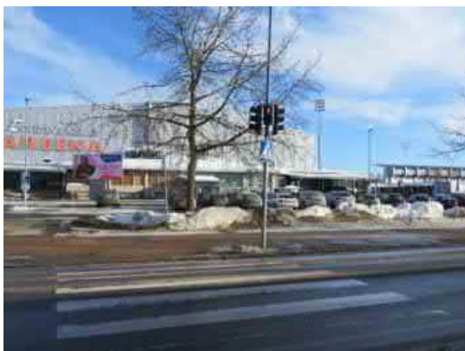
Kuva 12. Tehtaankadun ja Teuvo Pakkalan kadun liittymäalue ikään kuin "levähtää" jäsentymättömästi Jäähallin avoimelle paikoitusalueelle.
