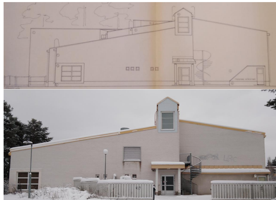
Kuva 43 Rakennuksen takaosa on suurempi kuin etupuolelta katsoessa vaikuttaa. Läpi rungon kulkee valokatteen kanssa yhtenevän muotoinen korotusosa. Julkisivu on tältä puolen varsin pelkistetty ja säilynyt täysin alkuperäisiasussaan. Piirros: Arkkitehtitoimisto Uki Heikkinen Ky.
