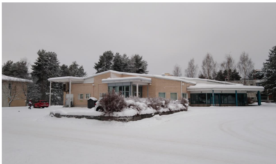
Kuva 34 Rakennuksen pääjulkisivu avautuu Sammontorille. Erilaiset katosrakenteet ja rakennuksen vaihteleva muoto tekevät siitä mielenkiintoisen.
