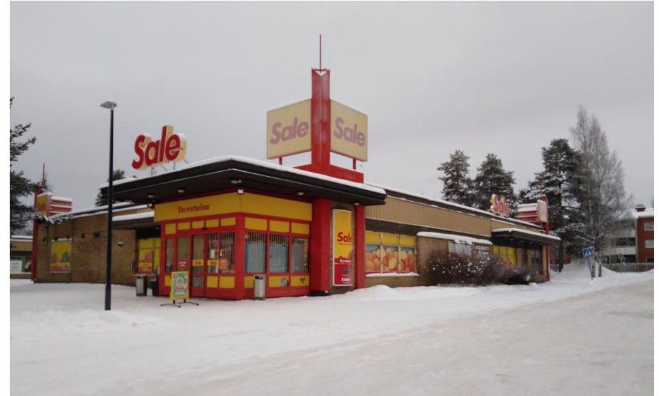
Kuva 30 Sammontorin suunnasta voidaan huomata, miten uusi tuulikaappi on muuttanut rakennuksen profiilia. Mainoskylttejä on katolla runsaasti.
