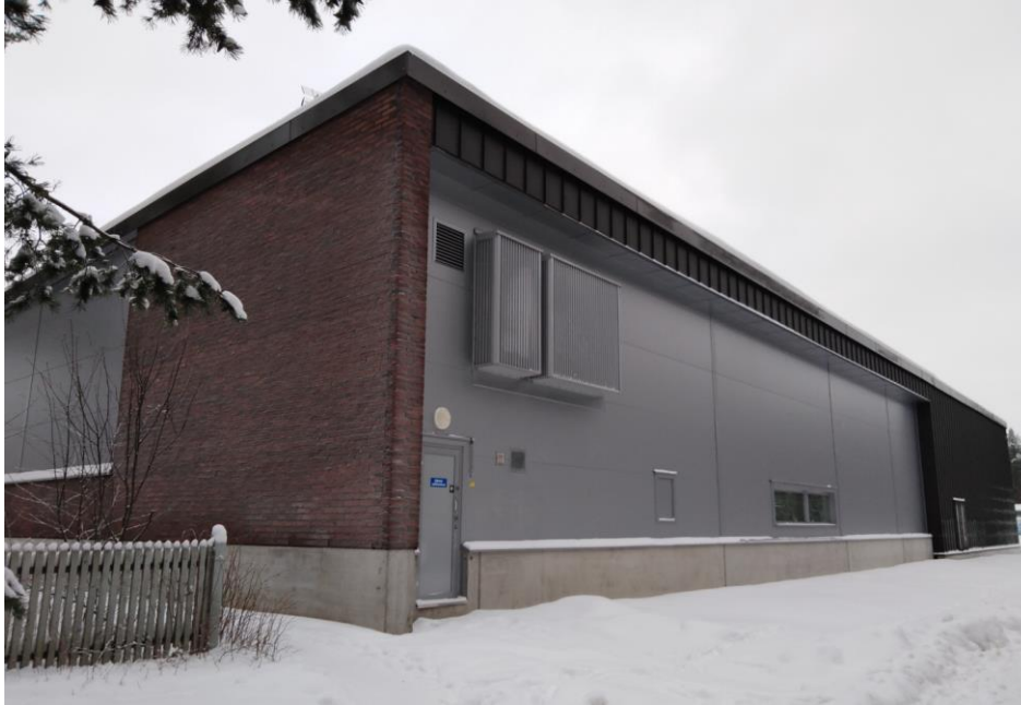
Kuva 49 Rakennuksen läntinen takajulkisivu on pääosin vaaleanharmaata, mutta lastauslaiturin ja yläosan osalta mustaa teräsohutlevyä. Pohjoinen julkisivu on eteläisen kanssa lähes identtinen.
