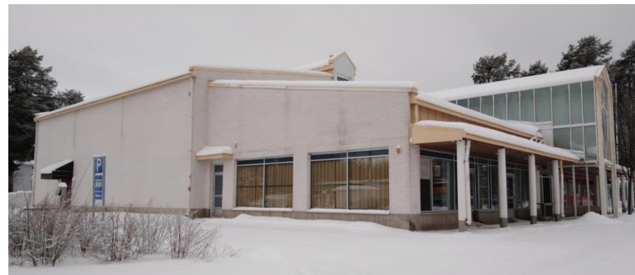
Kuva 45 Eteläinen julkisivu on vastapuolista pelkistetympi. Vasemmalla oleva yhtenäinen ikkunaton rakennusmassa lienee pitänyt sisällään squashkentän tarvitsemat tilat.
