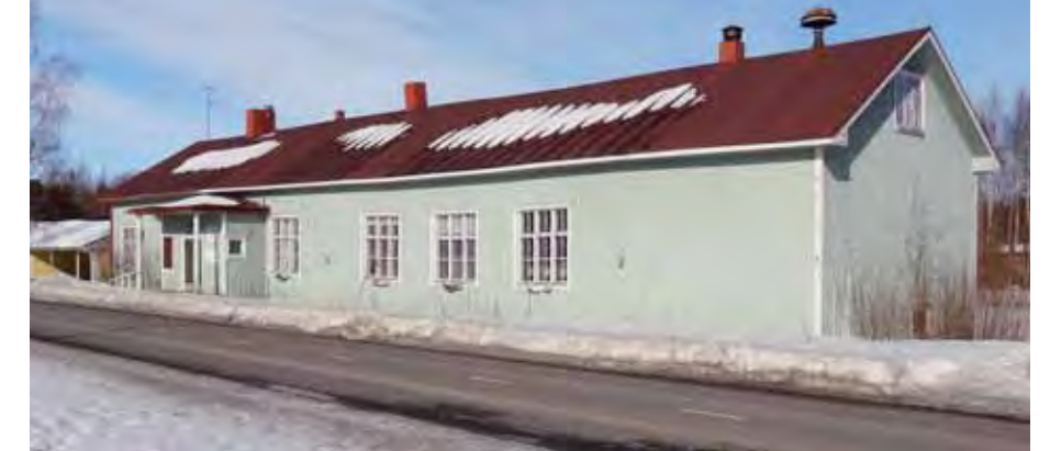
Repolantien varren kunnostusta vaille olevia vanhoja rakennuksia. Ylempi on korttelin 3002 Kerhola ja alin on korttelin 3005 entinen myymälärakennus.
