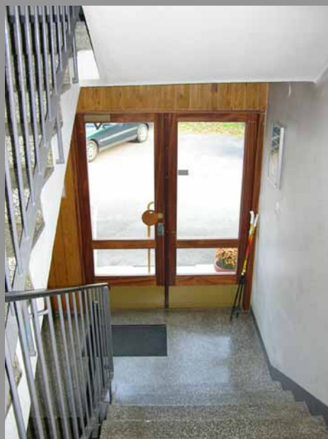
Kuvat 225-226. 1950-luvun porrashuone: sementtimosaikkiportaat ja vaneripintaiset laakaovet.
