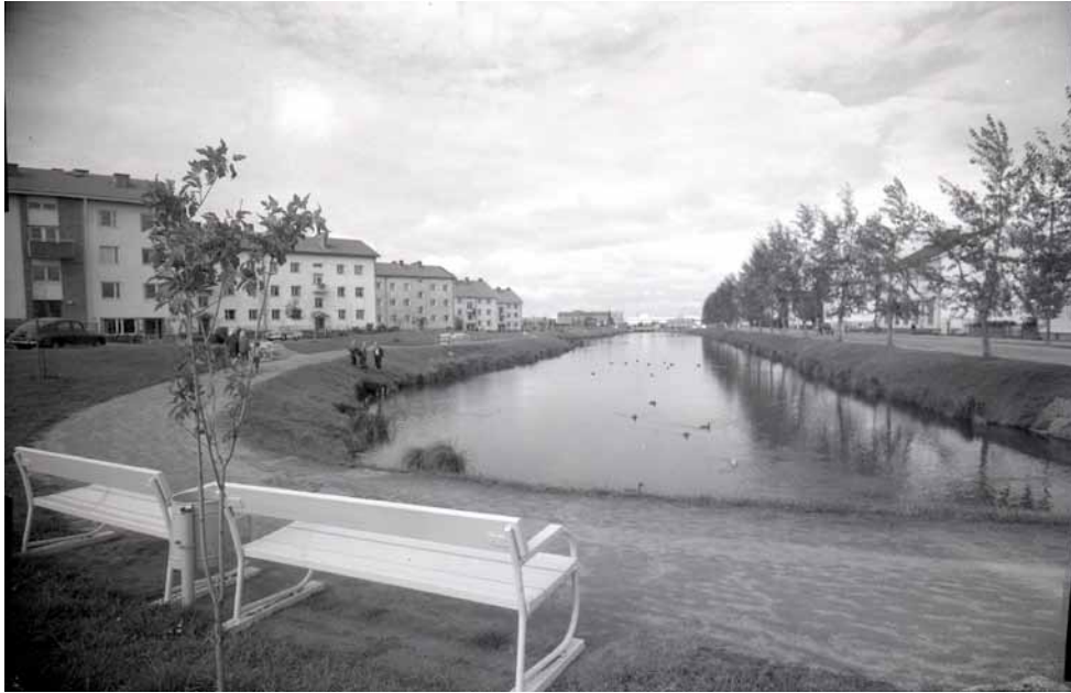
Kuvat 42-43. Kaupunginoja vuonna 1968 ja vuonna 2014. Suvantokadun kerrostalot näkyvät vasemmalla. Kaupunginojan yli on rakennettu silta hieman eri linjauksella kuin aiempi maavarainen tie. Rak-silan puolelta on talot purettu ja ruhtinaanpoppelirivi ja rantakäytävä poistettu Kainuuntien rakentamisen vuoksi. (Kuva 42: Pohjois-Pohjanmaan museo, Uuno Laukan kokoelma)
