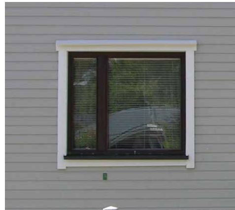
Kuvat 264-265. Ikkunat on vaihdettu ja ikkunajako on muuttunut. Jälleenrakennuskaudella ikkunoiden puitteet maalattiin valkoisiksi. Ruskeat puitteet edustavat myöhempiä tyyli-ihanteita.
