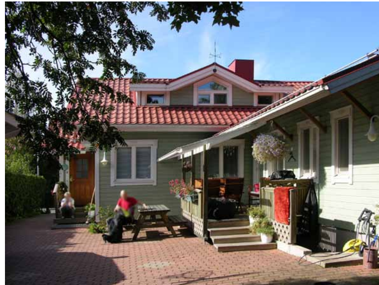
Kuva 152. Korjausten myötä rakennus edustaa enemmän 1990-luvun kuin jälleerakennuskauden tyyli-ihanteita.
