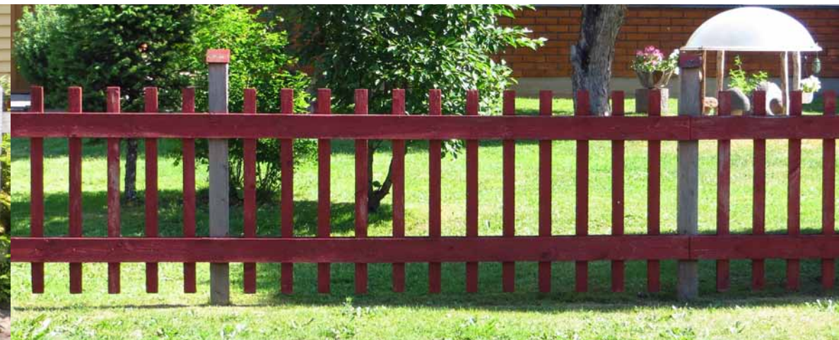
Kuva 101. Perinteinen Karjasillan aitamalli on punamullan värinen rima-aita. Aidan mitasuhteet vaihtelevat hieman eri aidoissa ja pystytolpiksi oli aitamallissa useita vaihtoehtoja.
