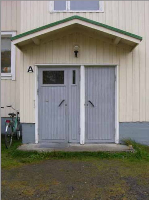
Kuvat 209-210. Puukerrostalojen sisäänkäynnit on yleensä suojattu pienillä katoksilla. Myöhemmin rakennetuissa taloissa porrashuoneen tuuletusparveke suojaa sisäänkäyntiä. Vasemmanpuoleisessa kuvassa alkuperäinen puuovi on säilynyt, oikeanpuoleisessa ovi on vaihdettu uuteen metallioveen.
