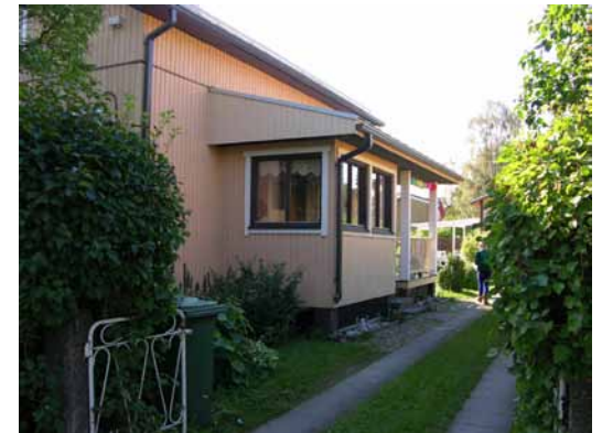
Kuva 127. Monessa rakennuksessa kuistin detaljit ovat 1960–70-luvuilta.
