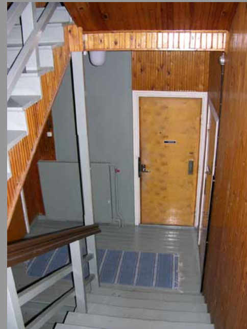
Kuvat 211-212. Porrashuoneita, joissa jälleenrakennuskauden materiaalit ovat säilyneet: maalatut puuportaat ja -kaiteet, lakatut tai maalatut pystypaneloidut seinät ja vaneri- tai paneelipintaiset laakaovet.
