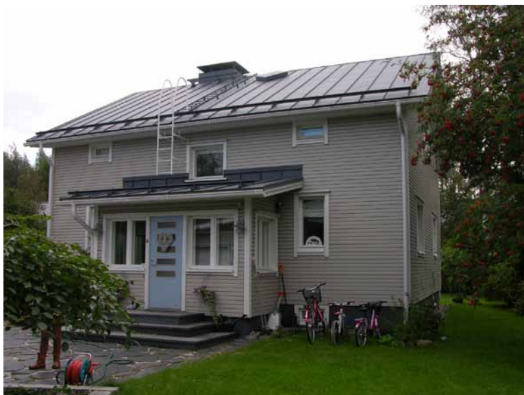
Kuva 188. Rakennukseen on lisätty jälleenrakennuskauden tyylinen kuisti.
