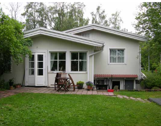
Kuva 109. Rakennusta on laajennettu. Alkuperäistä talotyyppiä ei enää hahmota.
