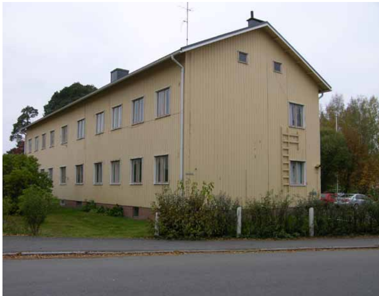
Kuva 207. Kaupunginarkkitehti Martti Heikuran hyvin säilynyt kolmiporrashuoneinen puukerrostalo.
