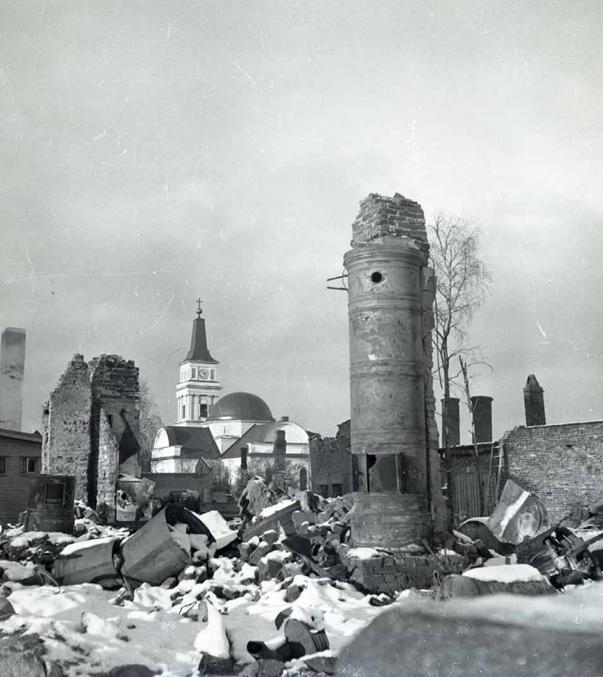
Kuva 6. Jälleenrakentamisen lähtökohdat: pommitetut kaupungit ja karjalaisevakot vailla asuntoa. Kuva Oulusta Asemakadulta 25.2.1944 suurpommituksen jälkeen. (Pohjois-Pohjanmaan museo, Uno Laukan kokoelma)
