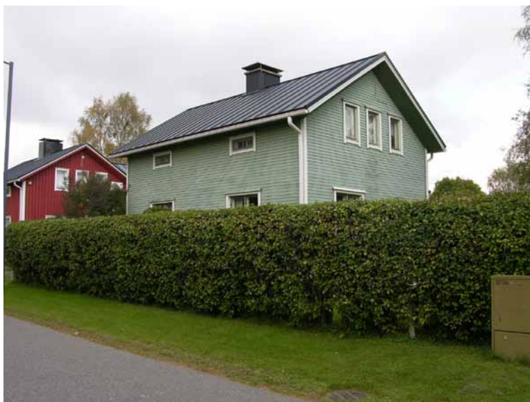
Kuvat 153-154. Rakennus on edelleen verhouksen suuntaa lukuun ottamatta ulkoa alkuperäispiirustusten mukainen.
