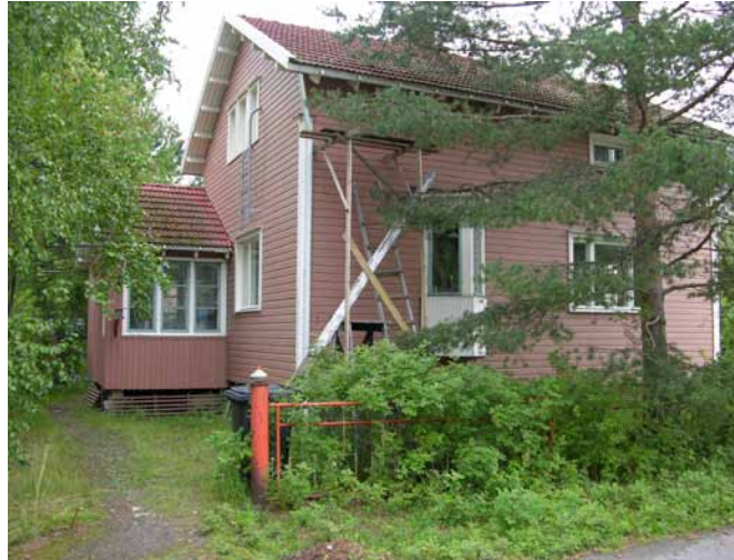
Kuvat 117-118. Alkuperäistä pientä asevelitaloa on laajennettu moneen otteeseen.
