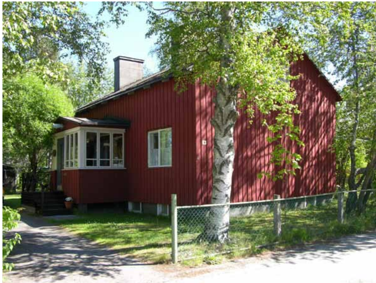
Kuva 111. Ennallistaen korjattu rakennus, jossa pystyrimalaudoitus on palautettu ja kuisti säilytetty kylmänä tilana.
