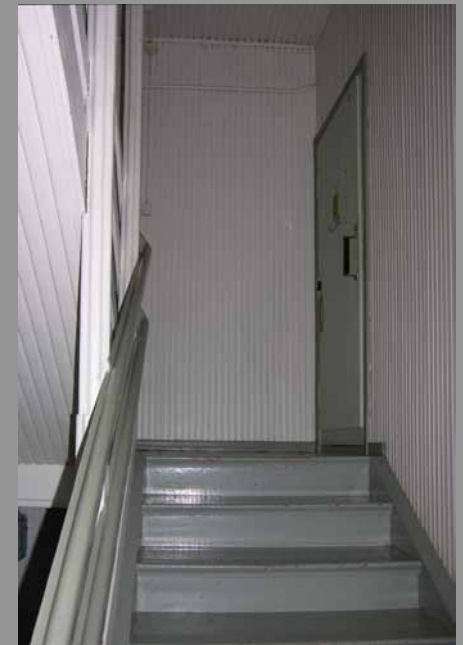
Kuvat 211-212. Porrashuoneita, joissa jälleenrakennuskauden materiaalit ovat säilyneet: maalatut puuportaat ja -kaiteet, lakatut tai maalatut pystypaneloidut seinät ja vaneri- tai paneelipintaiset laakaovet.
