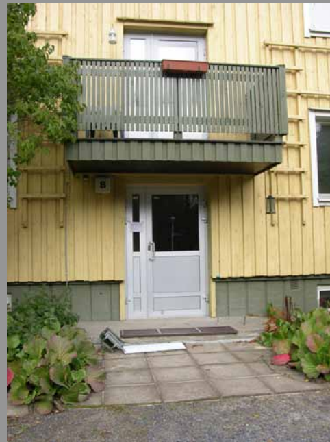
Kuvat 209-210. Puukerrostalojen sisäänkäynnit on yleensä suojattu pienillä katoksilla. Myöhemmin rakennetuissa taloissa porrashuoneen tuuletusparveke suojaa sisäänkäyntiä. Vasemmanpuoleisessa kuvassa alkuperäinen puuovi on säilynyt, oikeanpuoleisessa ovi on vaihdettu uuteen metallioveen.
