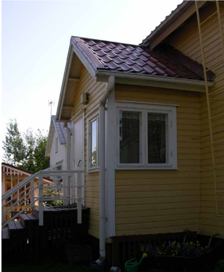
Kuva 161. Melkein kaikissa rakennuksissa kuisti on muutettu umpinaiseksi, usein pian rakentamisen jälkeen.
