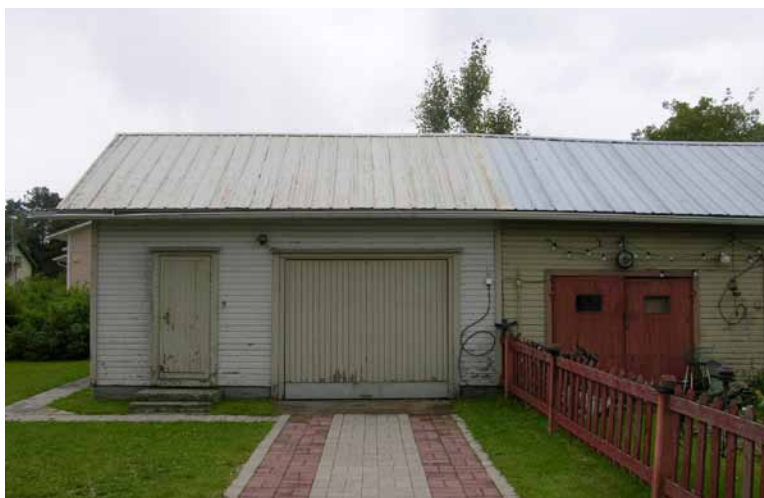
Kuva 230. Piharakennukseen on tehty autotalli luultavasti melko pian rakentamisen jälkeen. Tontilla säästyti tilaa, kun piharakennukset rakennettiin naapurin kanssa yhteen.
