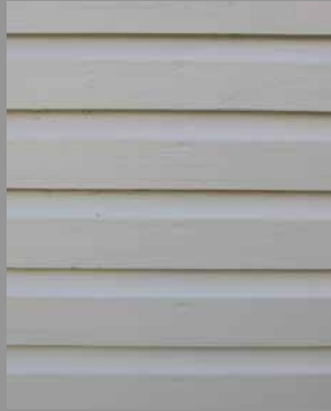
Kuvat 10-13. Vaalea vaakapaneeli on yleisin verhoustapa Karjasillan rakennuksissa. Alkuaan monissa taloissa on ollut punamullattu pystyrimalaudoitus.
