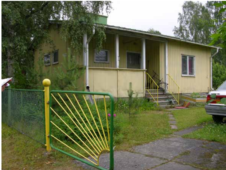
Kuva 107. Rakennusta ei ole laajennettu: vanha avokuisti on säilynyt. Kaiteen ristikkorimakaidet on vaihdettu vanerikaiteeseen.
