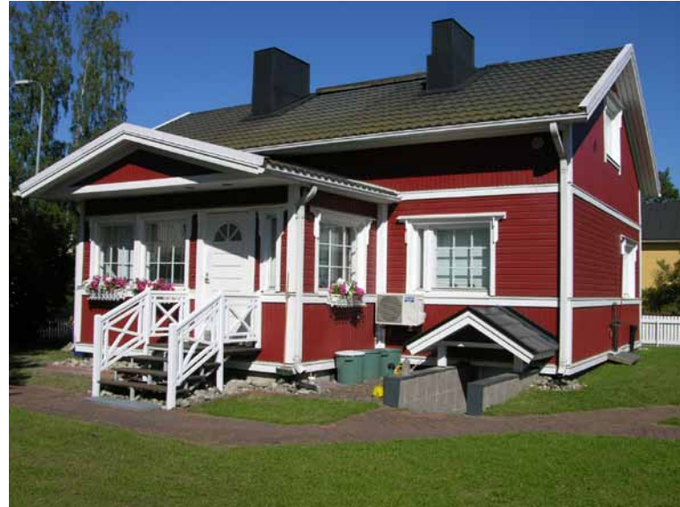
Kuva 113. Ikkunoiden vaihtaminen ja kenttälaudoitus ovat muuttaneet rakennuksen tyyliä.
