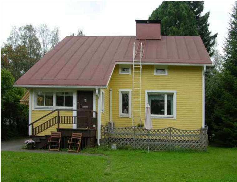
Kuva 181. Pihajulkisivu. Kuistin porras on alkuaan ollut suoraan pihalle päin.
