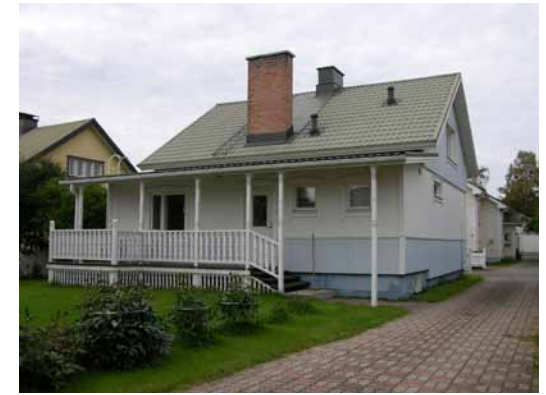
Kuva 126. Laajennus ja kenttälaudoitus muuttavat rakennuksen ilmettä.
