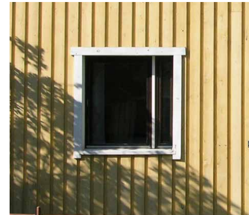
Kuvat 264-265. Ikkunat on vaihdettu ja ikkunajako on muuttunut. Jälleenrakennuskaudella ikkunoiden puitteet maalattiin valkoisiksi. Ruskeat puitteet edustavat myöhempiä tyyli-ihanteita.
