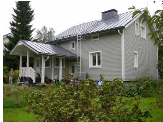
Kuva 177. Kuistia on laajennettu.
