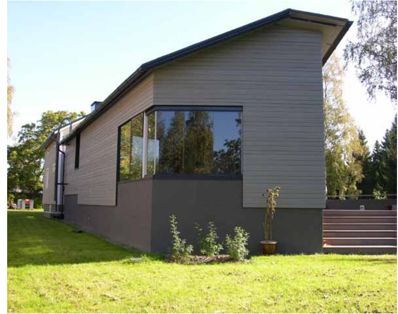
Kuva 191. Laajennus 2010-luvulta on kooltaan päärakennuksen veroinen.
