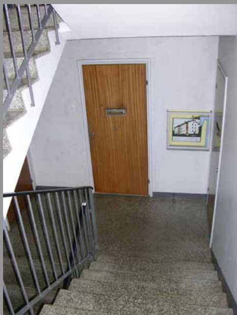
Kuvat 225-226. 1950-luvun porrashuone: sementtimosaikkiportaat ja vaneripintaiset laakaovet.
