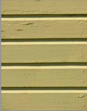
Kuvat 10-13. Vaalea vaakapaneeli on yleisin verhoustapa Karjasillan rakennuksissa. Alkuaan monissa taloissa on ollut punamullattu pystyrimalaudoitus.
