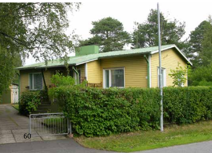
Kuva 110. Ruotsalaistalolle tyypillinen laajennus 50-luvulta: alkuperäinen avokuisti on muutettu huoneeksi ja talon keskelle on rakennettu uusi avokuisti.
