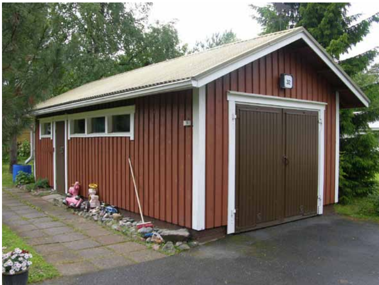
Kuva 236. Autotalli ja varasto, tyyppi E 1980-luvulta.
