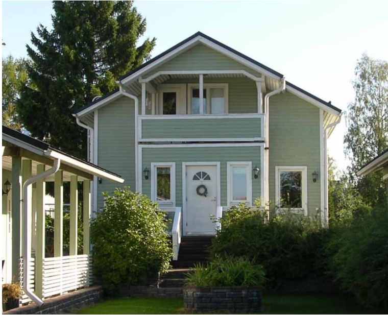
Kuva 190. Rakennuksiin on tehty parvekkeita parin viime vuosikymmenen aikana. Parvekkeiden tyyli viittaa usein 2000-luvun valmistaloihin.
