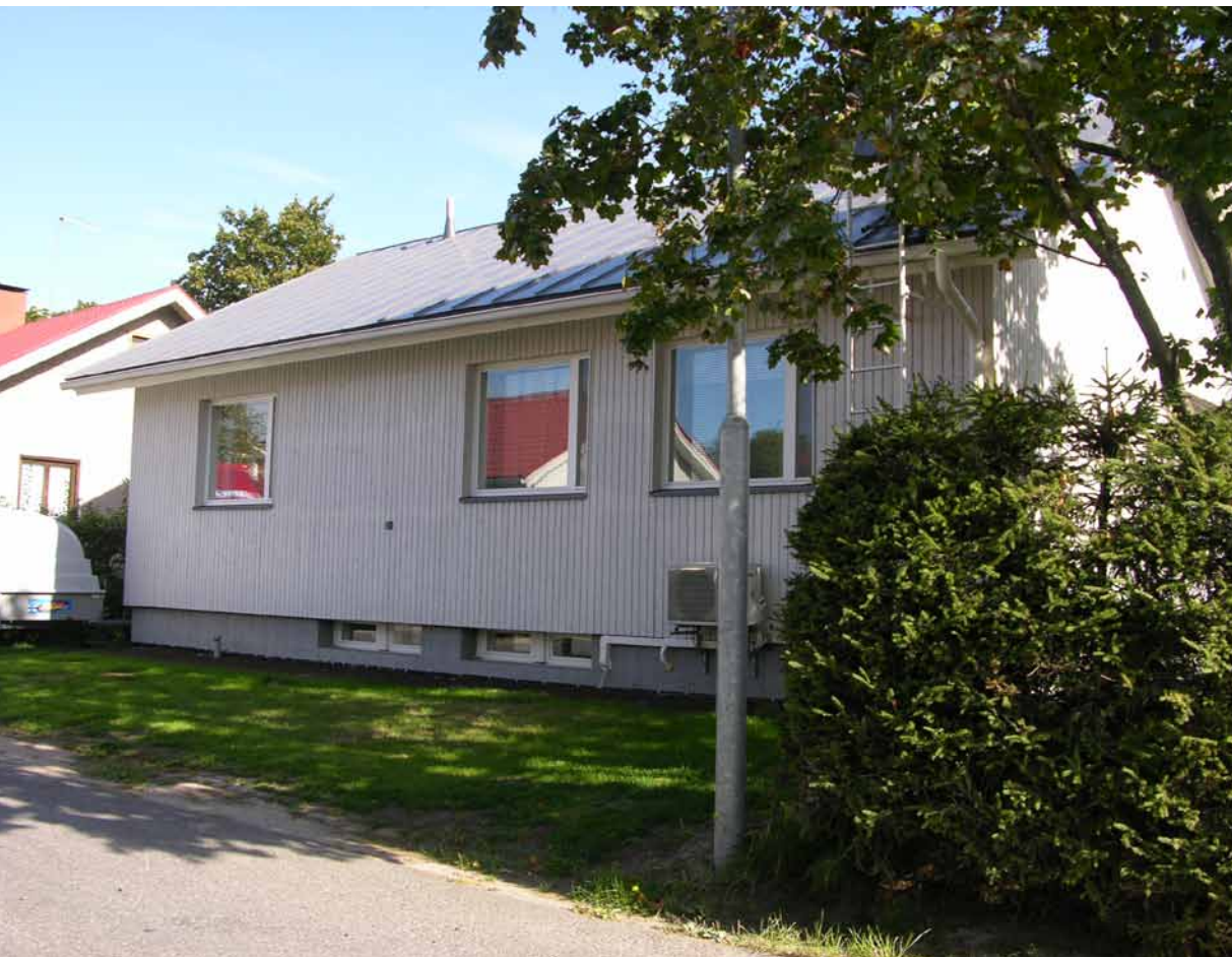
Kuva 200. Mittakaavaltaan rakennus vastaa kadun varressa olevia Lapin rakennus Oy:n tyypitaloja, mutta ikkunajako ei noudattele talotyyppiä.
