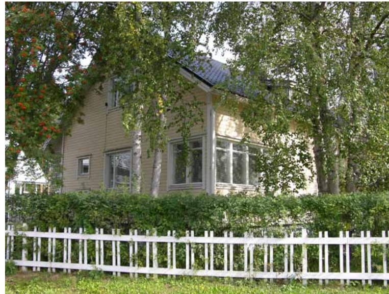
Kuva 174. Kulmauksen ikkunaa ei liene alkuaankaan toteutettu piirustusten mukaisena ulkonevana erkkeri-ikkunana.
