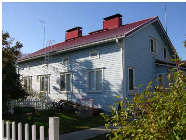
Kuva 171. Talotyypin katujulkisivun ikkunajako on säännöllinen.
