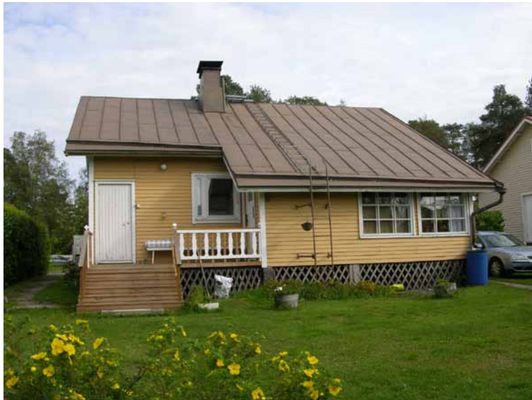
Kuva 144. Rakennuksessa on säilynyt paljon jälleenrakennuskauden piirteitä. Kuiten muissakin talotyypin edustajissa, sisäänkäynti on muutettu ruutuikkunoiden viereltä rakennuksen sisänurkkaan, ja samaan yhteyteen on rakennettu terassi.
