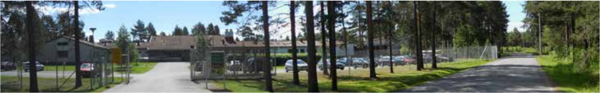
Näkymä esikuntarakennuksen H1 portilta
