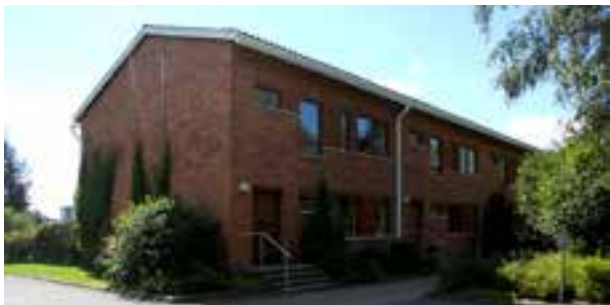
Henkilökunnan rivitalo, Hintantie 60
