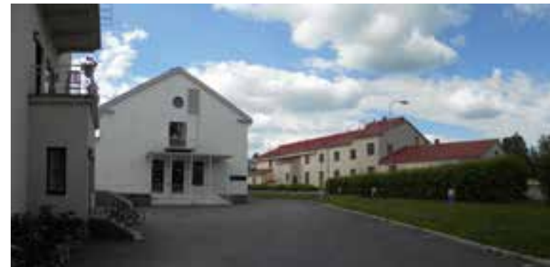
Talusrakennus PT1 ja lämpökeskusrakennus PT7
