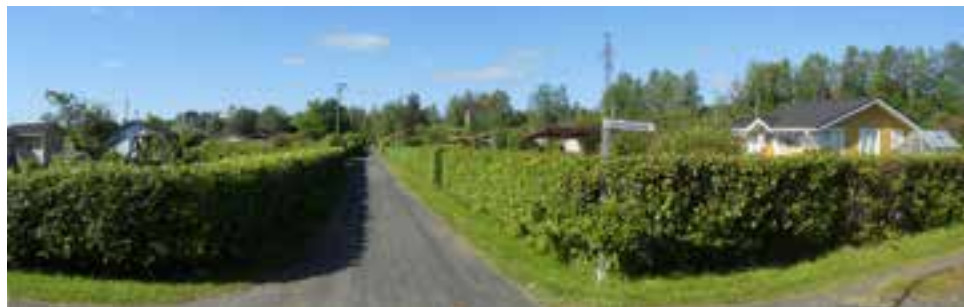
Näkymä Helmililjantien ja Äimäruohontien risteyksestä pohjoiseen
