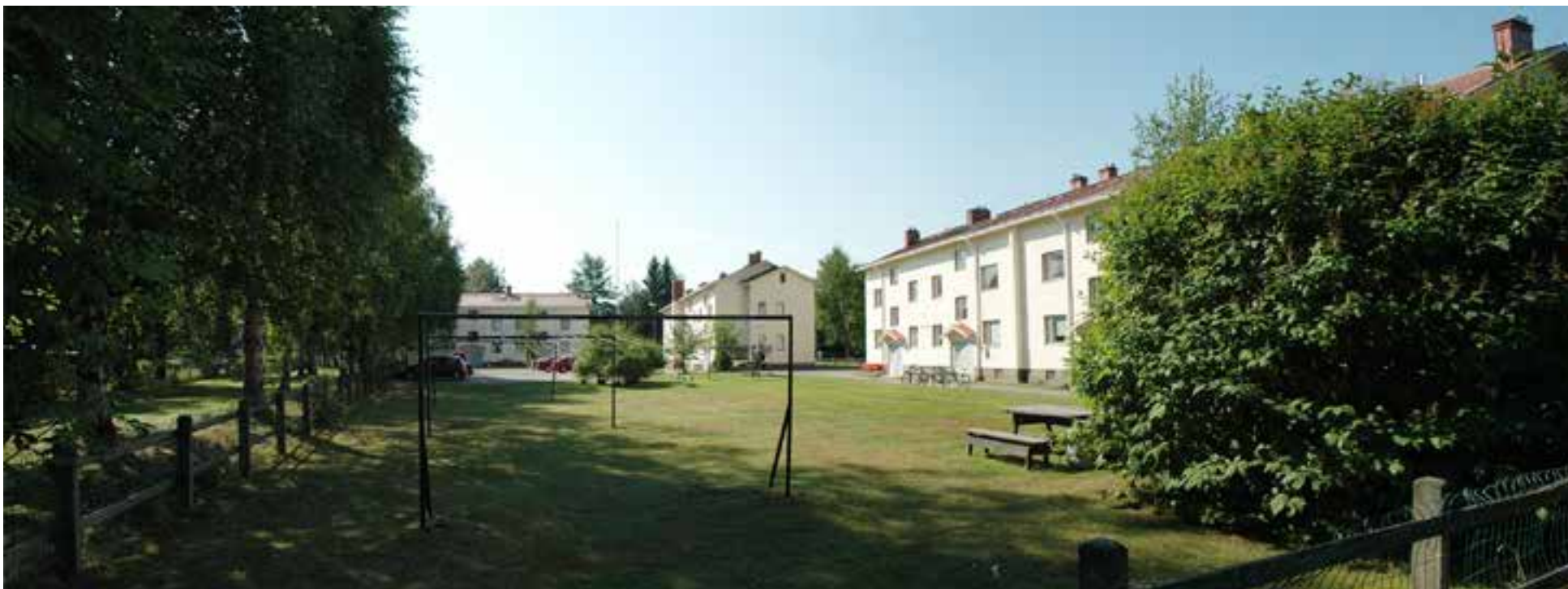
Varikkotien kerrostalojen pihanäkymä
