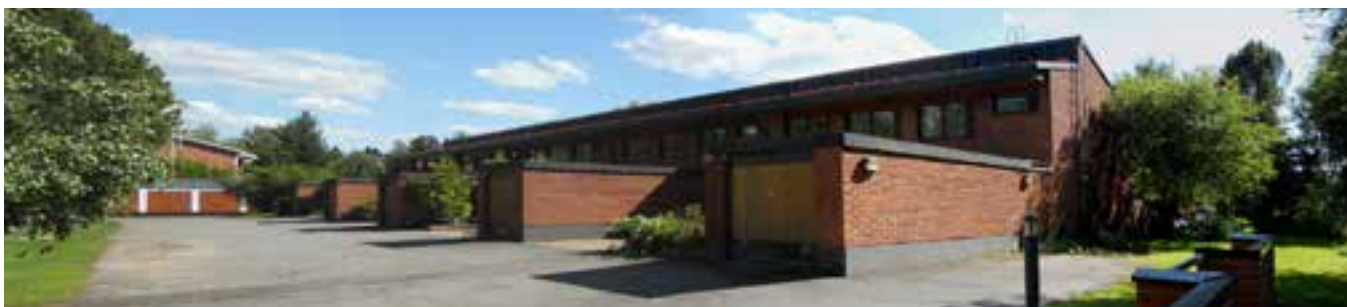
Henkilökunnan rivitalo, Hintantie 58
