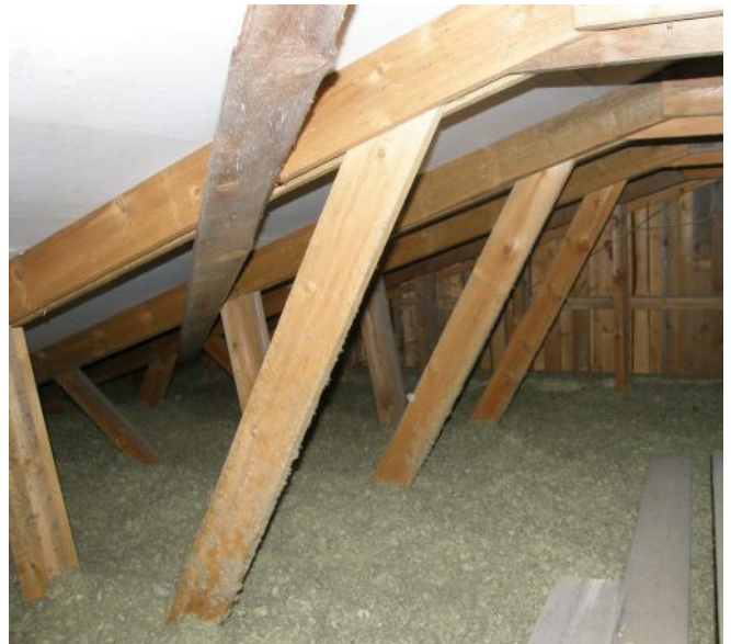
Yläpohja on lisäeristetty puhallettavalla mineraalivillaeristeellä
