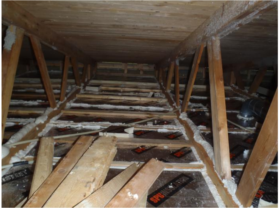
Alkuperäinen vuotava höyrynsulkukerros (tervapaperi) on poistettu ja tilalle on asennettu alumiinipintainen polyuretaanilevy höyrynsulkulevyksi. Kuva on otettu ennen varsinaisen lämmöneristyskerroksen lisäämistä.
