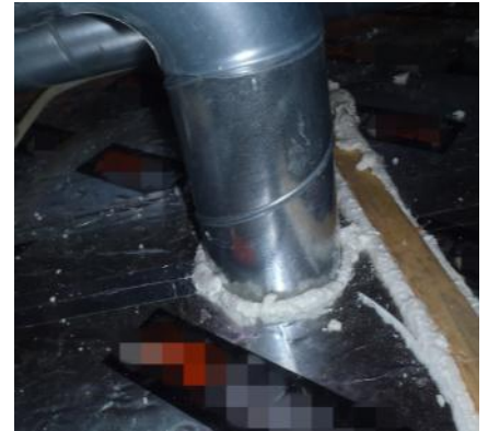
Hyvin toteutettu IV-putken tiivistys (yläpohjan puolelta).
