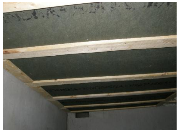
Rossipohjan kokonaan uusittu tuulensuojalevy
