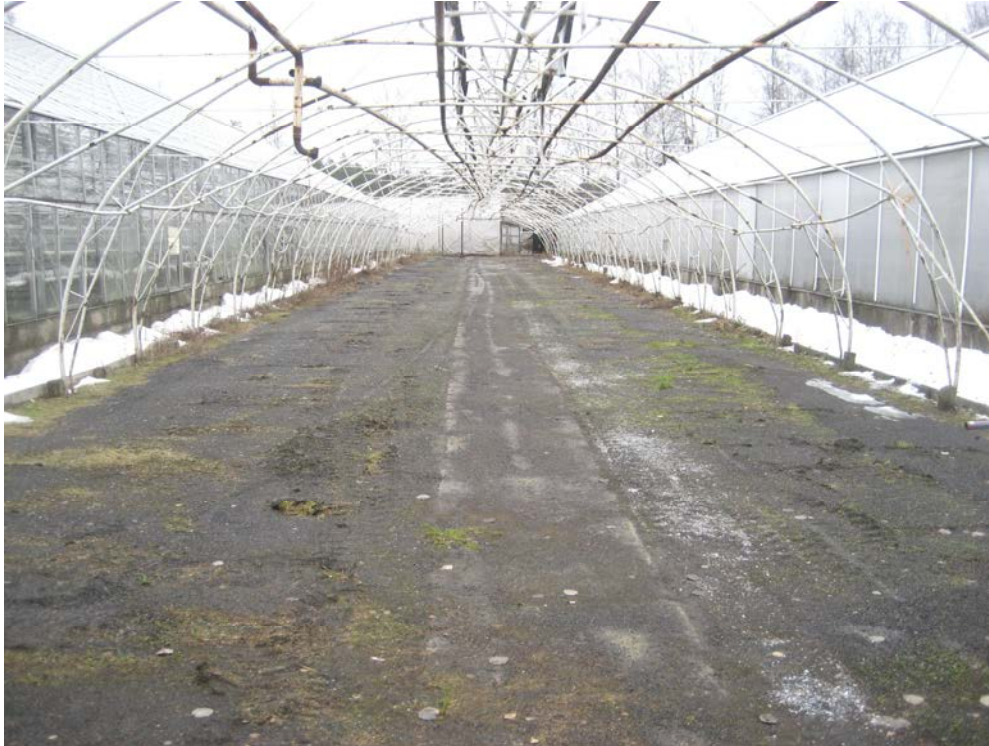
Kuva 7. Kaarihalli, rullattava muovikalvo, kivituhkapinnalla.
