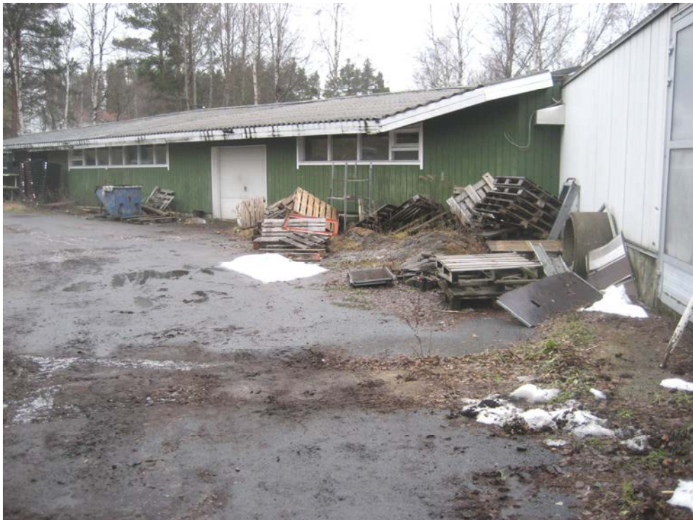
Kuva 10. Talous- ja varastorakennuksen ja kasvihuoneen kulmaus.
