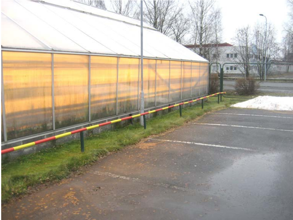
Kuva 3. Piha-alueen kasvihuonetta vasemmalla, kuvaussuunta etelään.
