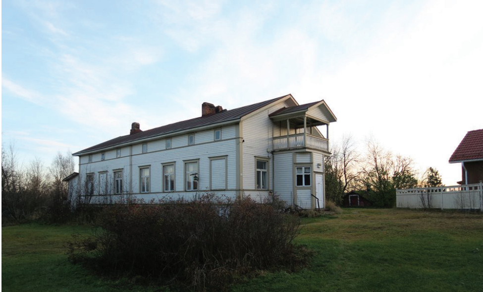
Kuva 24. Hintan päärakennus säilytetyn peltonäkymän päässä asutusmaellä Hintanmutkassa. Kosonen, 2015. (Kioski-tietokanta, kohderaportti)
