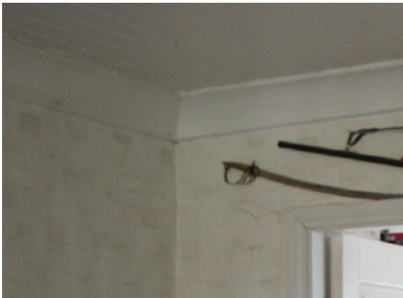
Kuva 63. Vinttikamarin leveät kattolistat ovat todennäköisesti alkuperäiset. Säilynoja, 2019.
