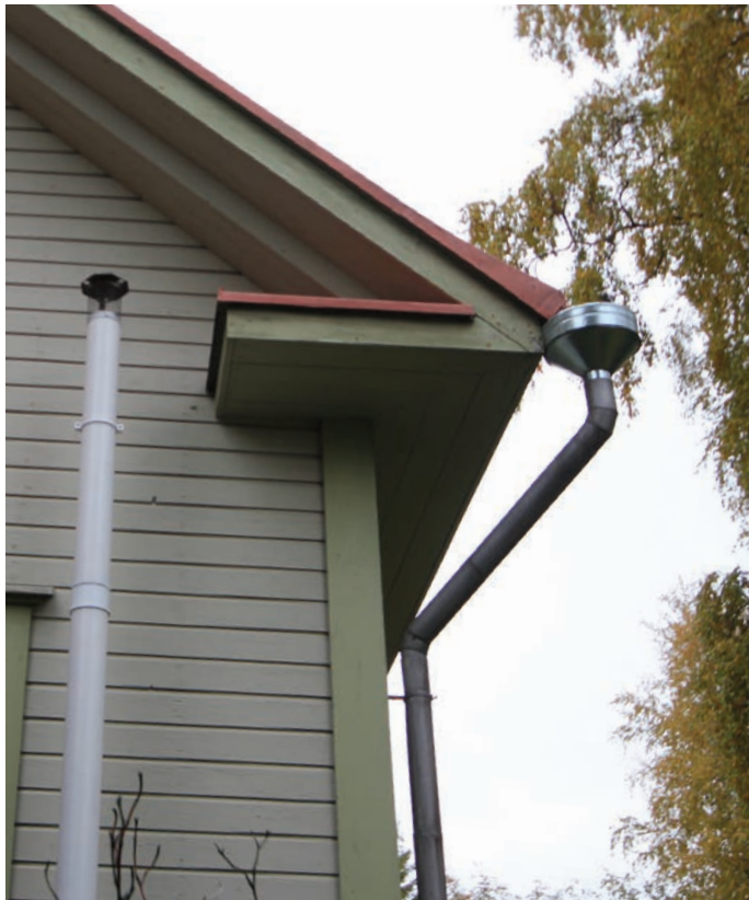
Kuva 111. Päätyräystästaite ja julkisivuun tuotu kuivakäymälän tuuletusputki. Säilynoja, 2019
