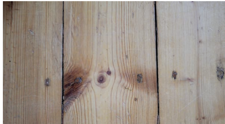
Kuva 64. Vintin puutapein kiinnitetyt lattialaudat. Säilynoja, 2019
