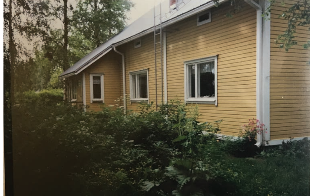
Kuva 78. Jokirinne, Törmälän/Långin, rannan puolelta kuvattuna. Taakse rakennettu kuisti ja katemateriaali vaihdettu punaisesta huovasta konesaumapeltiä imitoivaan sinkittyyn aaltopeltiin. Villa Långin yksityiset kuva-arkistot. Vuosi ei tiedossa.
