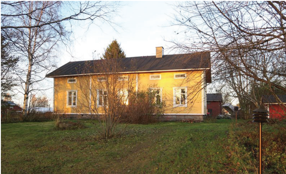
Kuva 26. Kariniemen päärakennus jokityräältä. Kosonen, 2015. (Kioski-tietokanta, kohderaportti)
