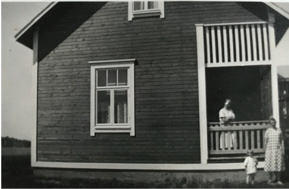
Kuva 77. Jokirinne, päärakennus pian valmistumisensa jälkeen. Kuvassa myöhemmin umpeen rakennettu kusiti ja T-jaolliset korkeat kansallisromantiikan ikkunat. Villa Långin yksityiset kuva-arkistot. Vuosi ei tiedossa
