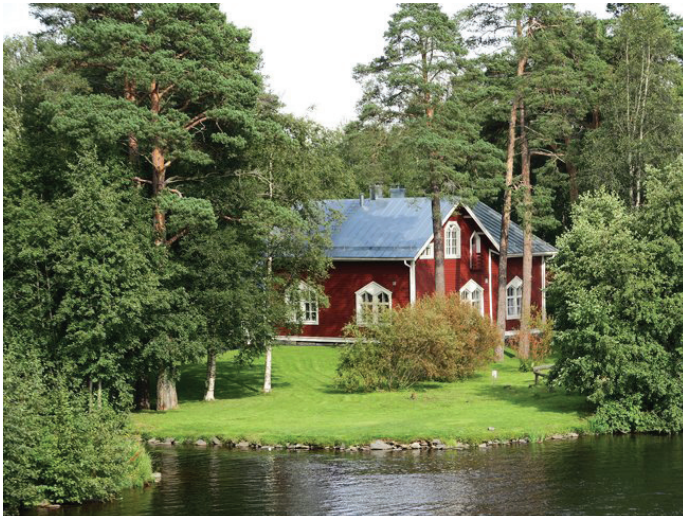
Kuva 50. Onnela. Kosonen, 2015. (Kioski-tietokanta, kohderaportti). Alexander Häggin rakennuttama jugend-tyylinen Onnela, mansardikattoinen Sointula, Viklundin Jyrkkäranta ja konttoripäälikkö Näyhän huvila Kotimökki (Syrjänen, Anneli 1993) muodostavat Nokkalaan yhä pitkälti nähtävillä olevan kokonaisuuden.
