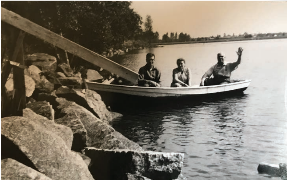
Kuva 48. Villa Långin yksityiset arkistot. Kuva rannasta patoamisen jälkeen. Vuosiluku ei tiedossa. Oulujoella oli hyvät hiekkarannat aina padon rakentamiseen asti kunnes nostetun patoaltaan reunoille tuotiin suuria lohkokiviä. Näitä Hintan rantojen lapset käyttivät uimakinä (Jussila, haastattelu 2019).
