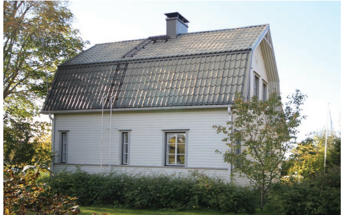
Kuva 71. Asuinrakennus kaupungin tontilta kuvattuna. Kuvassa rakennuksen itäpääty. Säilynoja, 2019
