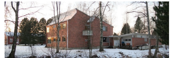
Kuva 29. Typpi Oy, Tehtaanjohtajan asunto, Alvar Aalto. Kosonen, 2014. (Kioski-tietokanta, kohderaportti)
