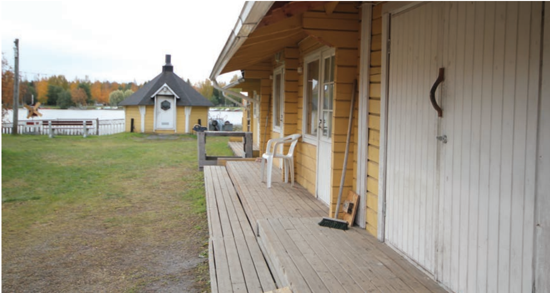
Kuva 91. Jokirinne, Kota, puutarhavarasto, pyöräpaja ja korunhiontapaja sekä puutyöpaja vasemmalta oikealle. Säilynoja, 2019
