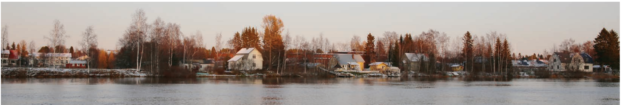
Kuva 56. Kohteet kuvattuna vastarannalta. Vasemmalla takana Hintan päärakennus ja oikealla Yrjänäisen päärakennus. Säilynoja, 2019.
