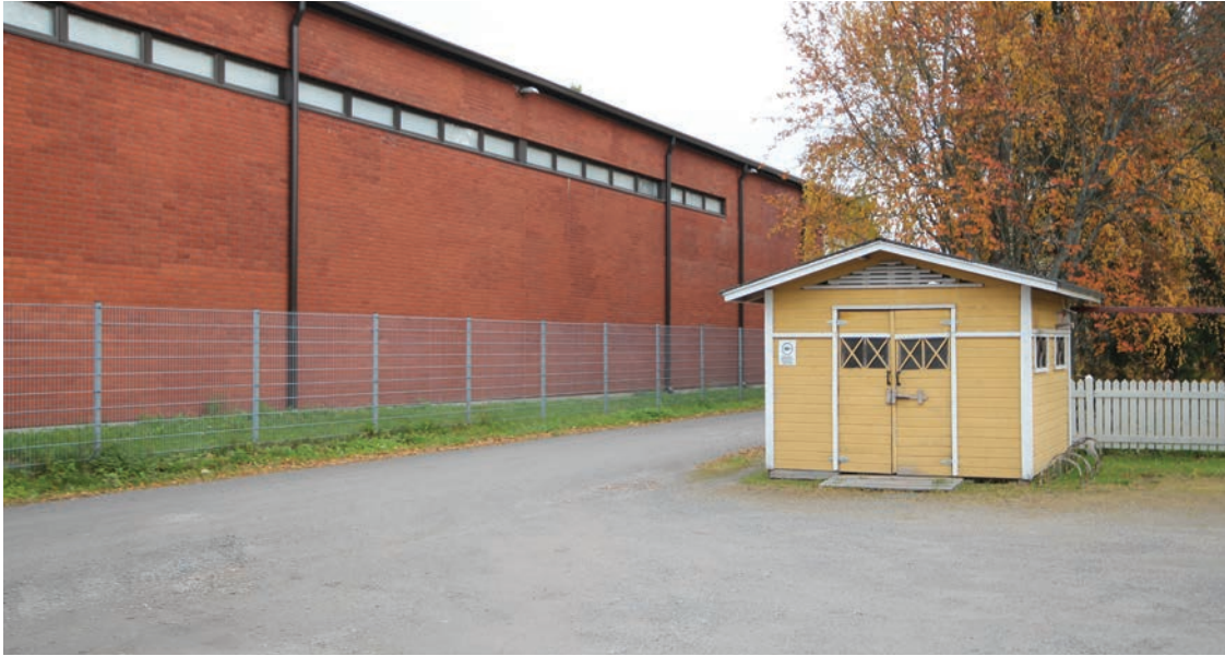
Kuva 89. Roskakatos ja taustalla vesilaitoksen punainen tiiliseinä. Säilynoja, 2019
