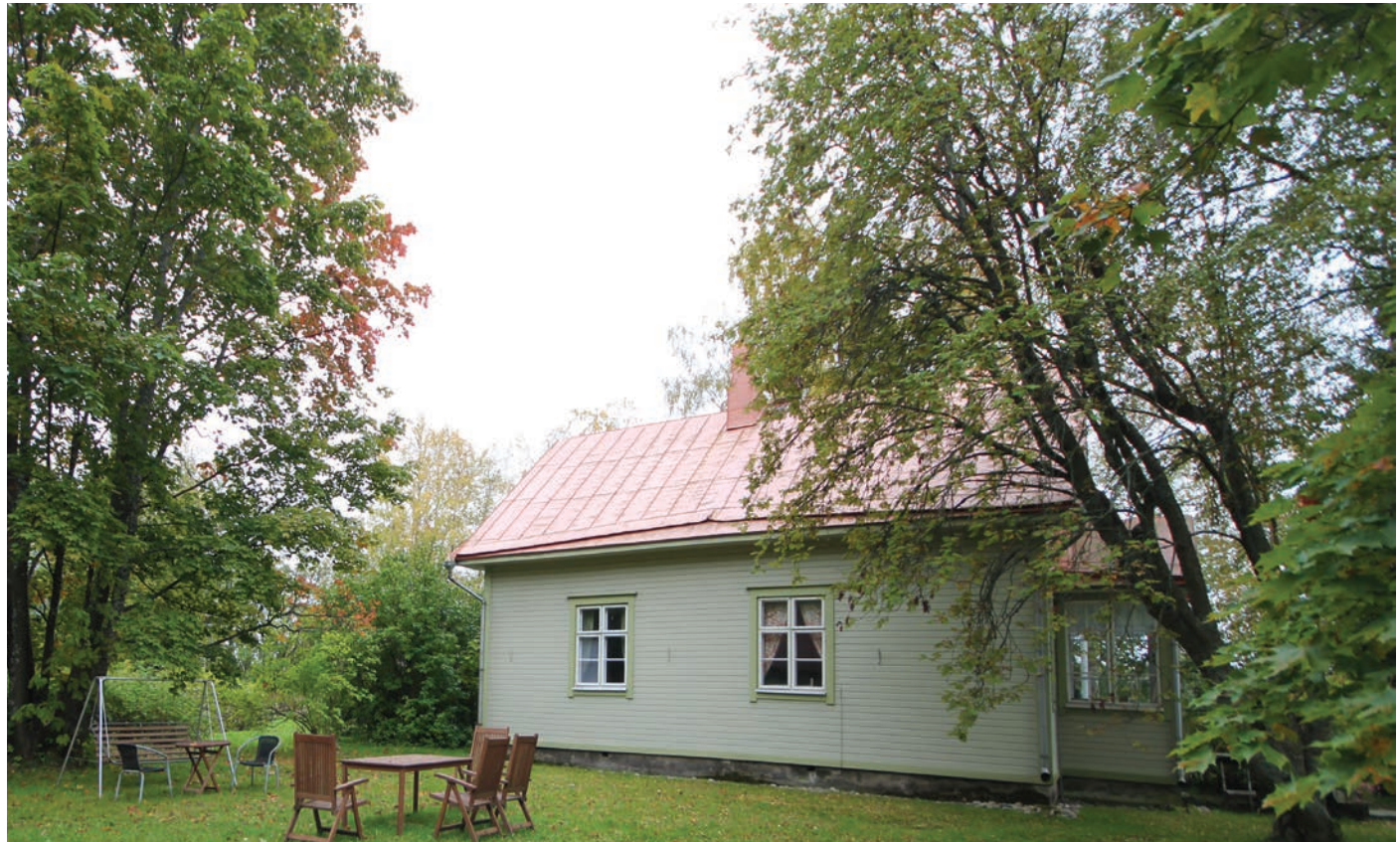
Kuva 112. Etupihan puoleinen julkisivu. Vasemmalla tuvan ikkuna ja oikealla kammarin ikkuna. Säilynoja, 2019
