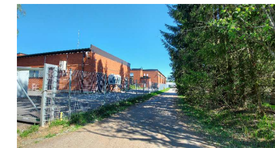
Kuva 5. Vesilaitoksen eteläseinusta ei sovi tyyliään ympäröivään maisemaan.
