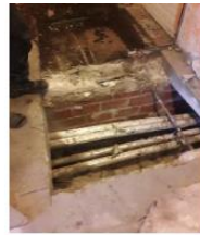
Korjaustöiden läpysä ja rämpi
