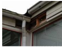
Korjaustöiden läpysä ja rämpi
