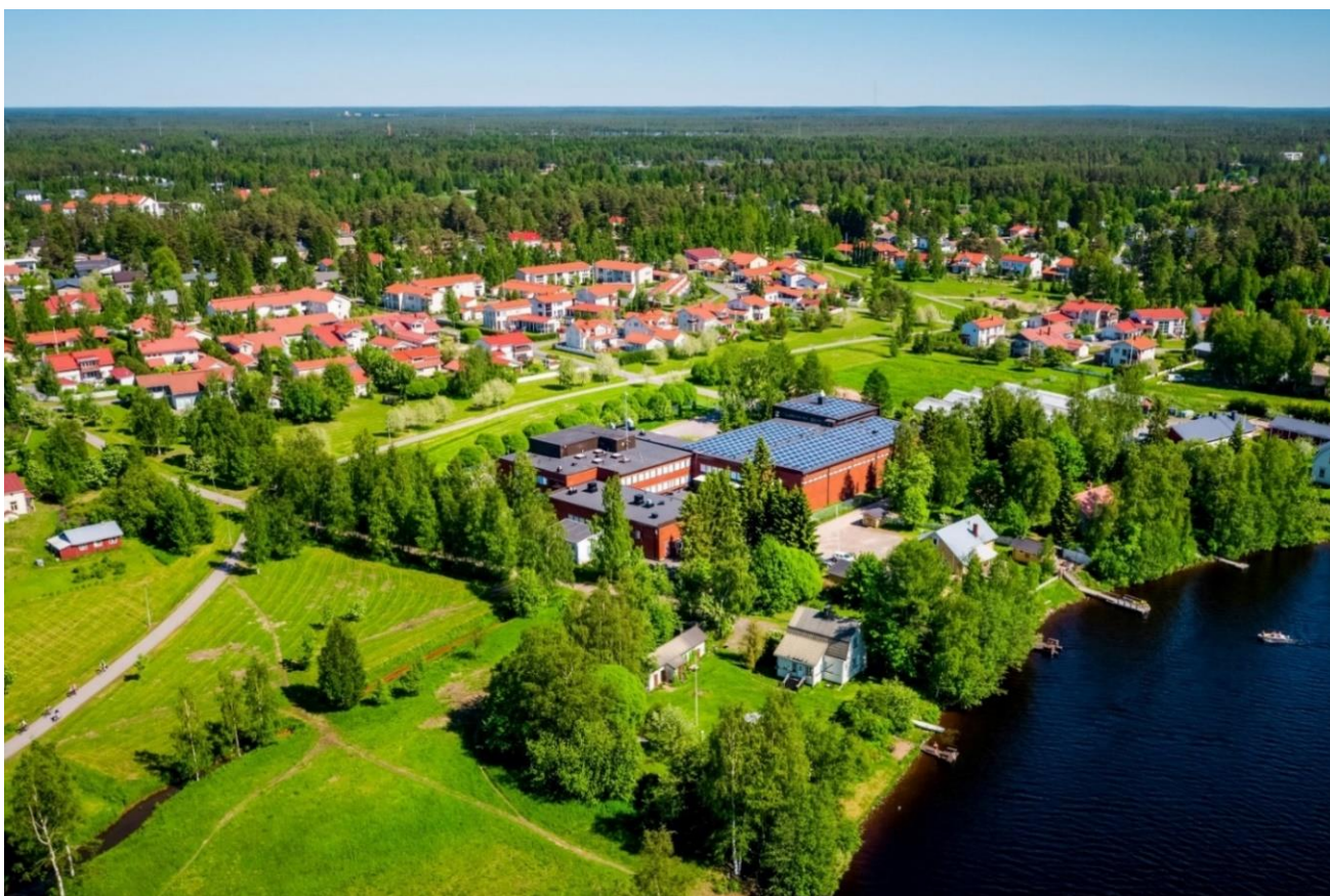
Kuva 1. Viistoilmakuva Hintan vesilaitoksesta ympäristöineen.
