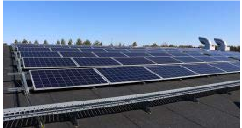
Vesi-Jatulin liikuntakeskukseen Haukiputaalle valmistui energiaremontti, jonka osana rakennuksen katolle asennettiin aurinkovoimala.
