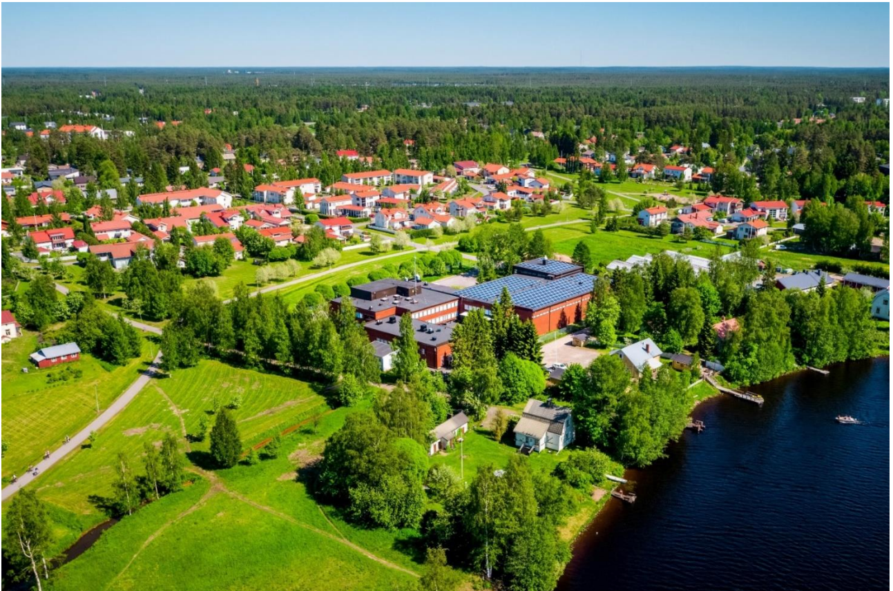
Kuva 1 Viistoilmakuva Hintan vesilaitoksesta
