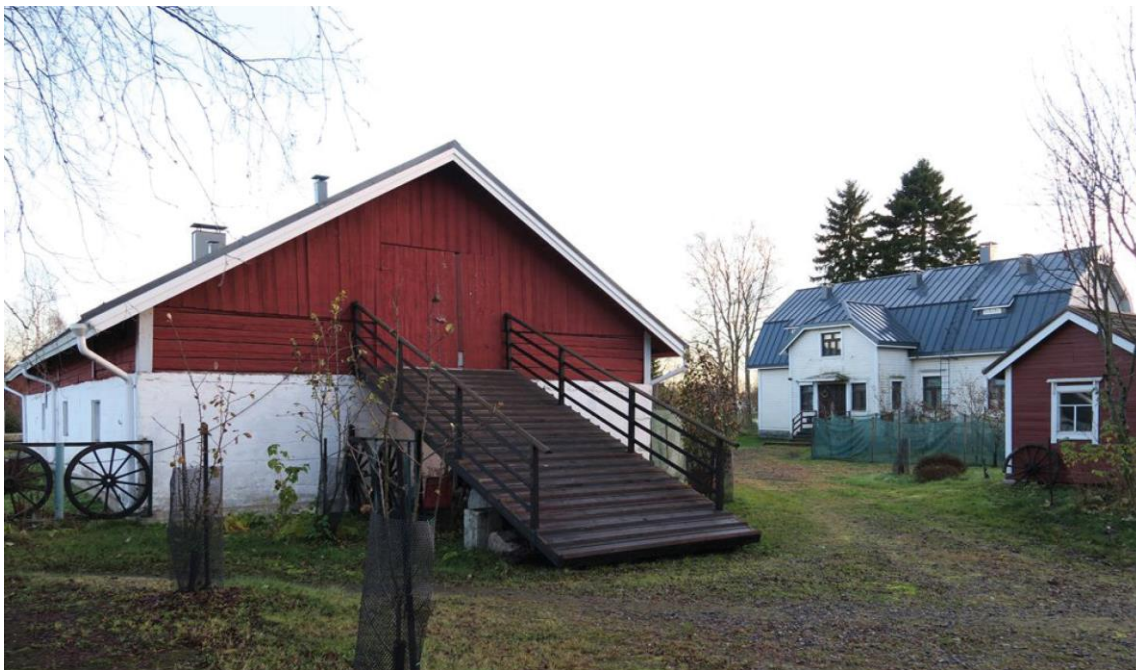
Kuva 25. Yrjänäisen Navetta, päärakennus ja aitta. Kosonen, 2015. (Kioski-tietokanta, kohderaportti)
